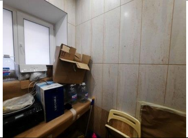
Фото № 16 – Внутреннее состояние помещения
