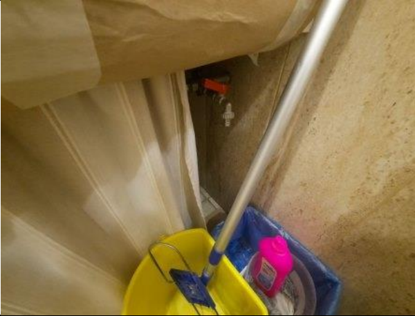
Фото № 15 – Внутреннее состояние помещения
