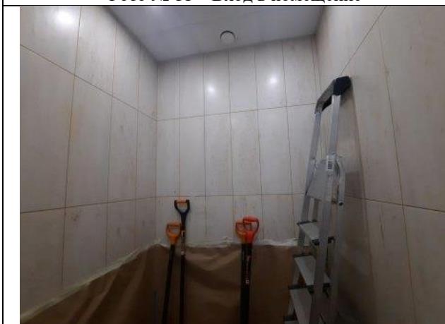
Фото № 13 – Внутреннее состояние помещения
