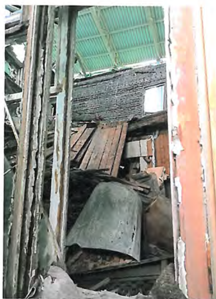
Фото 13. Вид через один из оконных проемов западного фасада внутрь здания
