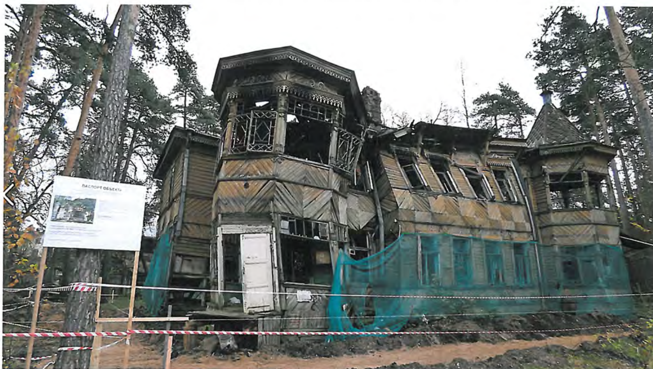
Фото 7. Западный фасад Объекта (сентябрь 2018 г.)
