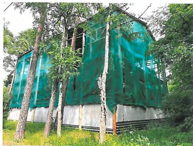
Фото 11. Вид на юго-западный угол каркаса
