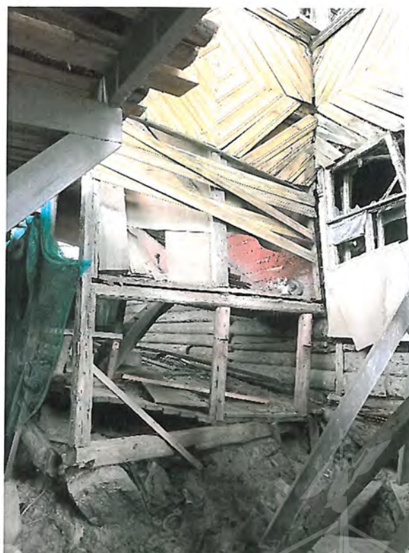
Фото 23. Вид на часть северного фасада
