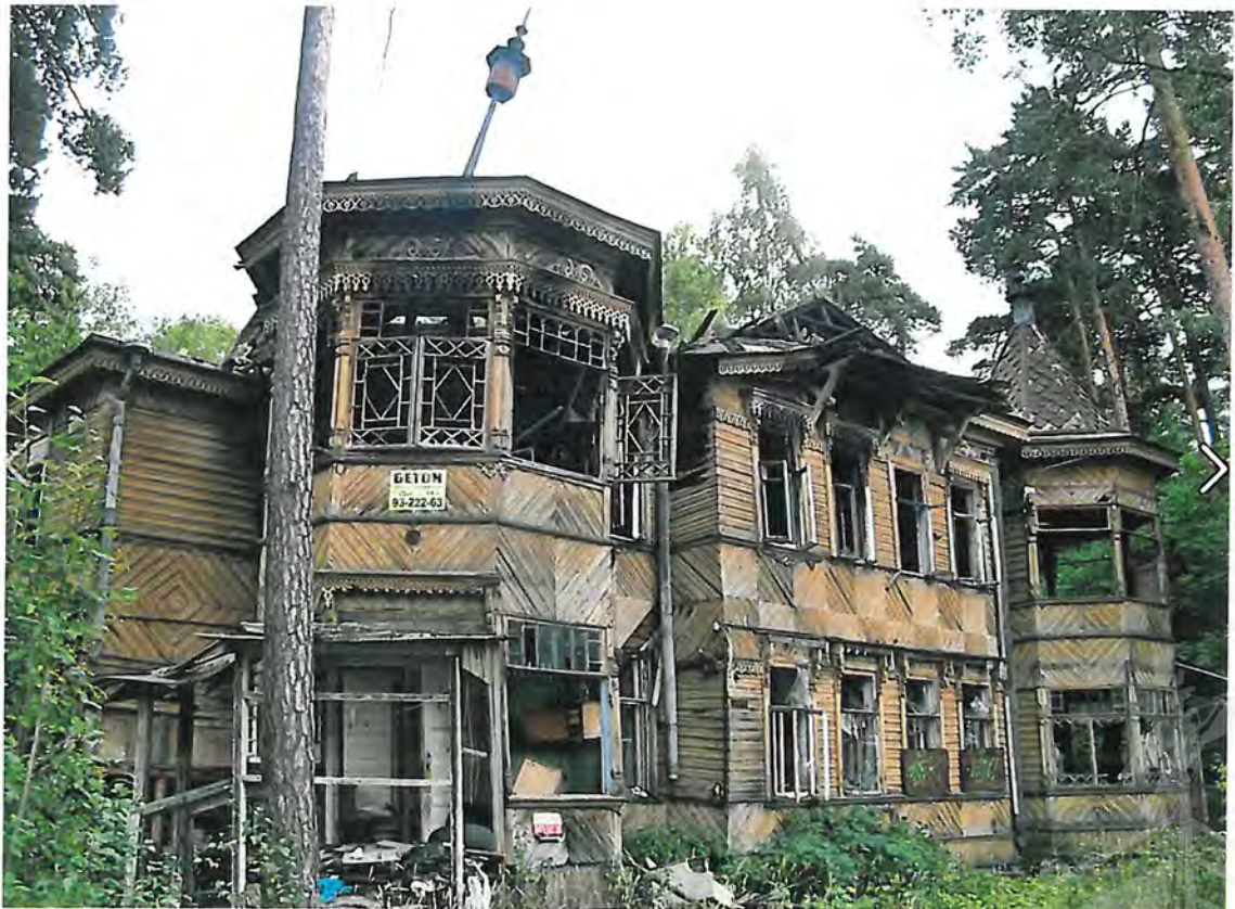
Фото 4. Западный фасад Объекта (13.09.2015 г.)
