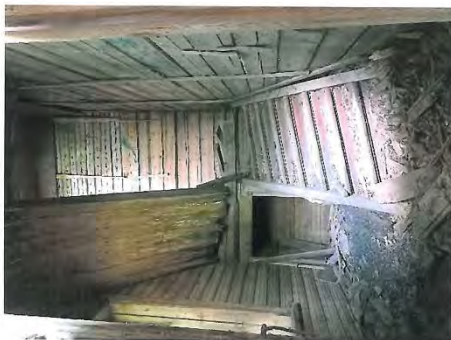
Фото 20. Вид на лестничные марши через крайний левый вход с восточного фасада
