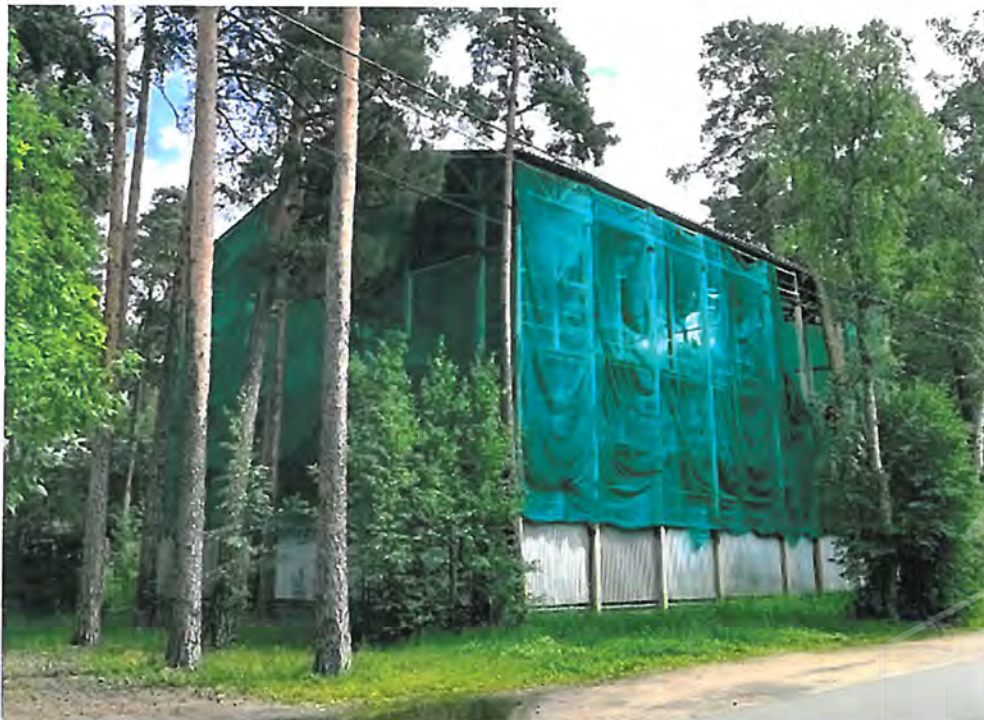
Фото 9. Вид на северо-западный угол каркаса
