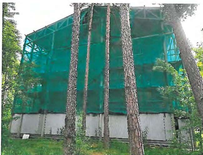
Фото 10. Вид на северный фасад каркаса
