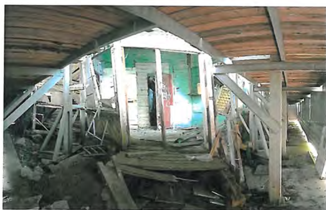
Фото 12. Панорамный вид на вход в северо-западный ризалит
