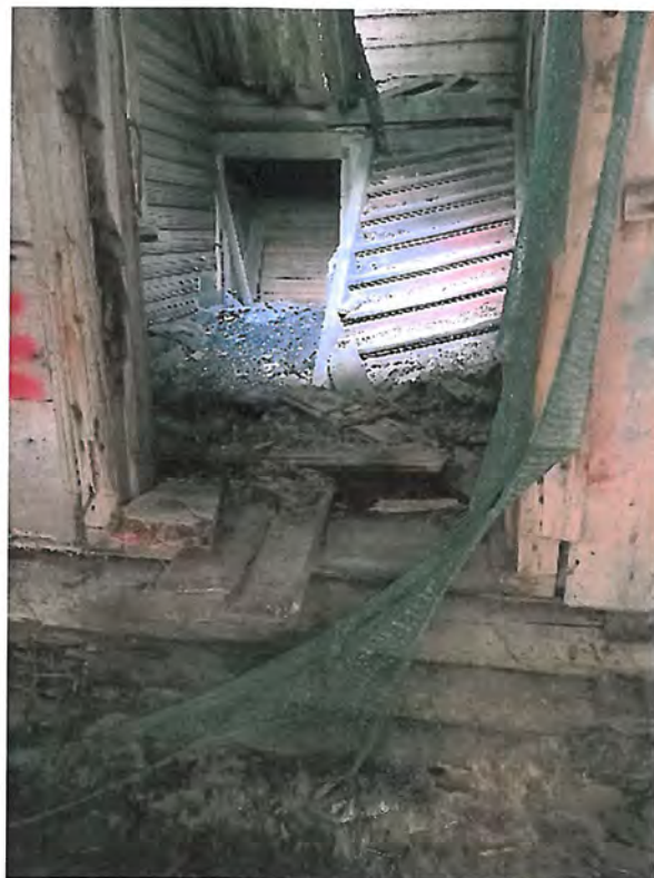
Фото 21. Вид на крайний левый вход с восточного фасада
