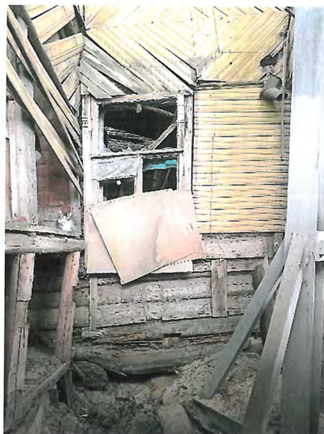
Фото 25. Вид на часть северного фасада с его фундаментной частью
