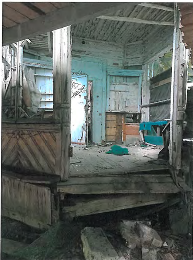
Фото 16. Вид на вход в юго-западный ризалит
