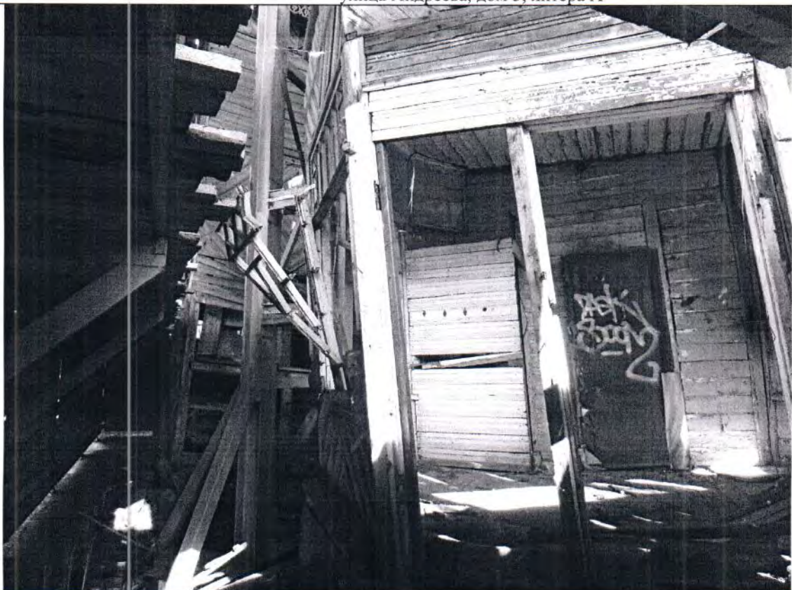
Описание: Вид на Объект
