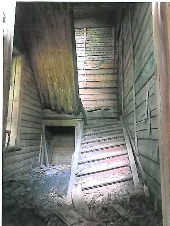
Фото 20. Вид на лестничные марши через крайний левый вход с восточного фасада
