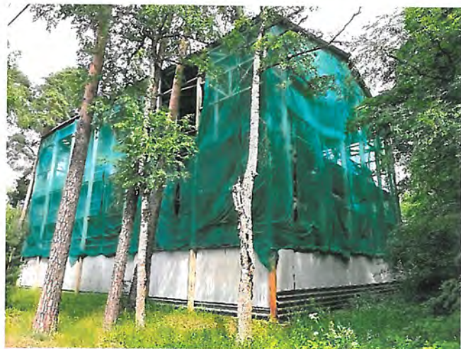
Фото 11. Вид на юго-западный угол каркаса
