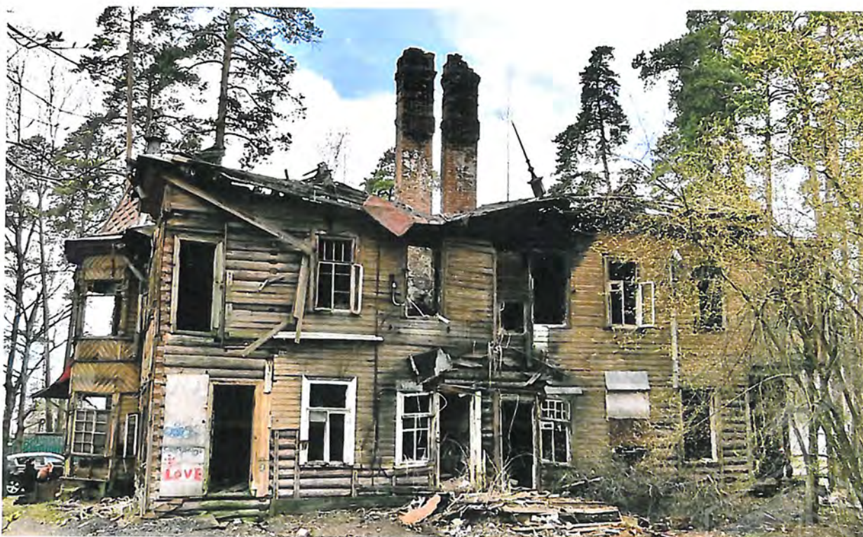
Фото 6. Восточный фасад Объекта (май 2017 г.)
