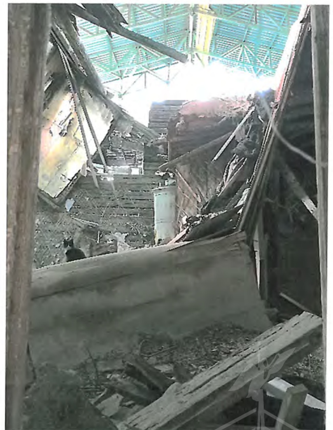
Фото 19. Вид через один из оконных проемов западного фасада внутрь здания
