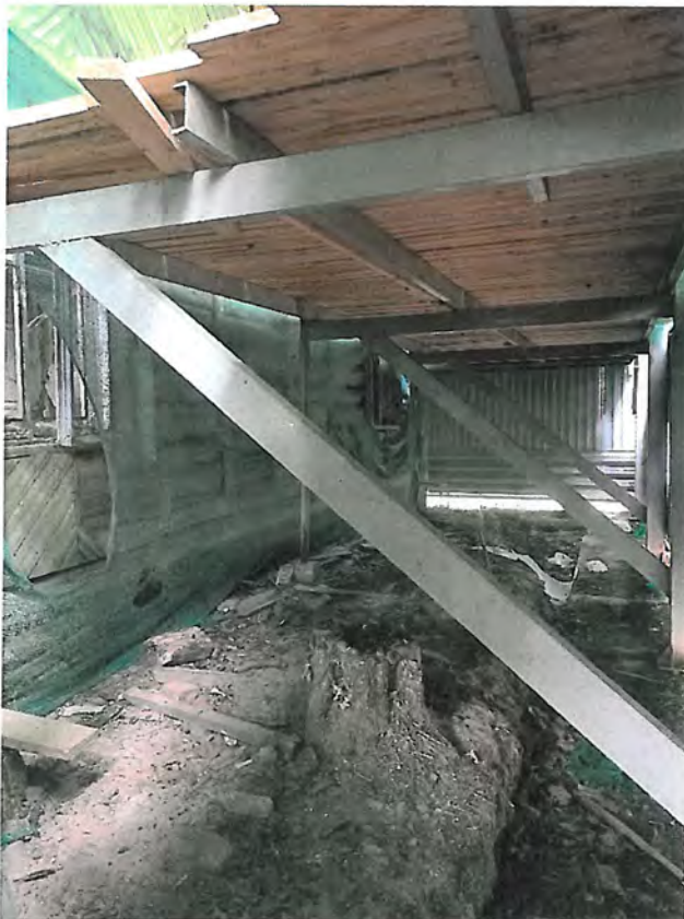
Фото 18. Вид на часть южного фасада
