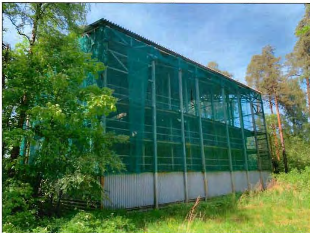
2. Общий вид объекта культурного наследия с юго-востока.
