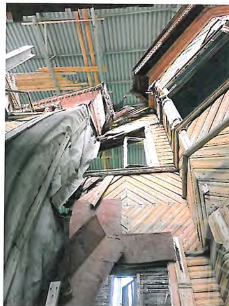
Фото 15. Вид на часть западного фасада и юго-западного ризалита
