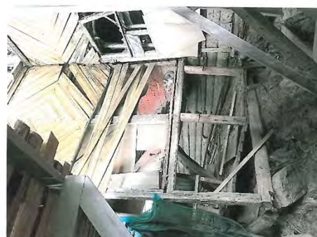
Фото 23. Вид на часть северного фасада
