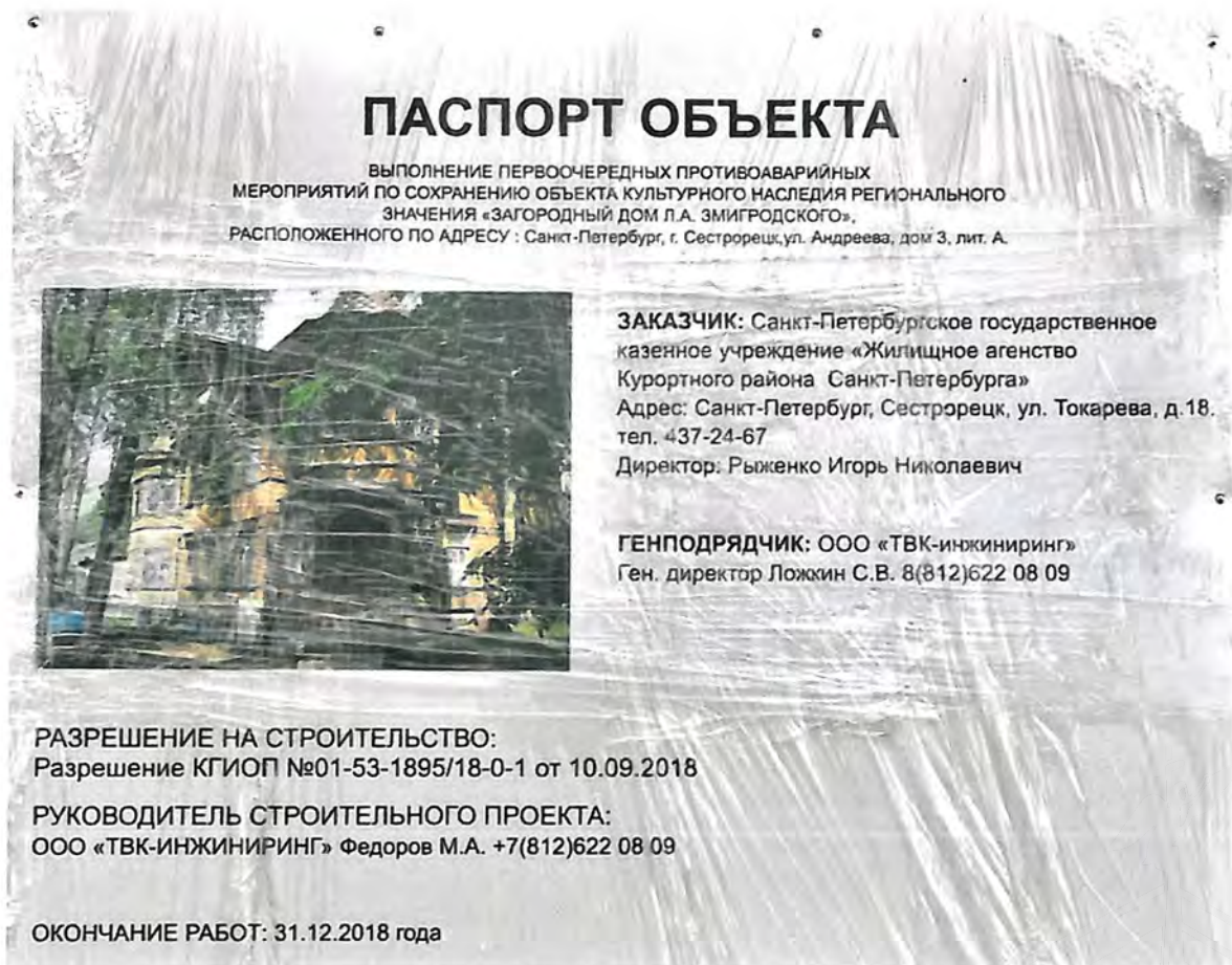
Фото 8. Первоочередные противоаварийные работы на Объекте (октябрь 2018 г.)
