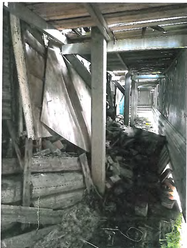
Фото 22. Вид на часть восточного фасада
