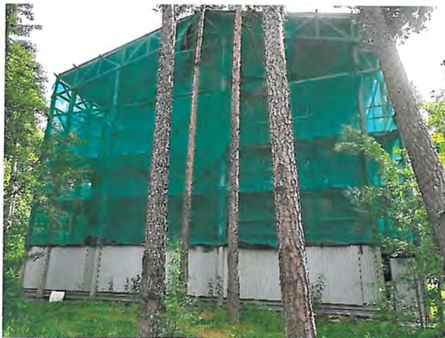
Фото 10. Вид на северный фасад каркаса
