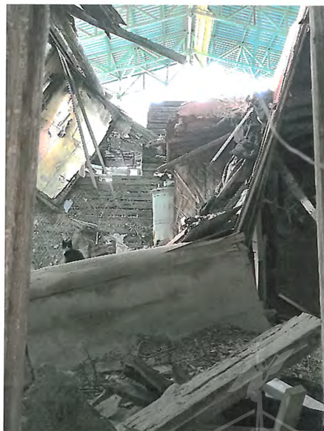
Фото 19. Вид через один из оконных проемов западного фасада внутрь здания
