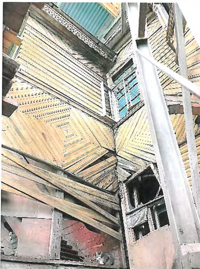
Фото 24. Вид на часть северного фасада
