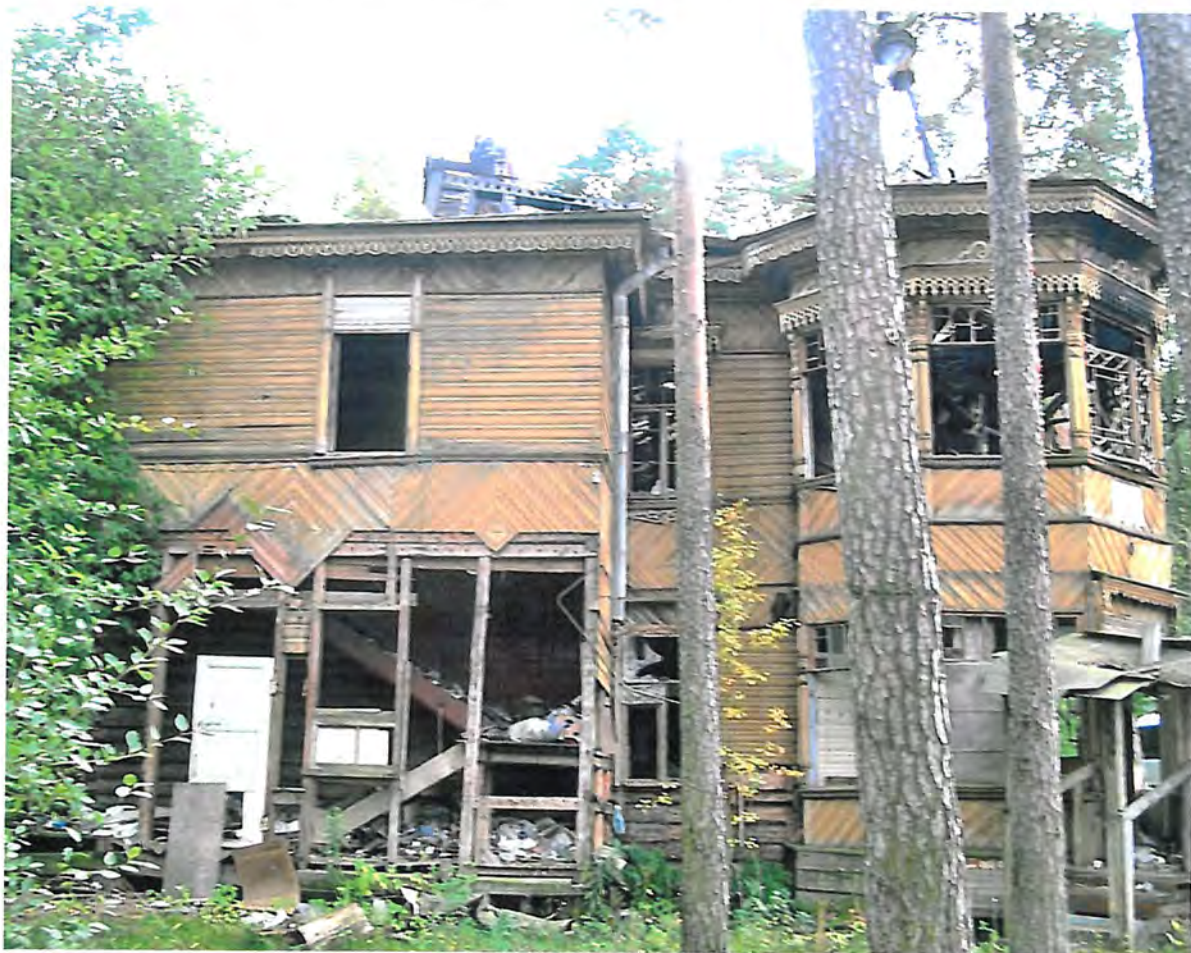
Фото 5. Северный фасад Объекта (13.09.2015 г.)
