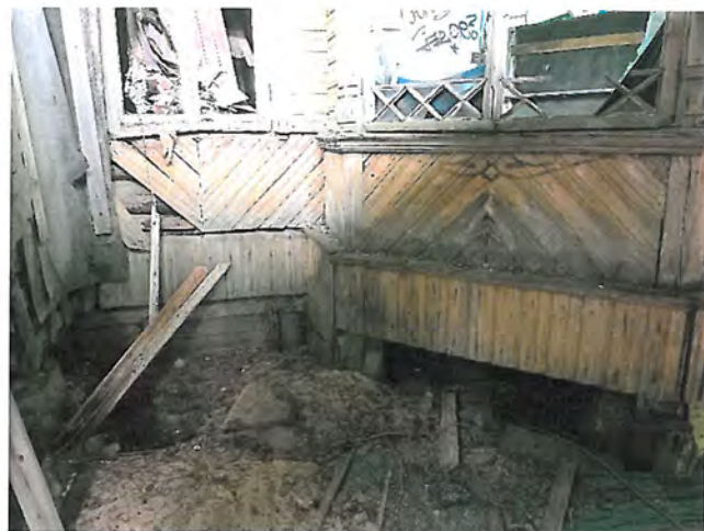
Фото 17. Вид на часть западного фасада и юго-западного ризалита
