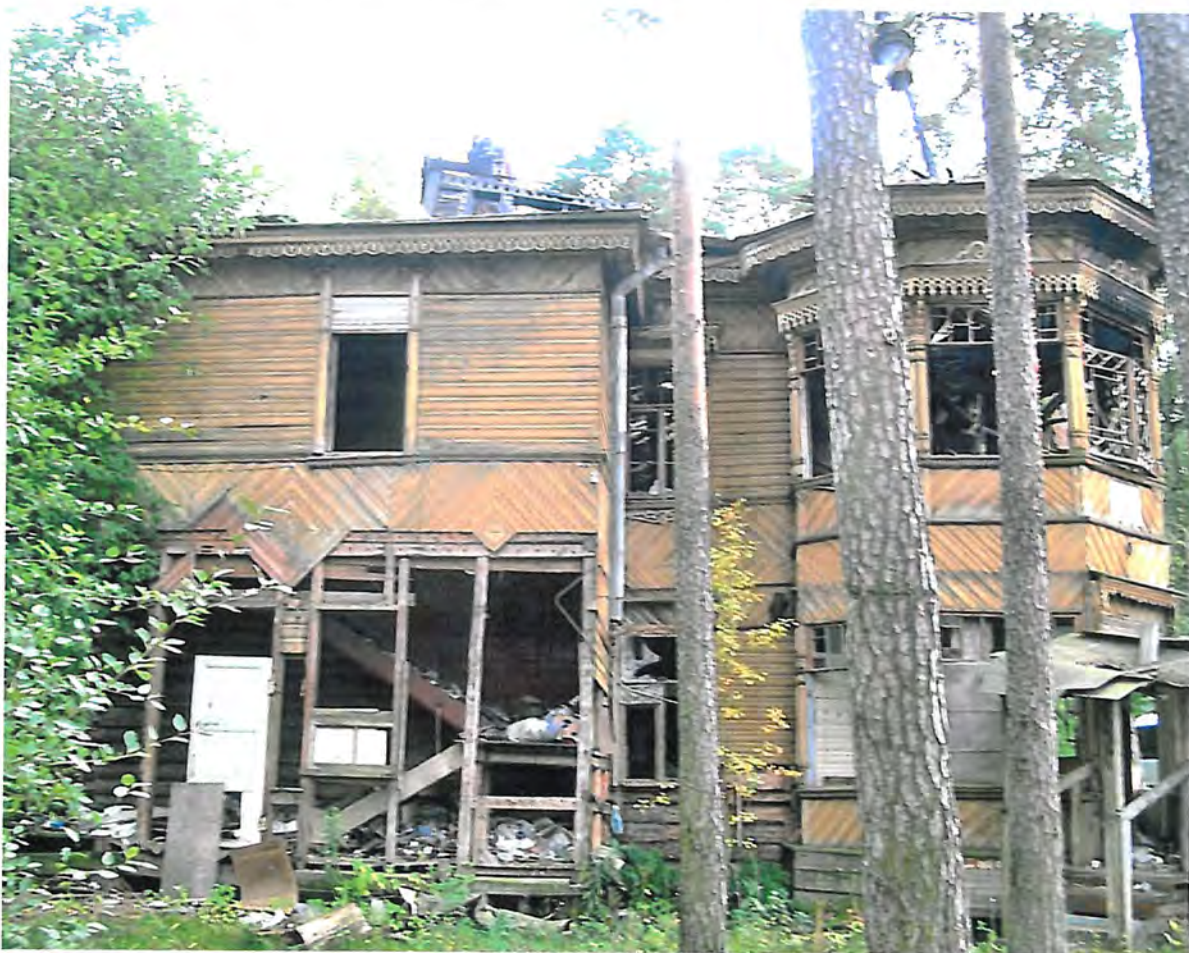
Фото 5. Северный фасад Объекта (13.09.2015 г.)
