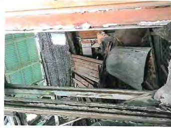
Фото 13. Вид через один из оконных проемов западного фасада внутрь здания
