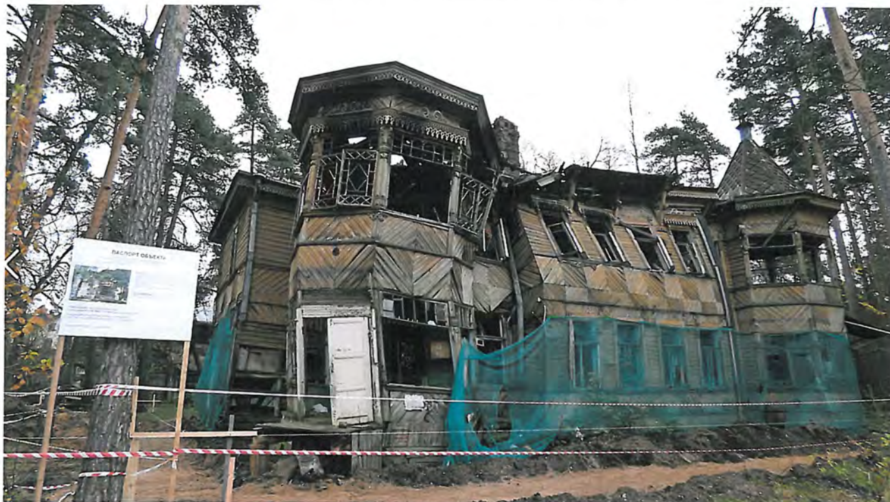
Фото 7. Западный фасад Объекта (сентябрь 2018 г.)
