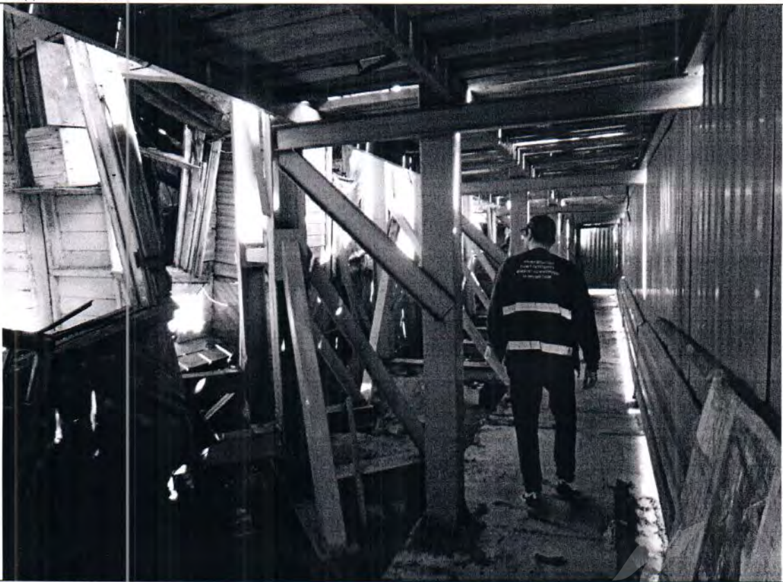
Описание: Вид на Объект
