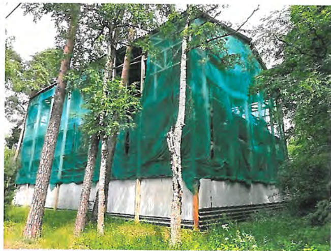
Фото 11. Вид на юго-западный угол каркаса
