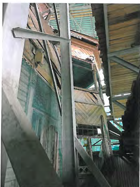
Фото 14. Вид на часть западного фасада и юго-западного ризалита
