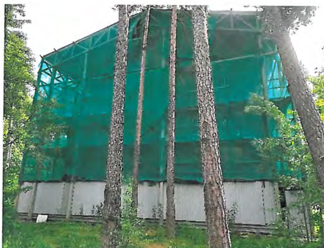
Фото 10. Вид на северный фасад каркаса
