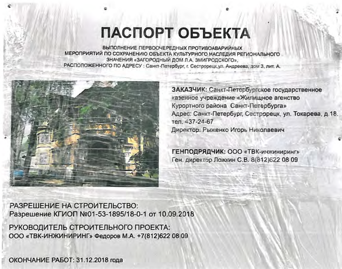
Фото 8. Первоочередные противоаварийные работы на Объекте (октябрь 2018 г.)
