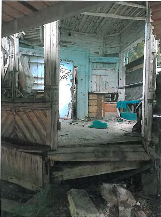
Фото 16. Вид на вход в юго-западный ризалит
