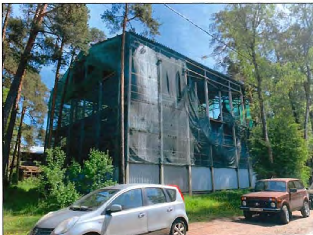
1. Общий вид объекта культурного наследия с северо-запада.
