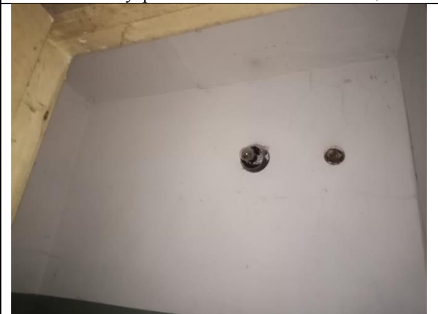
Фото 12. Внутреннее состояние Объекта оценки
