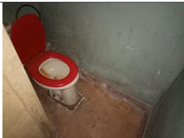
Фото 16. Внутреннее состояние Объекта оценки
