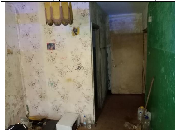
Фото 13. Внутреннее состояние Объекта оценки
