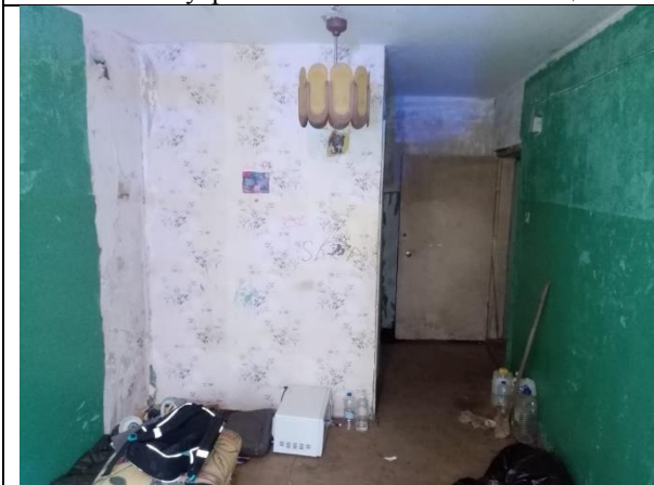
Фото 11. Внутреннее состояние Объекта оценки
