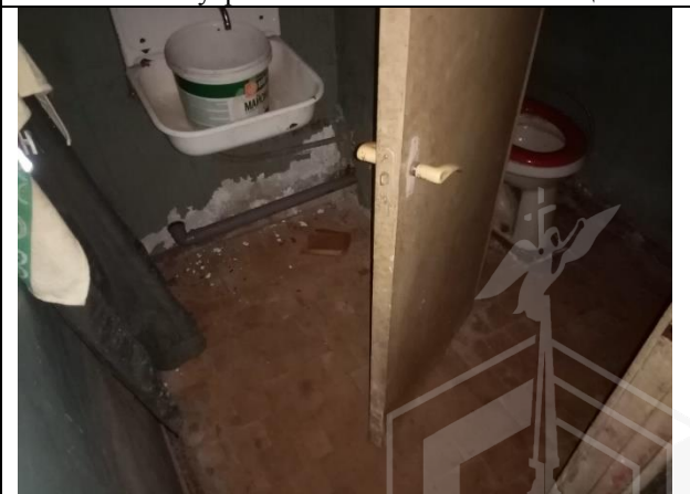
Фото 14. Внутреннее состояние Объекта оценки
