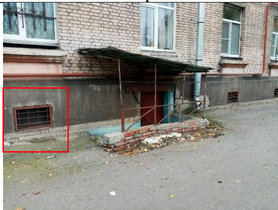
Фото 6. Общий вход 2 со двора и окно Объекта оценки
