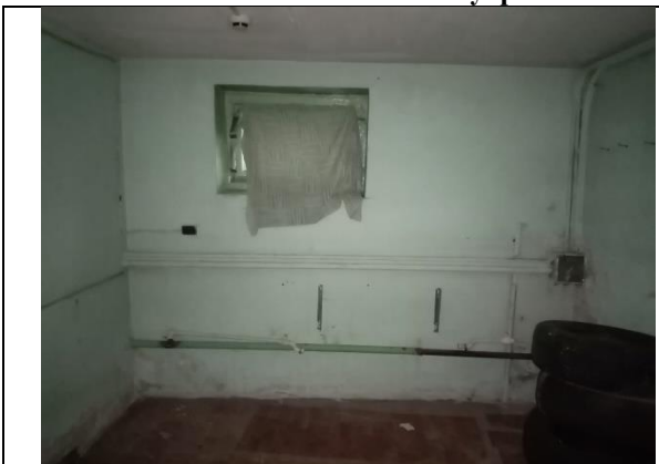
Фото 9. Внутреннее состояние Объекта оценки
