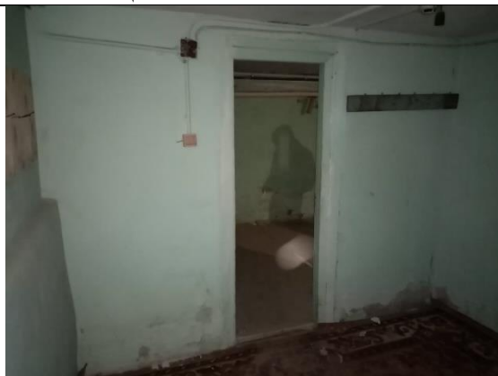
Фото 10. Внутреннее состояние Объекта оценки
