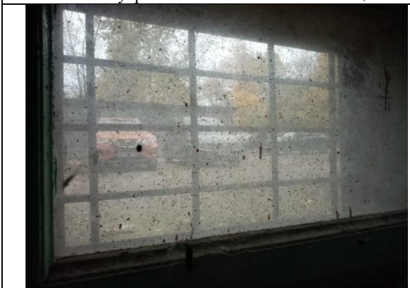
Фото 11. Внутреннее состояние Объекта оценки
