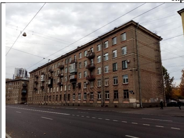
Фото 1. Вид здания, в котором расположен Объект оценки
