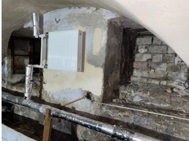
Фото № 17 – Внутреннее состояние помещения
