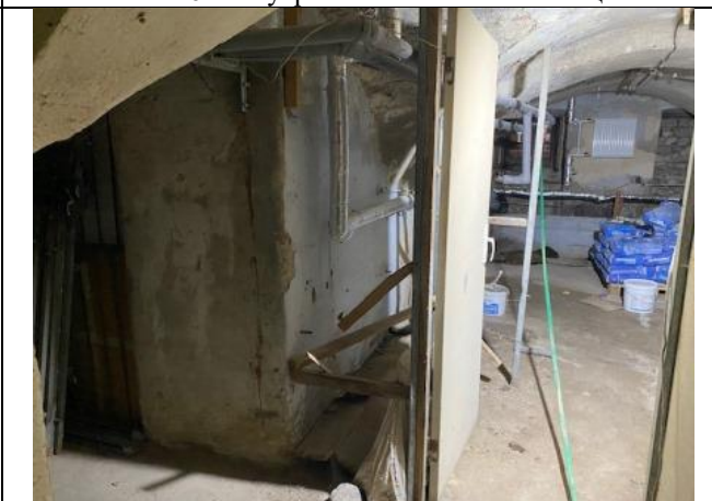
Фото № 12 – Внутреннее состояние помещения
