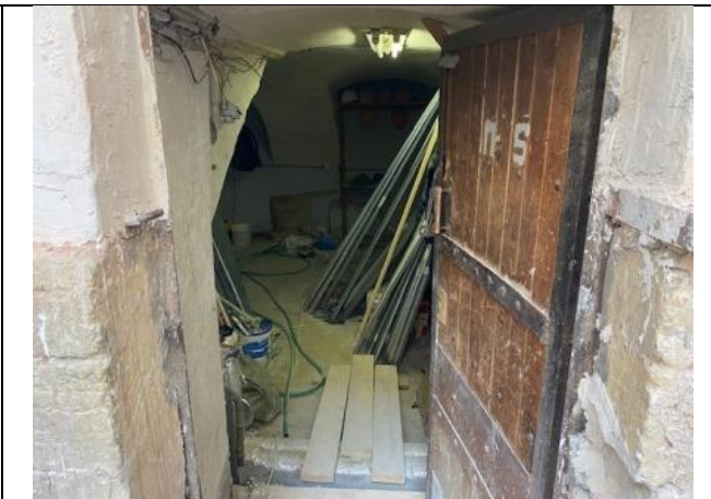
Фото № 8 – Внутреннее состояние помещения
