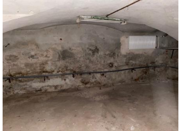
Фото № 18 – Внутреннее состояние помещения
