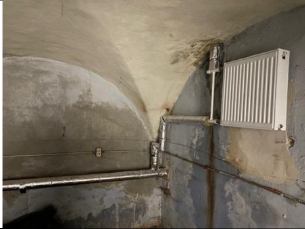
Фото № 15 – Внутреннее состояние помещения
