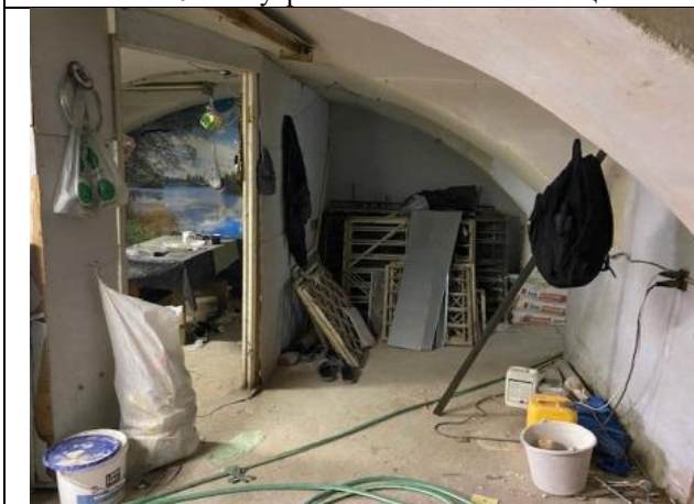
Фото № 11 – Внутреннее состояние помещения
