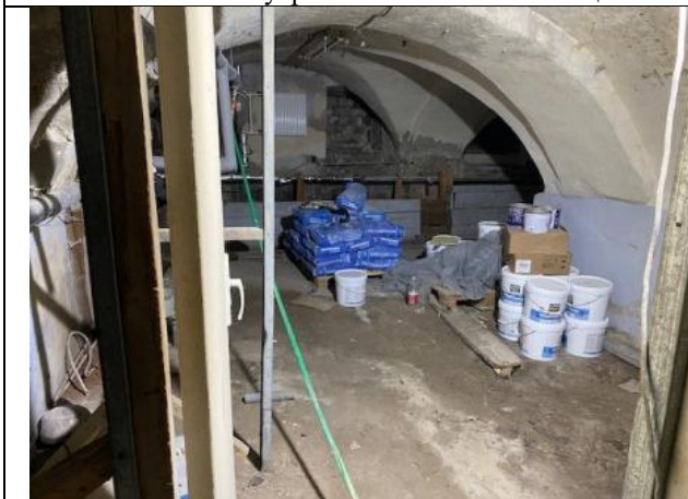
Фото № 13 – Внутреннее состояние помещения
