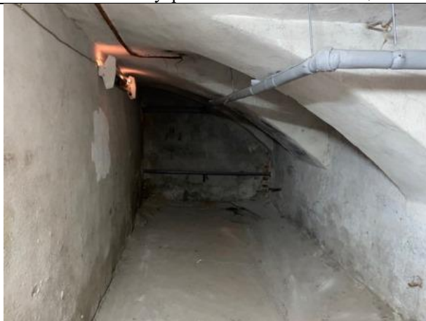
Фото № 19 – Внутреннее состояние помещения
