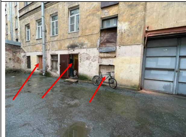
Фото 21. Входная и оконная группа Объекта оценки
