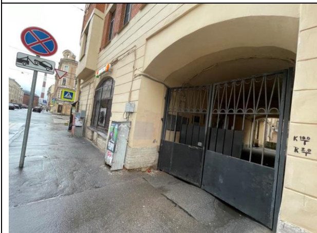
Фото 17. Проход через арку к Объекту оценки
