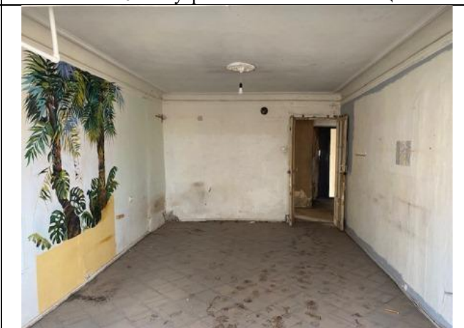
Фото № 18 – Внутреннее состояние помещения
