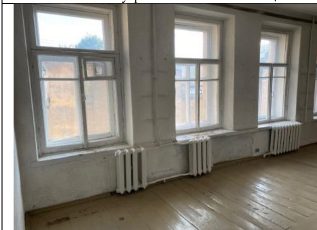
Фото № 23 – Внутреннее состояние помещения
