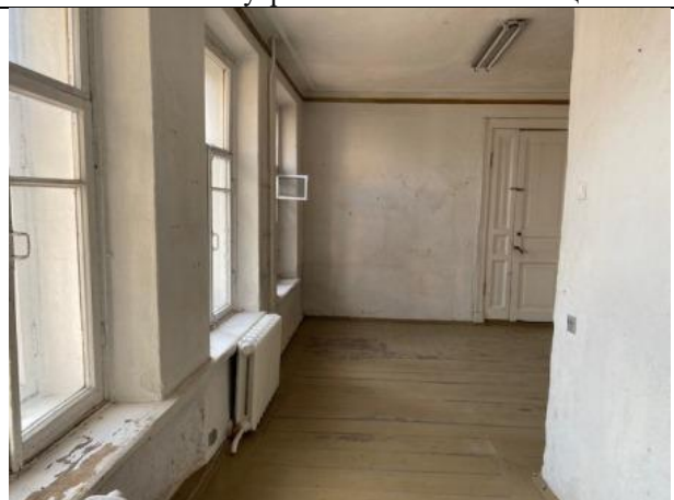
Фото № 24 – Внутреннее состояние помещения
