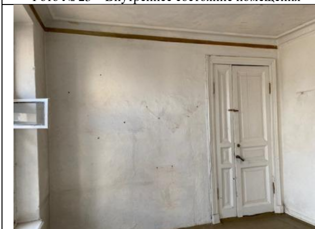
Фото № 25 – Внутреннее состояние помещения
