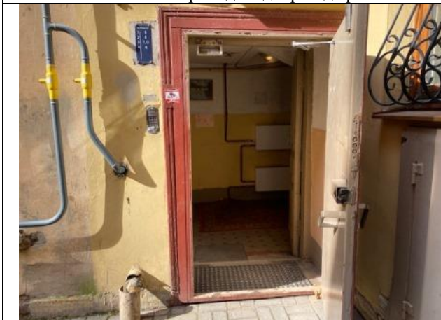
Фото № 7 – Общий вход со двора
