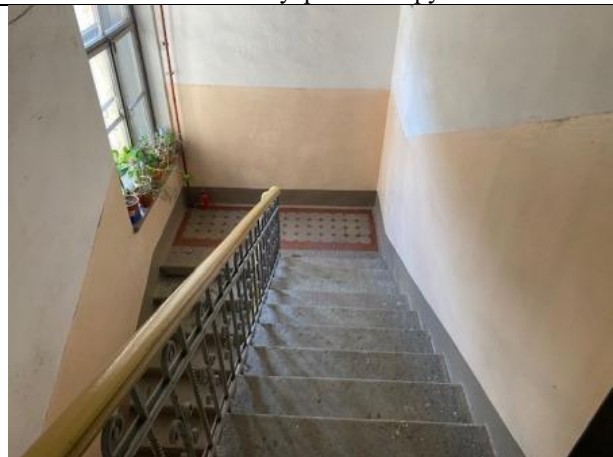
Фото № 8 – Лестничный пролет
