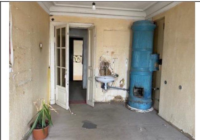
Фото № 14 – Внутреннее состояние помещения
