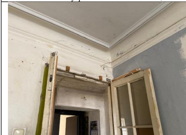
Фото № 19 – Внутреннее состояние помещения
