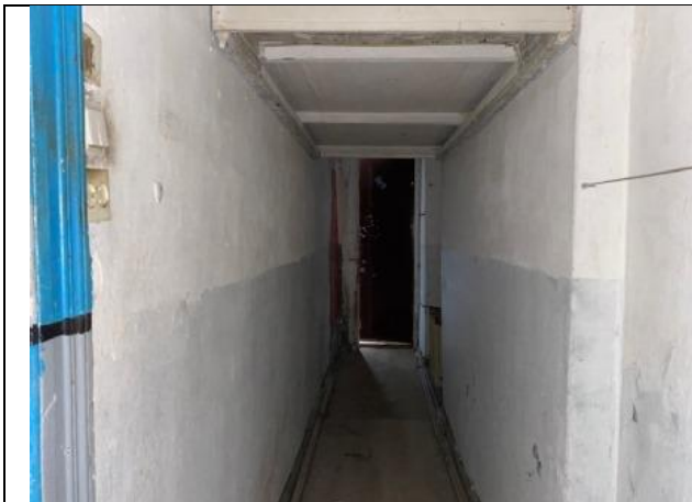
Фото № 21 – Внутреннее состояние помещения
