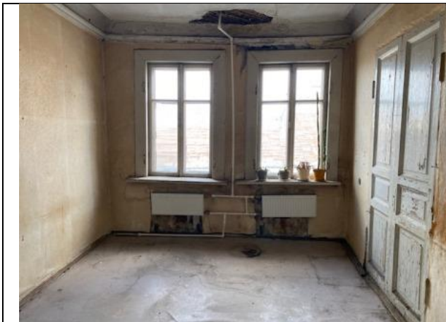
Фото № 13 – Внутреннее состояние помещения
