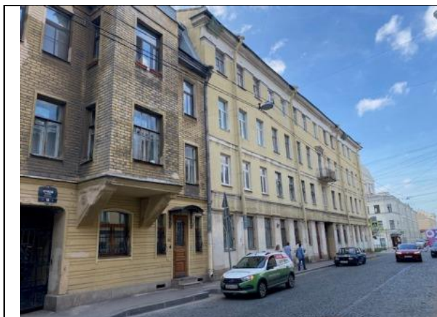
Фото № 1 – Подъездные пути
