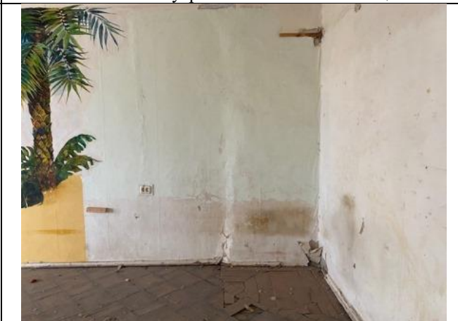
Фото № 16 – Внутреннее состояние помещения
