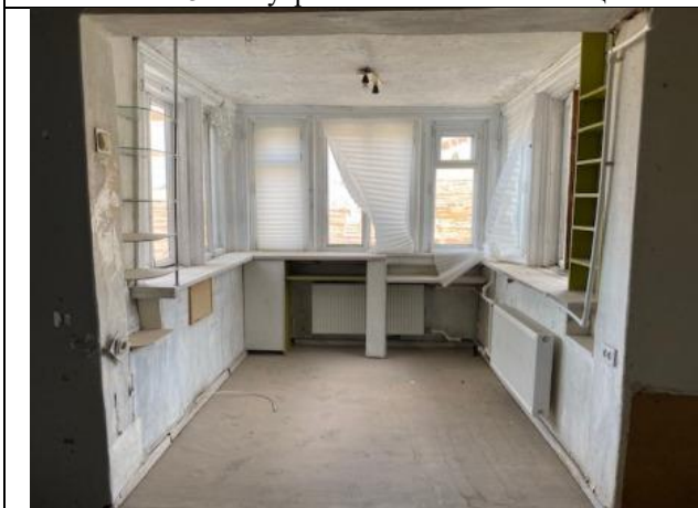
Фото № 17 – Внутреннее состояние помещения
