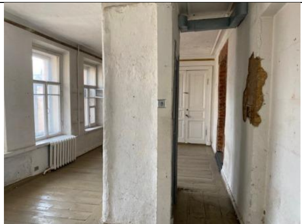
Фото № 22 – Внутреннее состояние помещения
