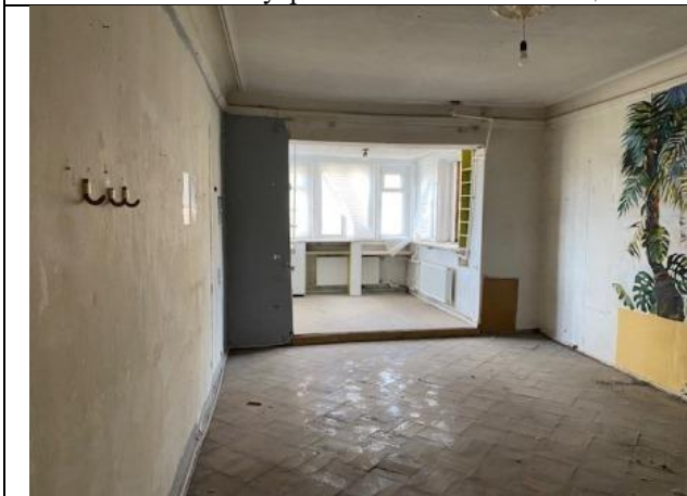
Фото № 15 – Внутреннее состояние помещения
