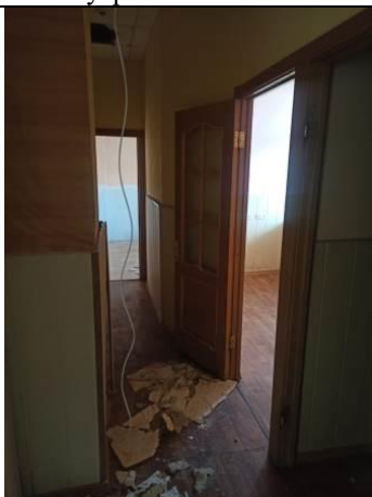
Фото № 9 – Внутреннее состояние помещения
