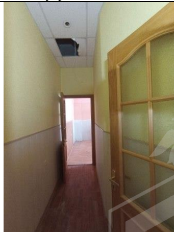
Фото № 12 – Внутреннее состояние помещения
