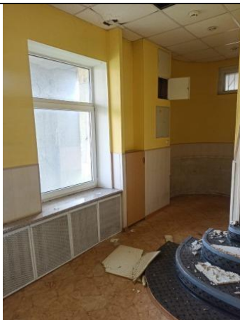
Фото № 5 – Внутреннее состояние помещения
