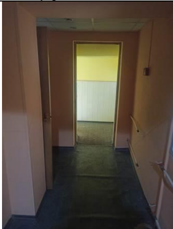
Фото № 7 – Внутреннее состояние помещения
