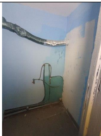
Фото № 14 – Внутреннее состояние помещения
