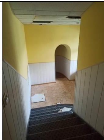
Фото № 6 – Внутреннее состояние помещения
