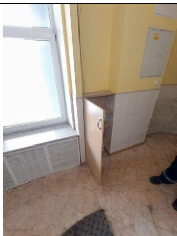
Фото № 13 – Внутреннее состояние помещения
