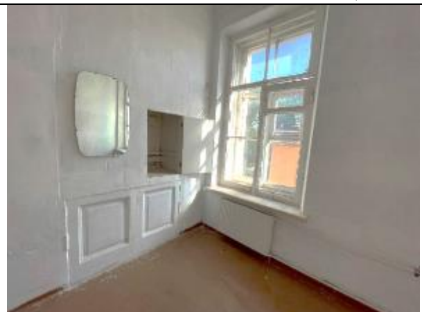
Фото 32. Типичное состояние Объекта оценки
