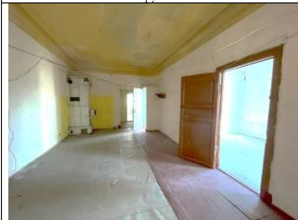
Фото 31. Типичное состояние Объекта оценки
