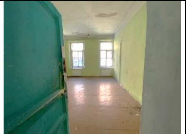
Фото 24. Типичное состояние Объекта оценки
