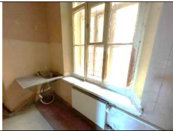
Фото 45. Типичное состояние Объекта оценки
