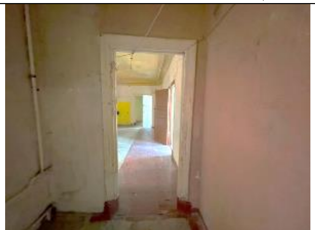
Фото 42. Типичное состояние Объекта оценки
