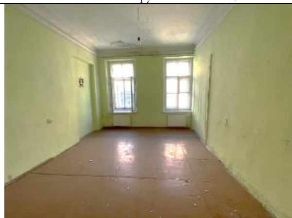
Фото 25. Типичное состояние Объекта оценки
