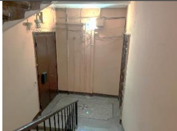
Фото 55. Лестничный проём Объекта оценки
