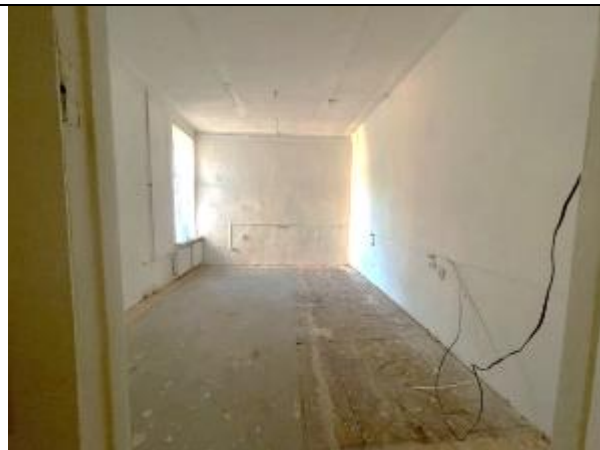
Фото 49. Типичное состояние Объекта оценки
