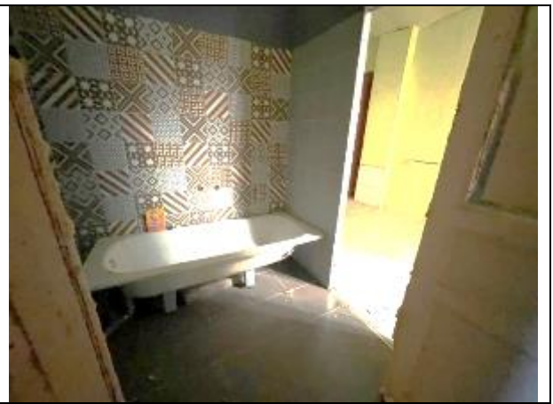
Фото 46. Типичное состояние Объекта оценки
