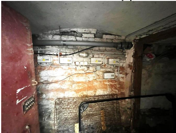
Фото 9. Вход в помещение
