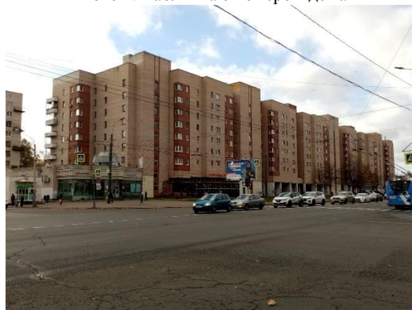
Фото 4. Вид здания и ближайшее окружение Объекта оценки
