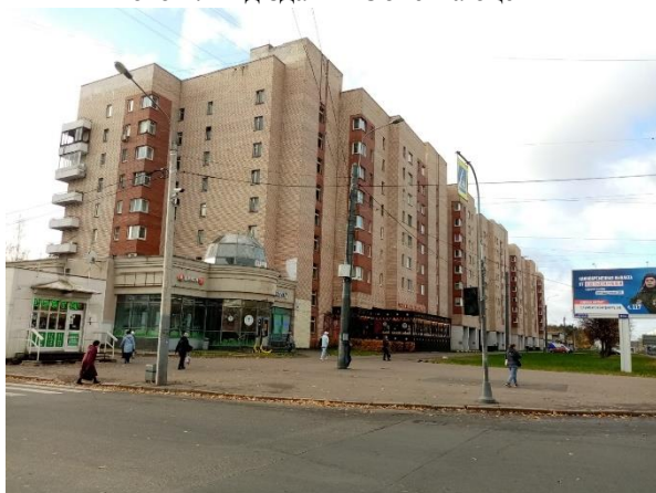
Фото 3. Вид здания и ближайшее окружение Объекта оценки
