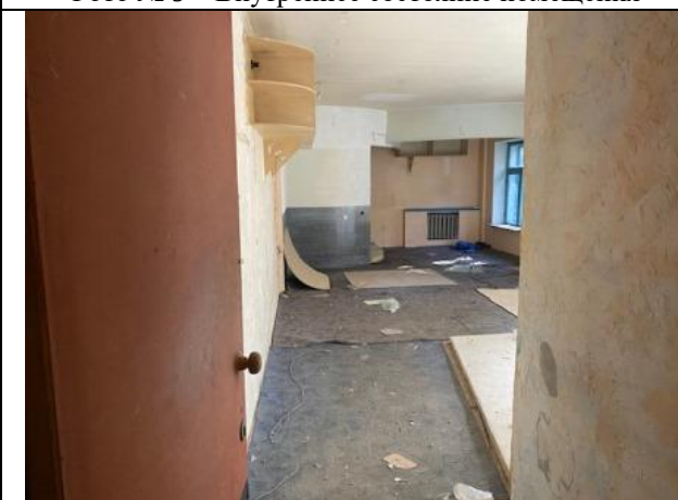
Фото № 11 – Внутреннее состояние помещения
