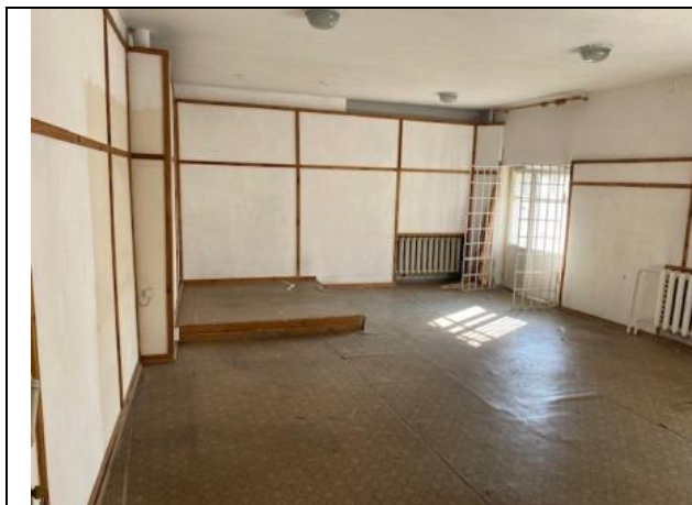
Фото № 15 – Внутреннее состояние помещения
