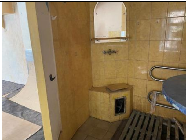
Фото № 8 – Внутреннее состояние помещения
