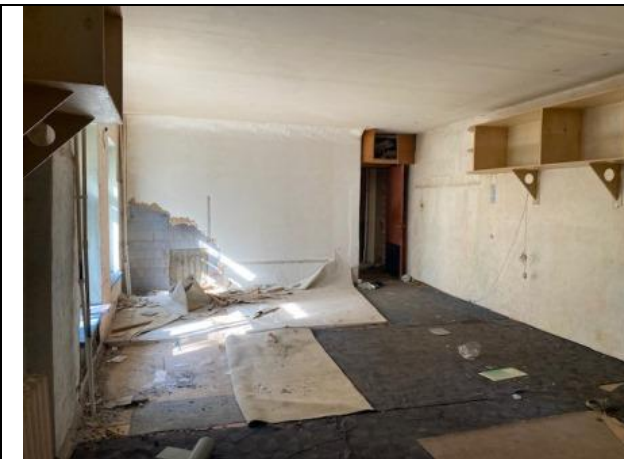
Фото № 7 – Внутреннее состояние помещения
