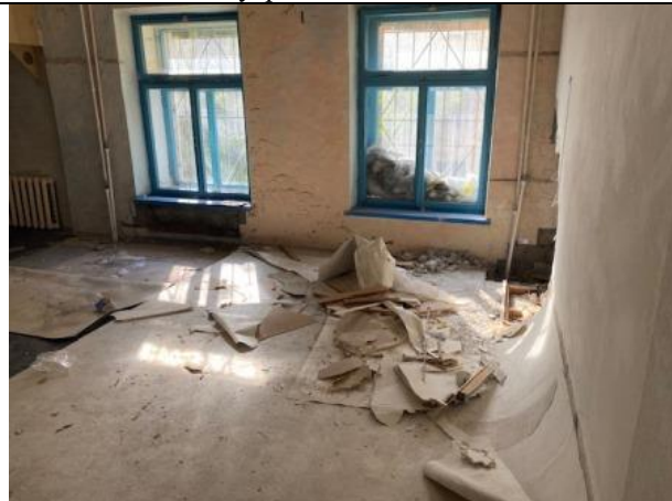
Фото № 10 – Внутреннее состояние помещения
