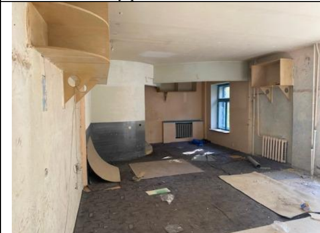
Фото № 9 – Внутреннее состояние помещения
