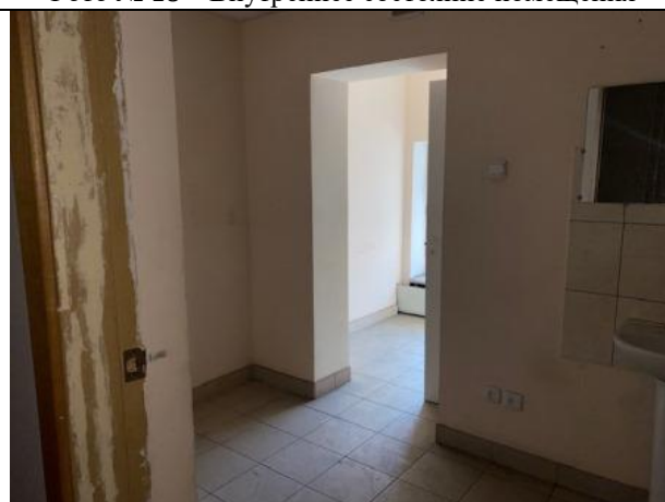
Фото № 20 – Внутреннее состояние помещения
