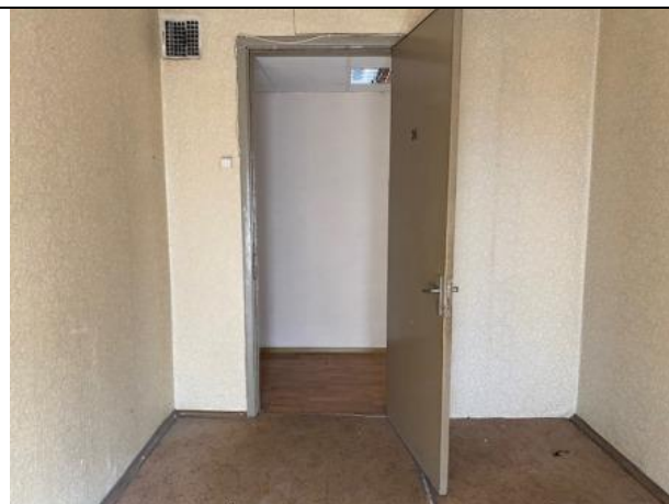
Фото № 16 – Внутреннее состояние помещения
