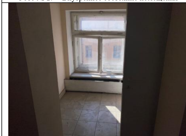
Фото № 19 – Внутреннее состояние помещения
