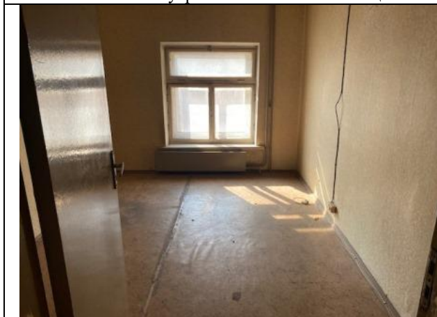
Фото № 17 – Внутреннее состояние помещения
