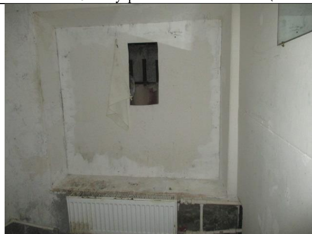
Фото № 18 – Внутреннее состояние помещения
