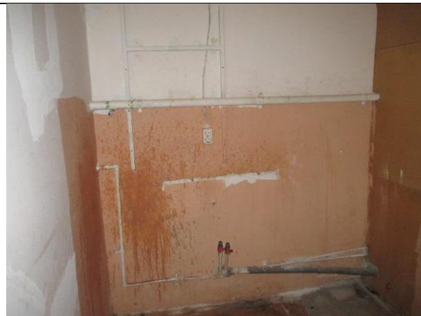
Фото № 14 – Внутреннее состояние помещения
