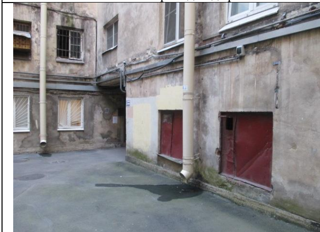
Фото № 7 – Окна помещения
