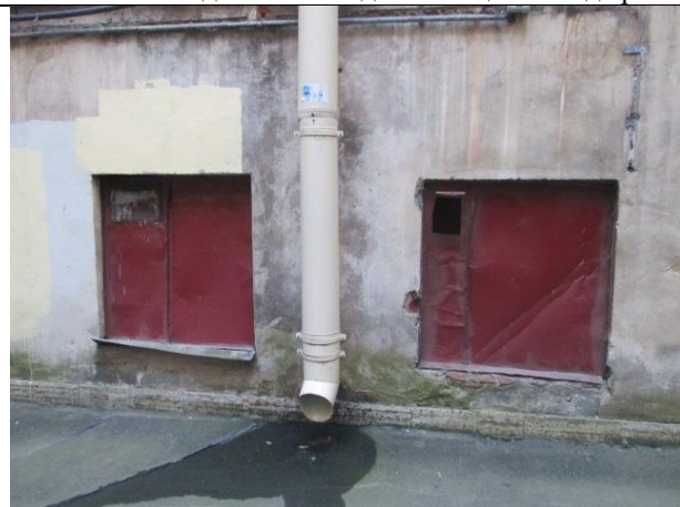
Фото № 8 – Окна помещения
