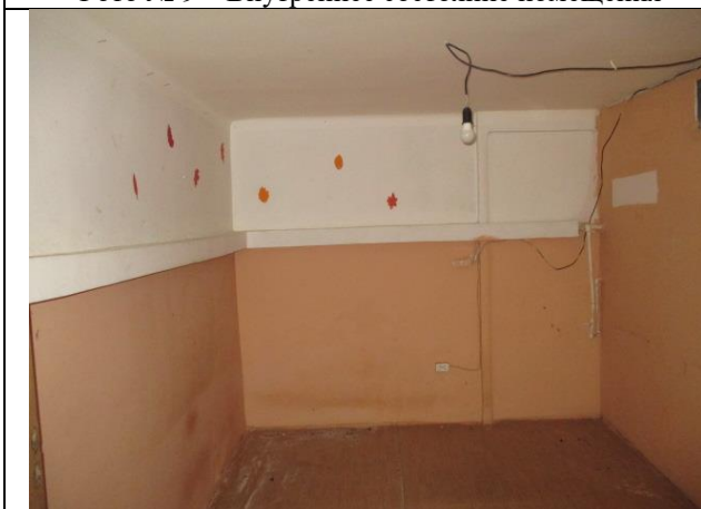
Фото № 11 – Внутреннее состояние помещения
