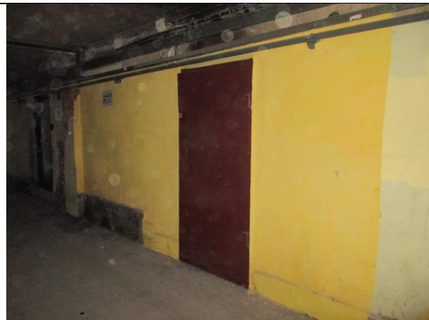
Фото № 6 – Отдельный вход в помещение под аркой
