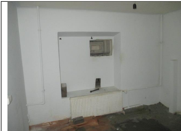
Фото № 13 – Внутреннее состояние помещения
