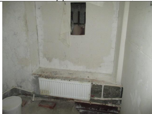
Фото № 16 – Внутреннее состояние помещения
