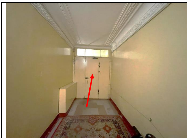
Фото 29. Входная группа Объекта оценки со стороны подьезда
