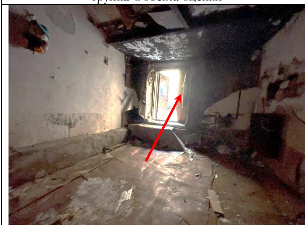
Фото 19. Типичное состояние Объекта оценки
