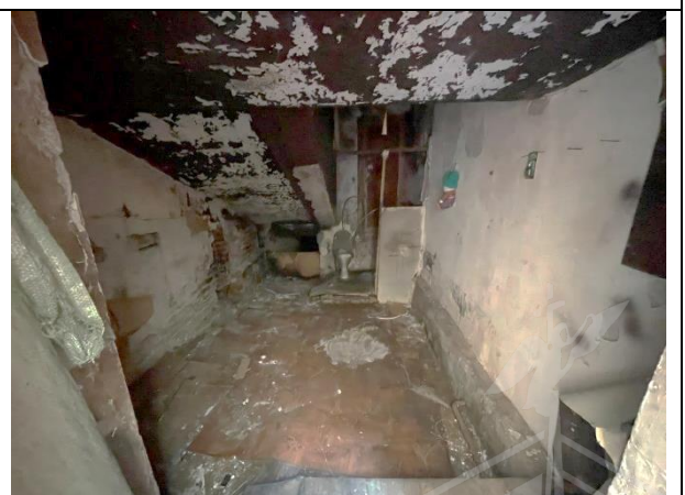
Фото 20. Типичное состояние Объекта оценки
