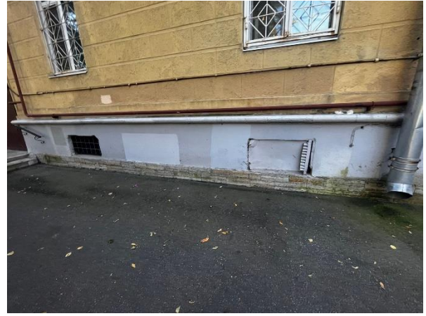
Фото 6. Вид окон Объекта оценки
