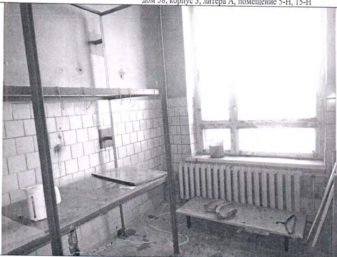
Описание: Вид внутри ч.п. 3 помещения 5-Н Объекта
