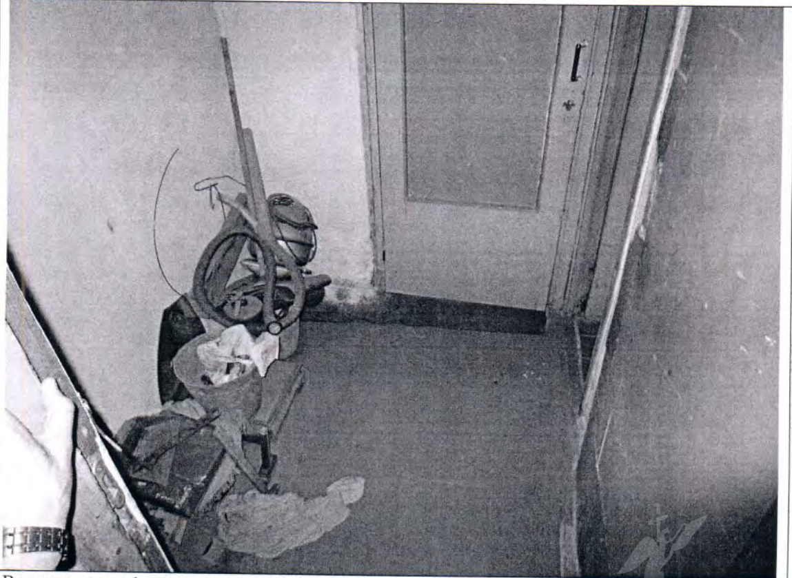
Описание: Вид внутри ч.п. 1 помещения 15-Н Объекта
