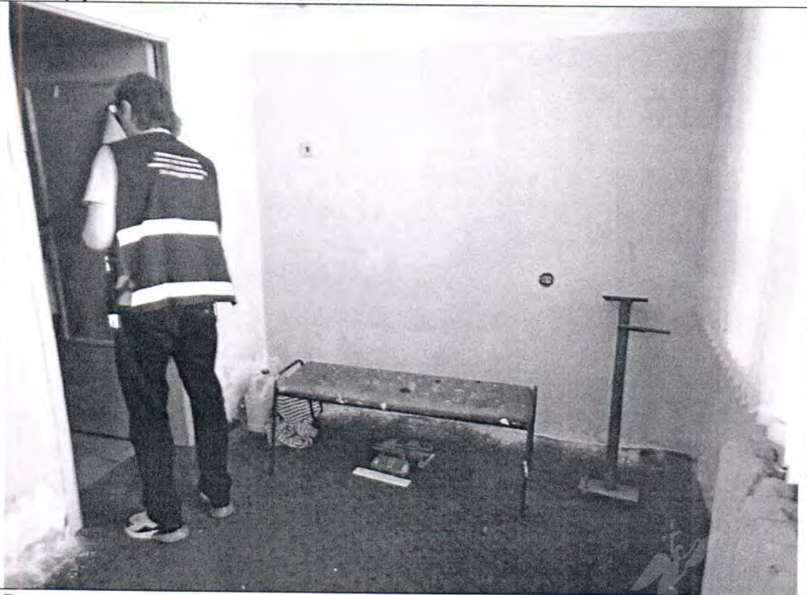
Описание: Вид внутри ч.п. 2 помещения 15-Н Объекта
