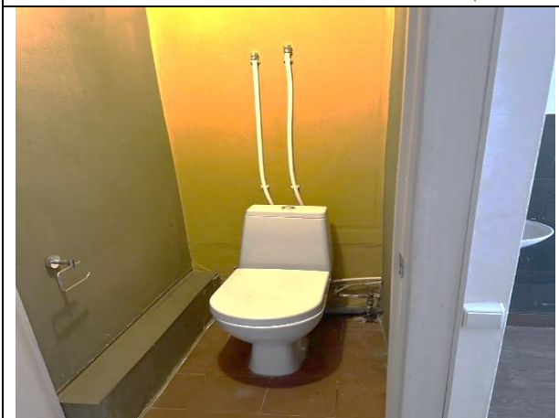
Фото 23. Типичное состояние Объекта оценки
