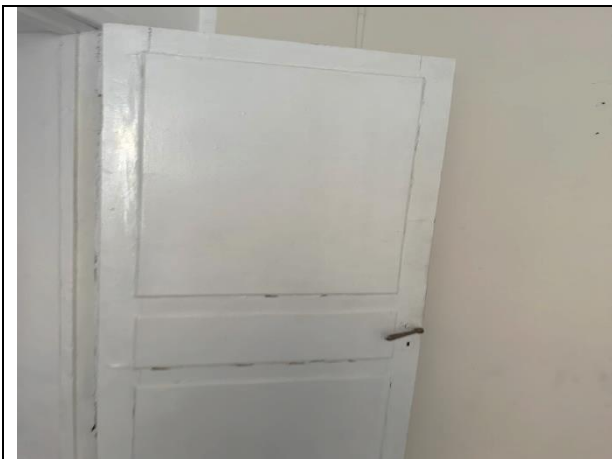
Фото 19. Типичное состояние Объекта оценки
