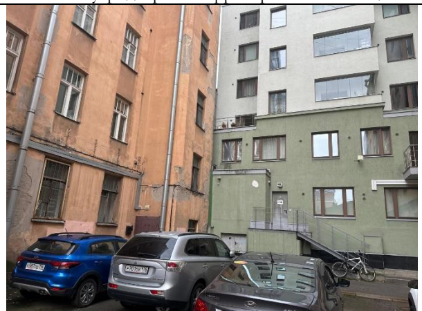
Фото 6. Внутридворовая территория Объекта оценки
