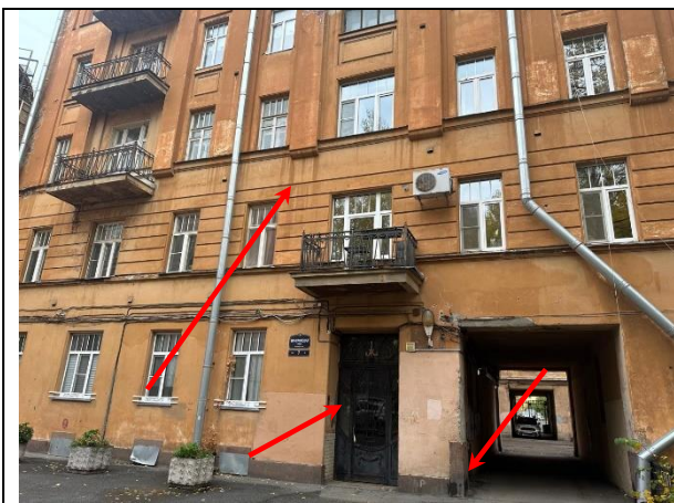
Фото 11. Вид здания расположения Объекта оценки, проход через арку к Объекту оценки, входная группа Объекта оценки
