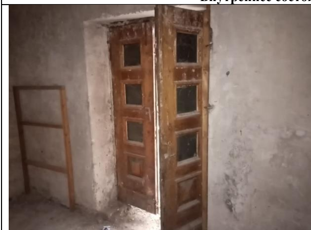
Фото 7. Внутреннее состояние Объекта оценки
