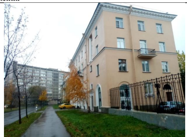
Фото 2. Вид здания, в котором расположен Объект оценки
