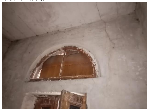
Фото 8. Внутреннее состояние Объекта оценки
