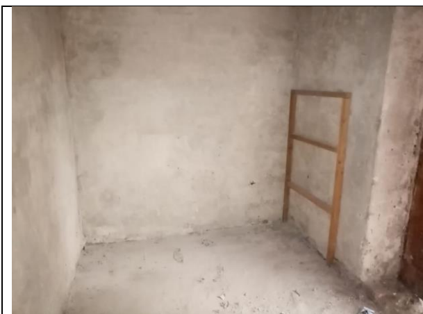
Фото 9. Внутреннее состояние Объекта оценки
