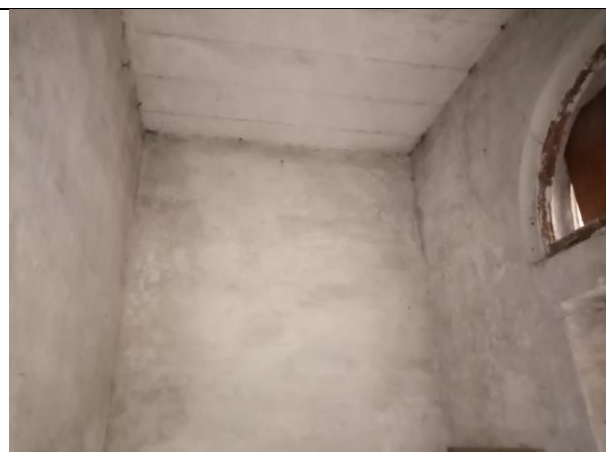
Фото 10. Внутреннее состояние Объекта оценки
