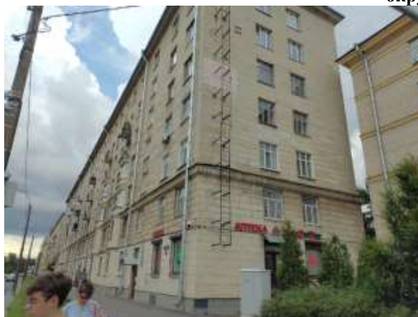
Фото 1. Вид здания Объекта оценки, с улицы
