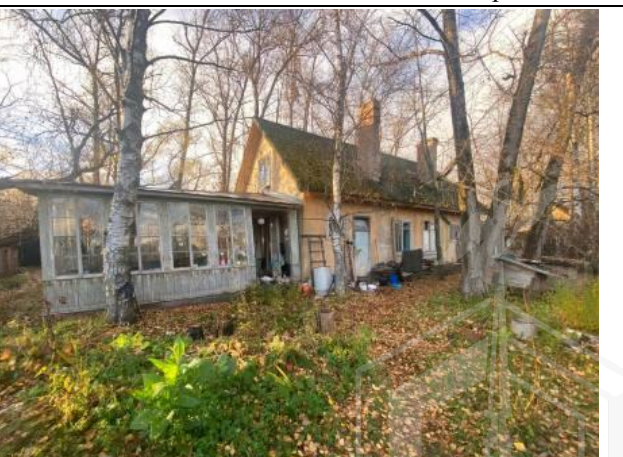
Фото № 8. Внешний вид здания литера А
