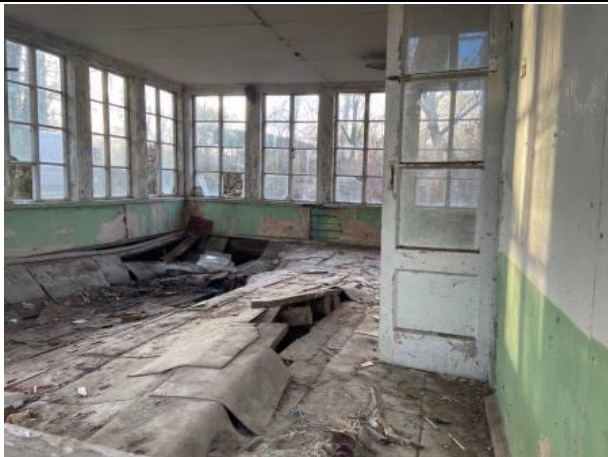
Фото № 11. Внутреннее состояние здание литеры Б
