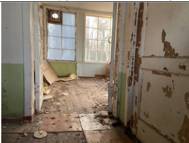
Фото № 13. Внутреннее состояние здание литеры Б
