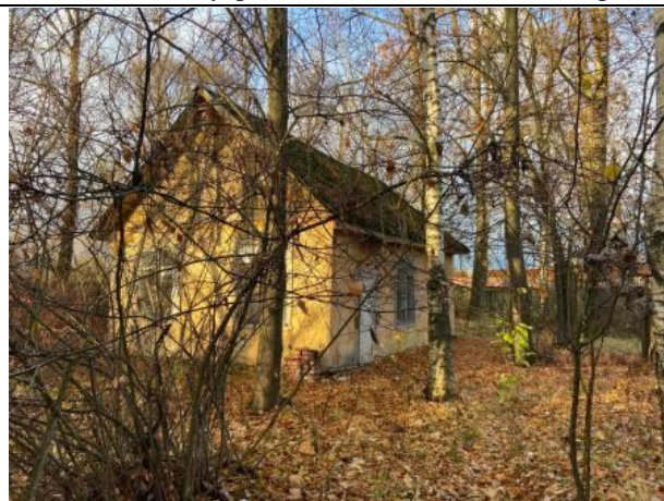
Фото № 14. Внешний вид здания литеры В
