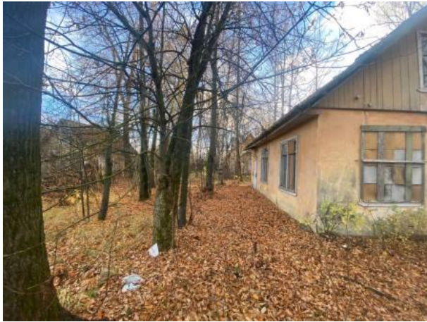
Фото № 19. Внешний вид здания литера Е
