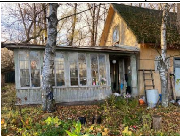
Фото № 7. Внешний вид здания литера А
