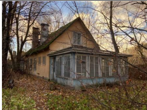
Фото № 10. Внешний вид здания литеры Б
