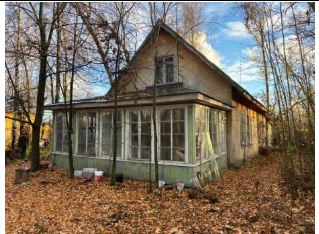
Фото № 6. Внешний вид здания литера А
