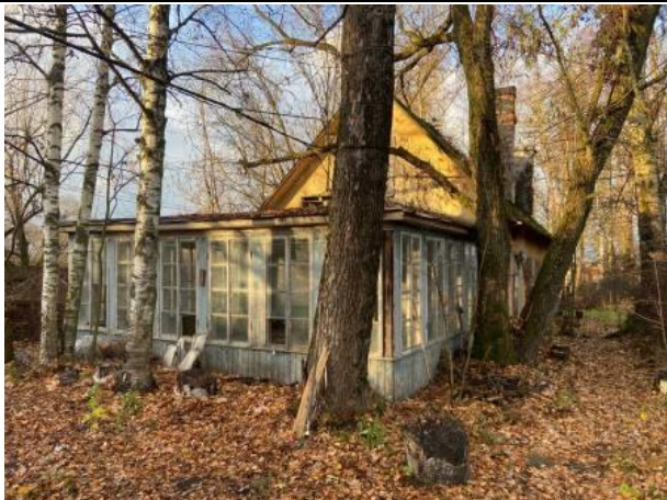
Фото № 9. Внешний вид здания литеры Б
