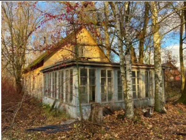
Фото № 5. Внешний вид здания литера А
