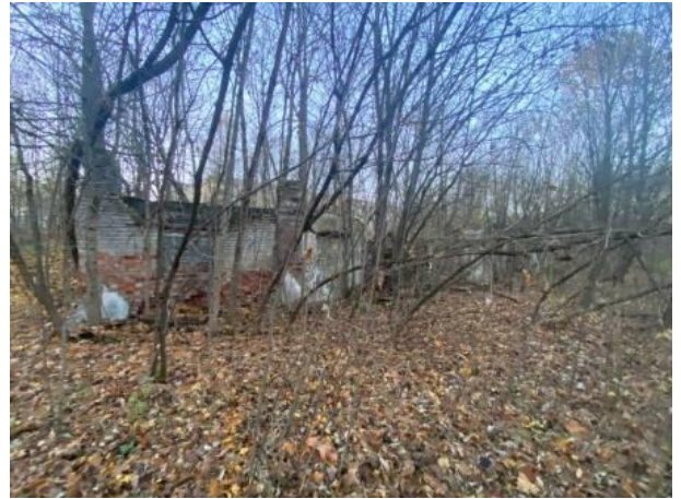
Фото № 6. Внешний вид здания литера З
