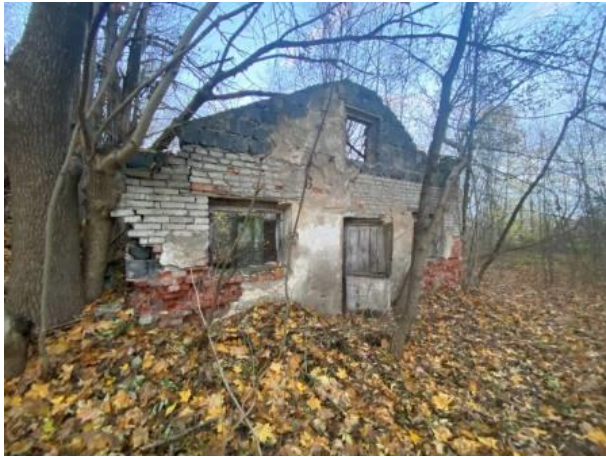
Фото № 5. Внешний вид здания литера З
