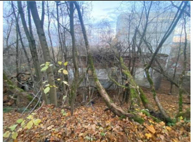
Фото № 16. Внешний вид здания литера А
