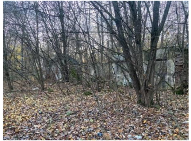
Фото № 12. Внешний вид здания литера К
