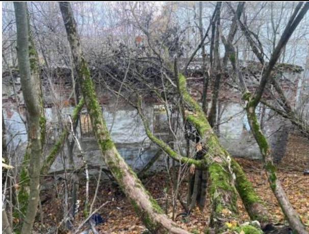
Фото № 15. Внешний вид здания литера А
