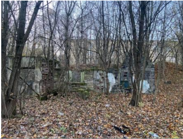
Фото № 11. Внешний вид здания литера В
