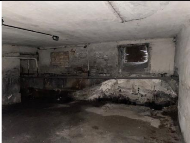
Фото № 15 – Внутреннее состояние помещения
