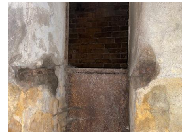
Фото № 39 – Внутреннее состояние помещения
