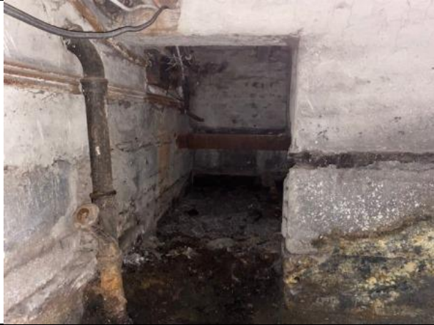
Фото № 31 – Внутреннее состояние помещения
