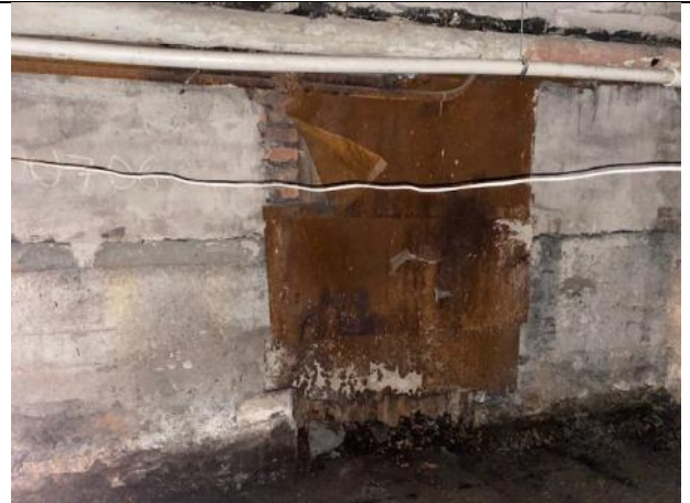
Фото № 16 – Внутреннее состояние помещения
