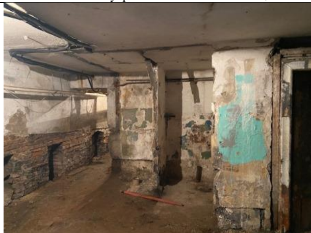
Фото № 10 – Внутреннее состояние помещения
