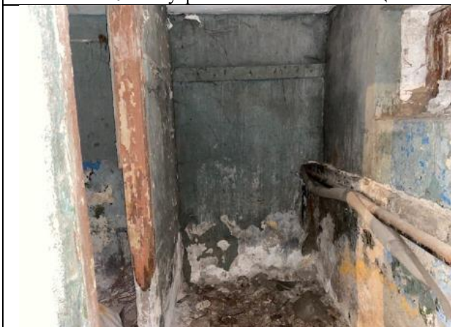
Фото № 11 – Внутреннее состояние помещения
