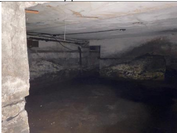
Фото № 27 – Внутреннее состояние помещения
