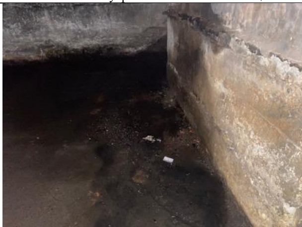
Фото № 29 – Внутреннее состояние помещения
