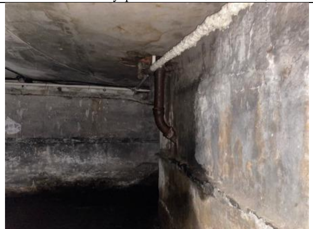
Фото № 28 – Внутреннее состояние помещения
