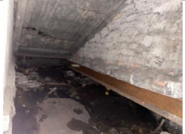
Фото № 26 – Внутреннее состояние помещения
