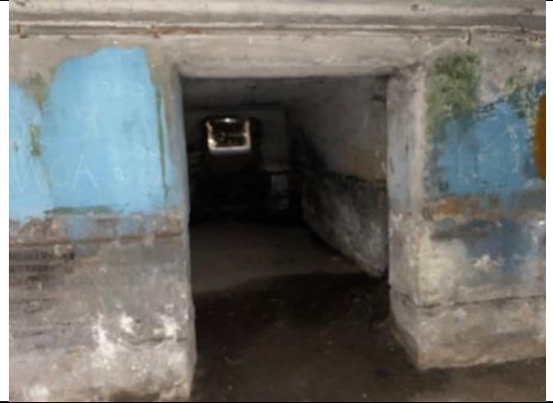
Фото № 24 – Внутреннее состояние помещения
