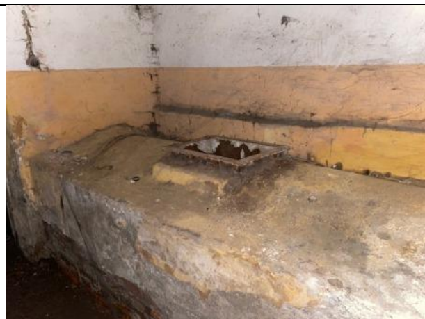
Фото № 40 – Внутреннее состояние помещения
