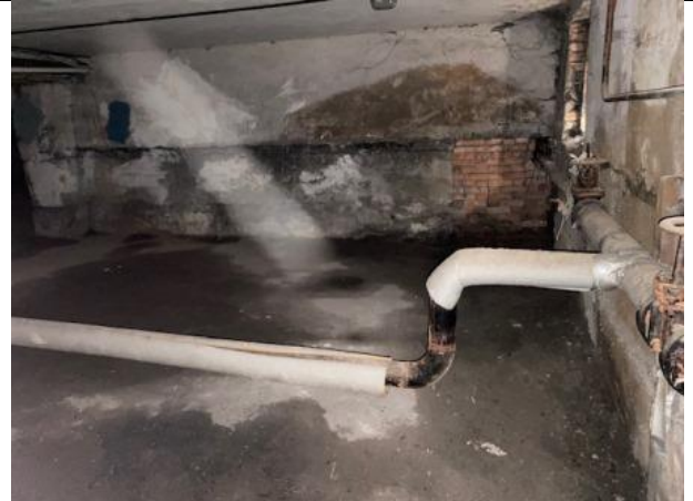
Фото № 18 – Внутреннее состояние помещения
