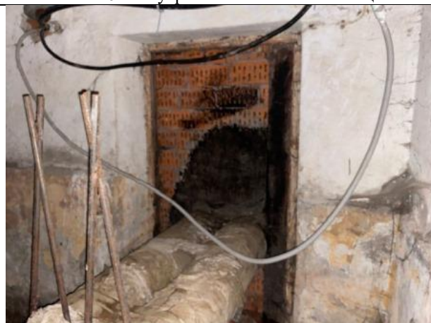
Фото № 42 – Внутреннее состояние помещения
