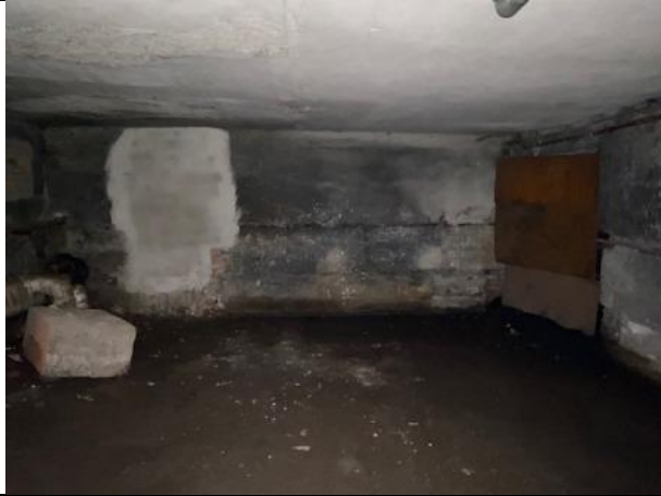
Фото № 23 – Внутреннее состояние помещения
