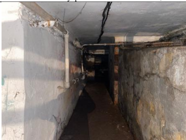
Фото № 37 – Внутреннее состояние помещения
