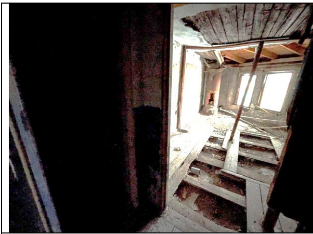
Фото 29. Типичное состояние Объекта оценки
