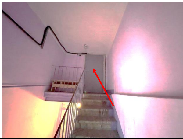
Фото 21. Лестничный проём Объекта оценки, входная группа Объекта оценки (7 этаж)
