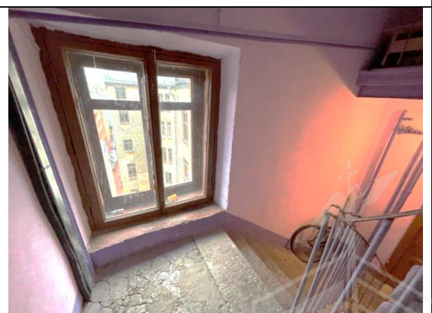
Фото 20. Лестничный проём Объекта оценки
