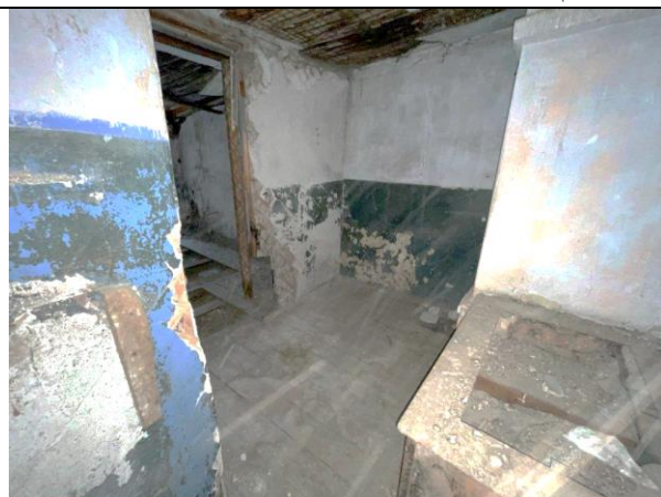
Фото 27. Типичное состояние Объекта оценки
