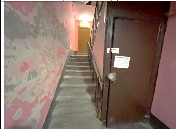
Фото 33. Лестничный проём Объекта оценки
