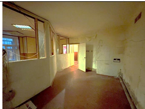
Фото 43. Типичное состояние Объекта оценки
