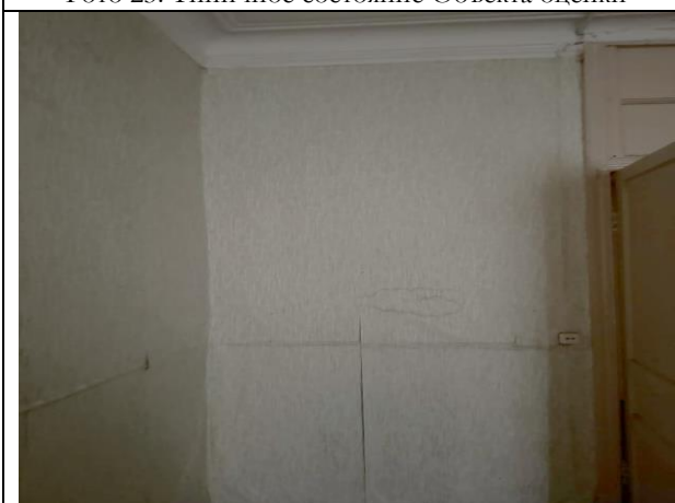
Фото 25. Типичное состояние Объекта оценки
