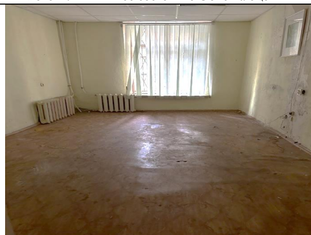
Фото 16. Типичное состояние Объекта оценки
