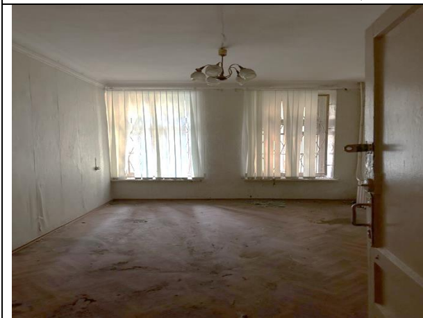
Фото 17. Типичное состояние Объекта оценки
