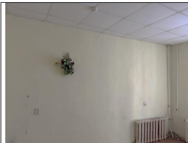
Фото 19. Типичное состояние Объекта оценки
