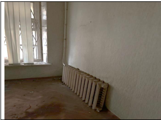
Фото 27. Типичное состояние Объекта оценки
