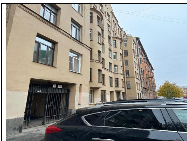
Фото 1. Ближайшее окружение Объекта оценки (улица Всеволода Вишневого), вид здания расположения Объекта оценки, проход через арку к
