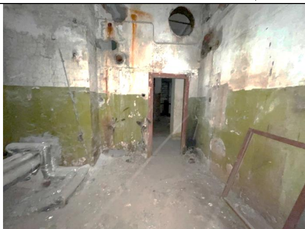
Фото 38. Типичное состояние Объекта оценки
