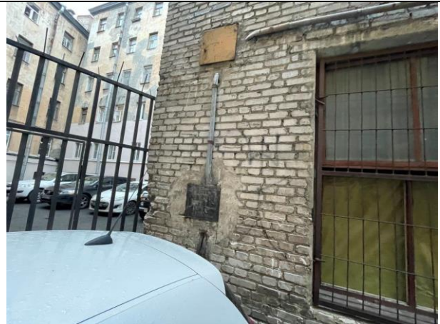
Фото 46. Типичное состояние Объекта оценки
