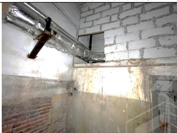
Фото 42. Типичное состояние Объекта оценки
