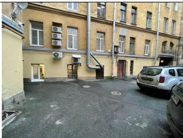
Фото 18. Внутридворовая территория Объекта оценки
