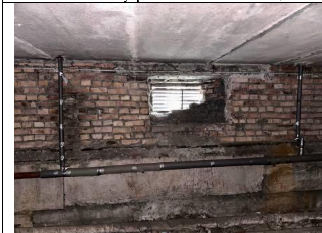
Фото № 15 – Внутреннее состояние помещения
