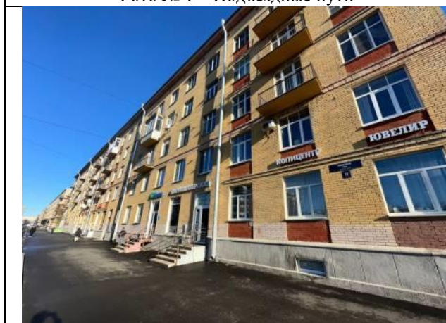
Фото № 3 – Здание, в котором находится Объект оценки
