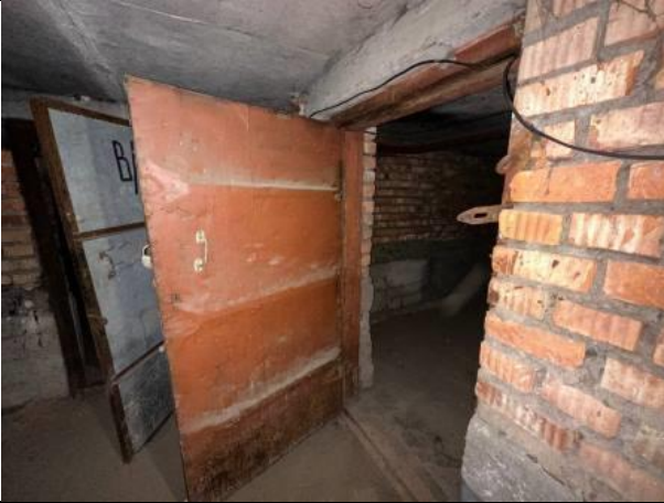
Фото № 21 – Внутреннее состояние помещения
