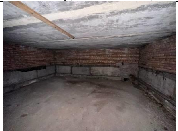
Фото № 26 – Внутреннее состояние помещения
