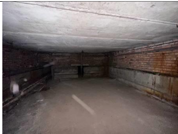
Фото № 14 – Внутреннее состояние помещения
