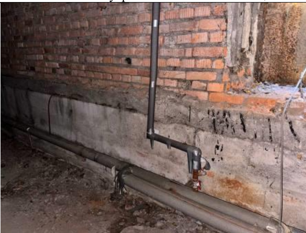
Фото № 25 – Внутреннее состояние помещения
