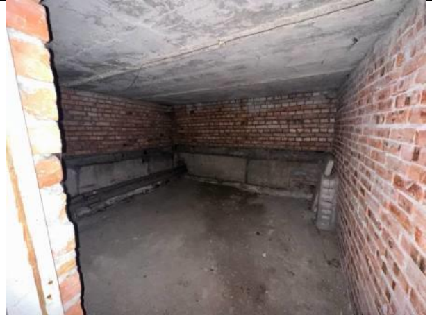
Фото № 24 – Внутреннее состояние помещения
