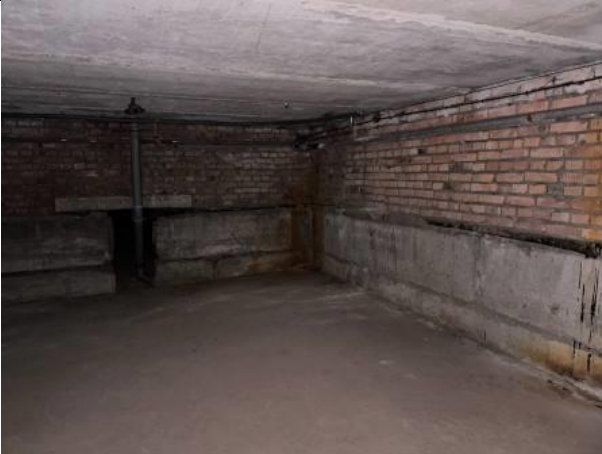
Фото № 23 – Внутреннее состояние помещения
