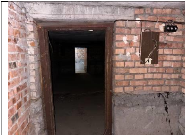
Фото № 13 – Внутреннее состояние помещения
