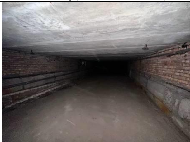
Фото № 16 – Внутреннее состояние помещения
