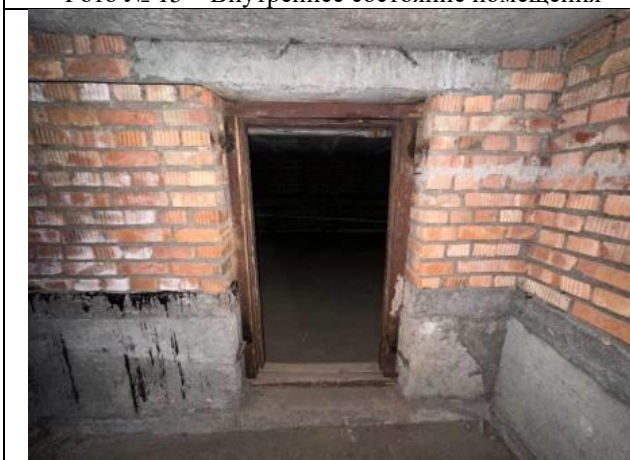
Фото № 17 – Внутреннее состояние помещения
