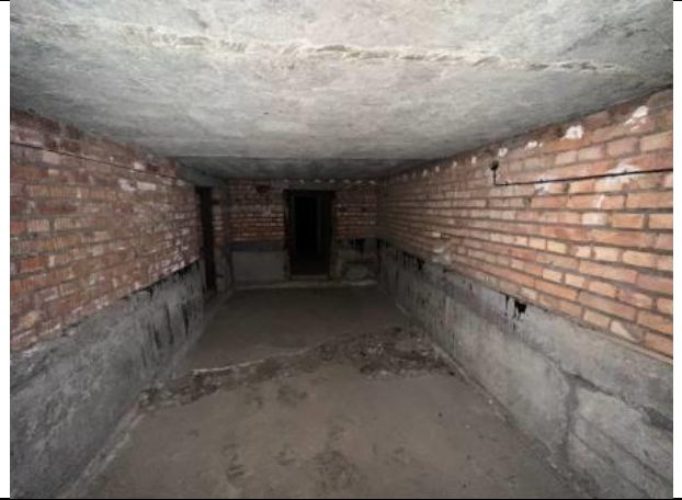
Фото № 22 – Внутреннее состояние помещения
