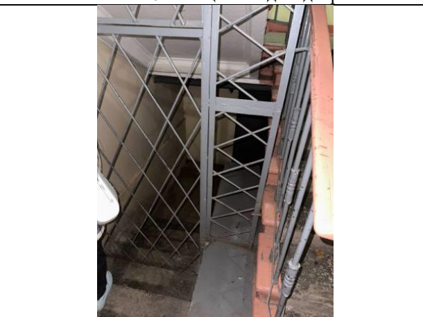
Фото № 8 – – Вход в помещение
