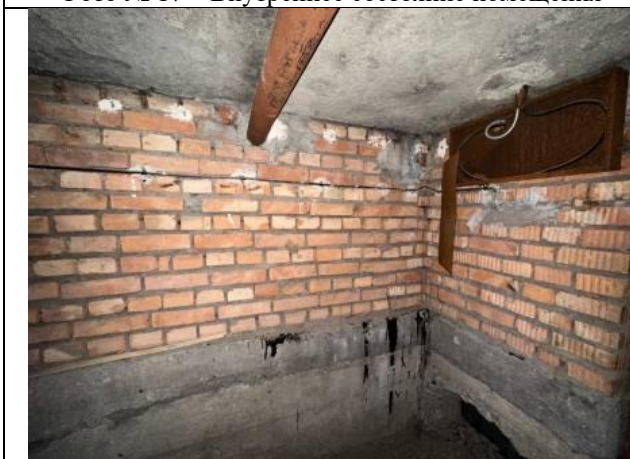
Фото № 19 – Внутреннее состояние помещения
