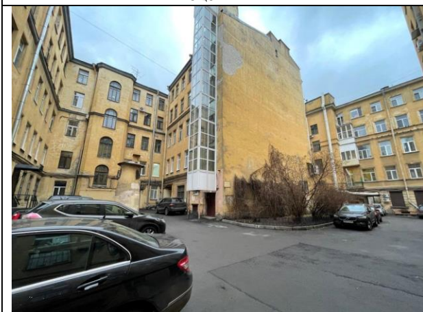
Фото 21. Внутривдворовая территория Объекта оценки
