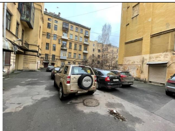
Фото 20. Внутривдворовая территория Объекта оценки
