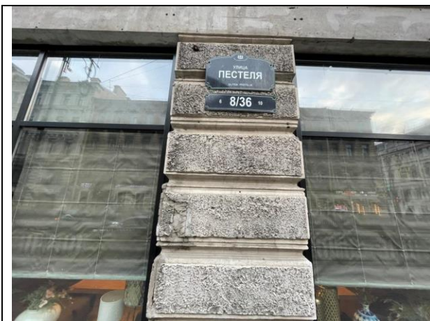
Фото 11. Адрес Объекта оценки
