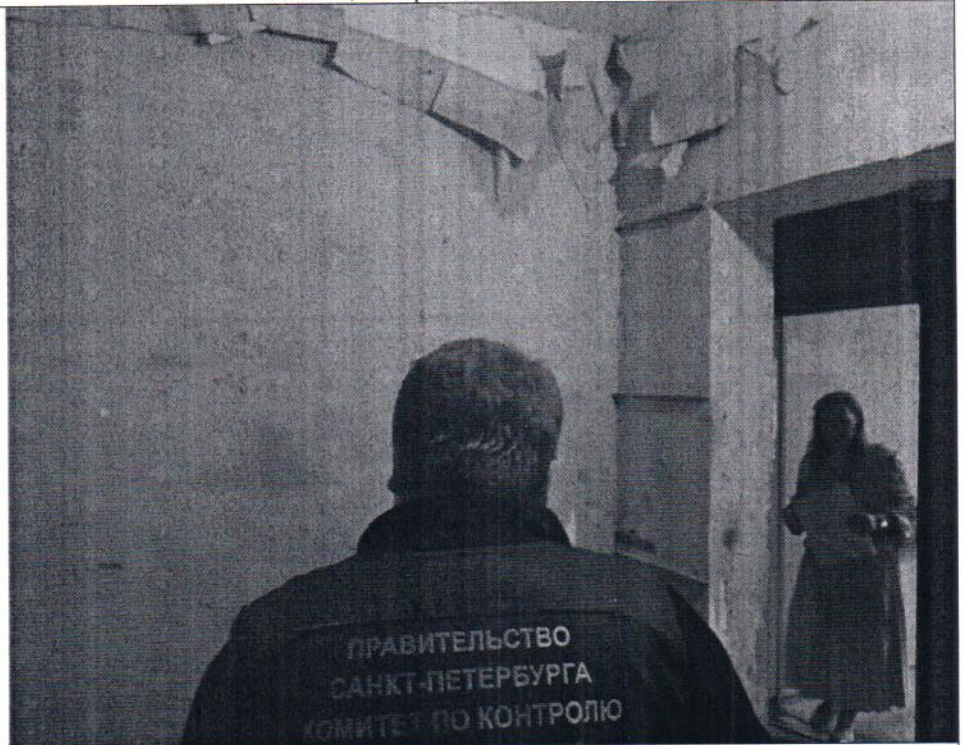
Описание: Вид внутри Объекта
