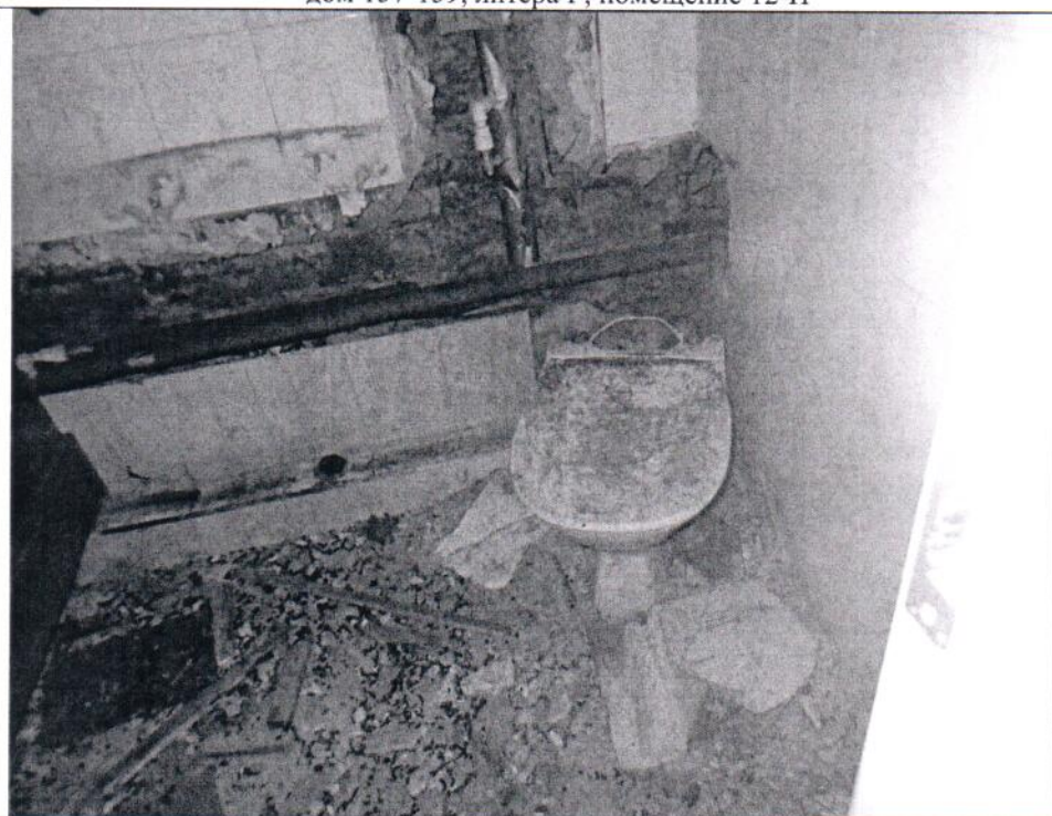
Описание: Вид внутри Объекта (ч.п. 4)
