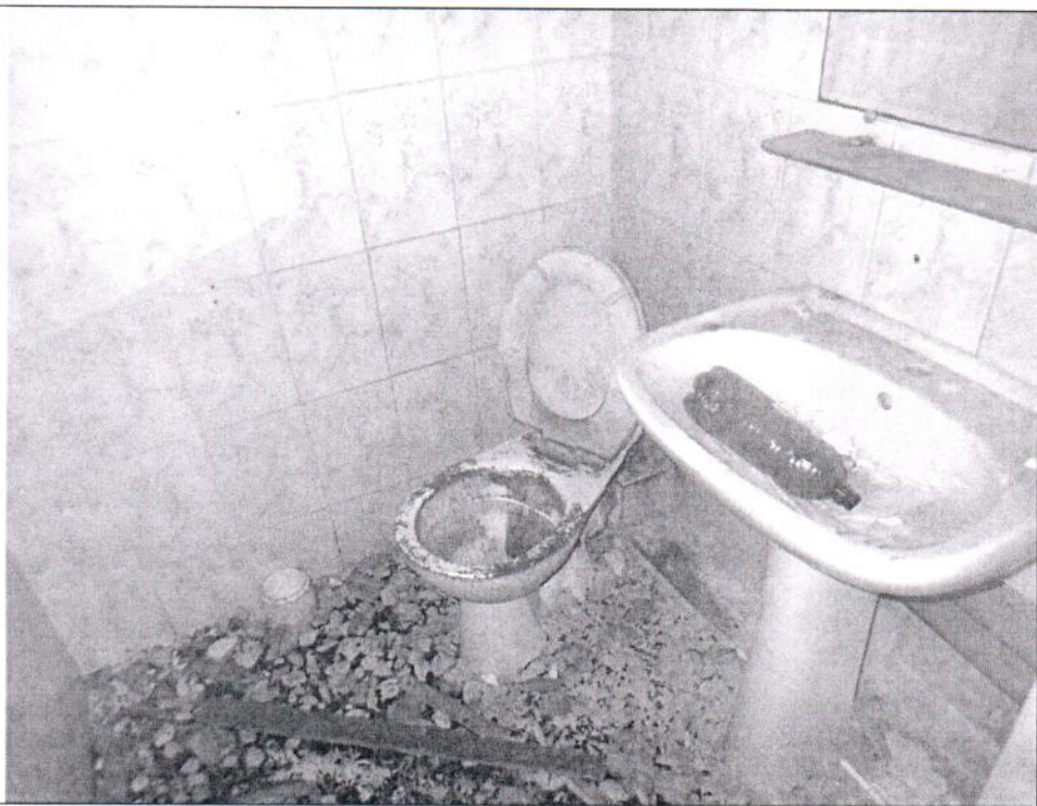
Описание: Вид внутри Объекта (ч.п. 5)
