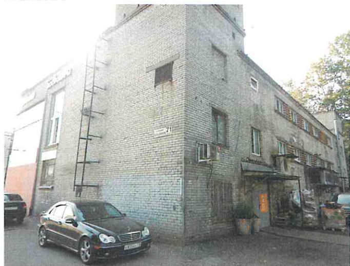
Фото №9 (вход в пом.1-Н)
