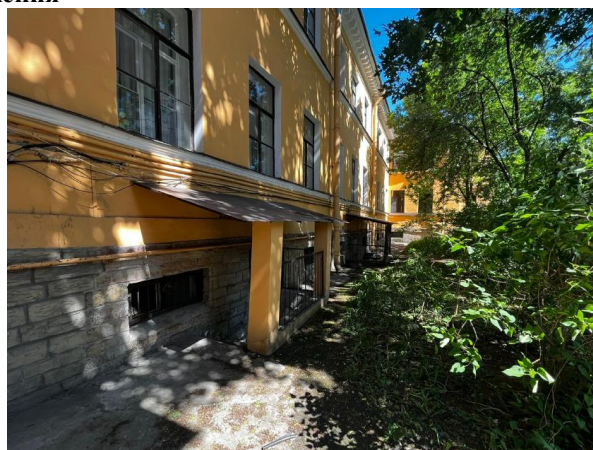
Фото 2. Вид здания Объекта оценки
