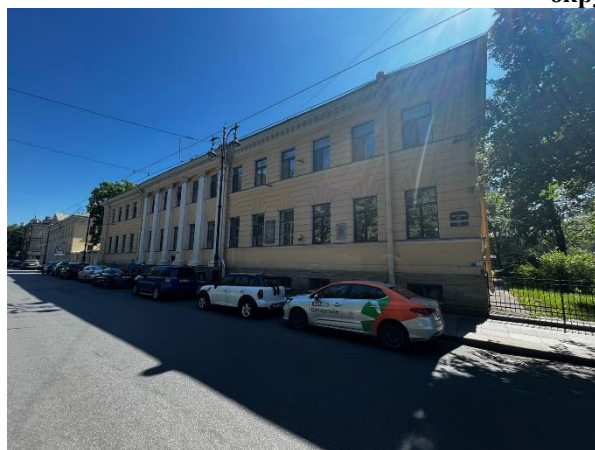
Фото 1. Вид здания Объекта оценки
