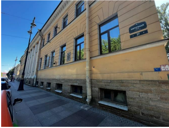
Фото 3. Вид здания Объекта оценки
