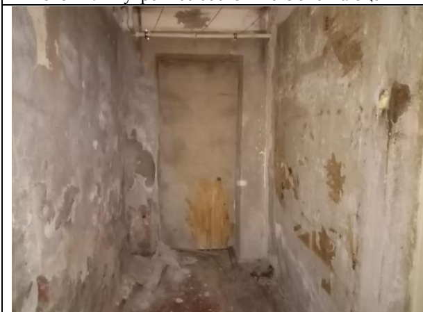
Фото 13. Внутреннее состояние Объекта оценки
