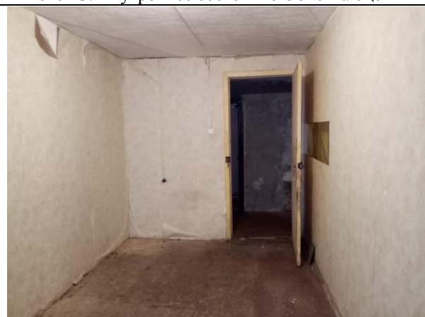
Фото 21. Внутреннее состояние Объекта оценки
