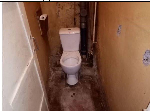
Фото 19. Внутреннее состояние Объекта оценки
