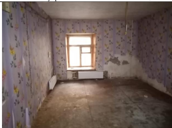
Фото 20. Внутреннее состояние Объекта оценки
