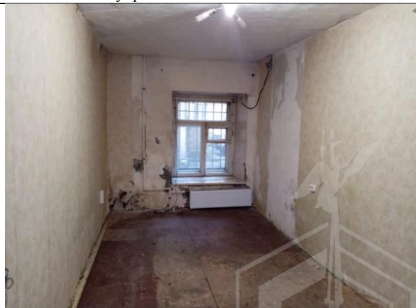
Фото 24. Внутреннее состояние Объекта оценки
