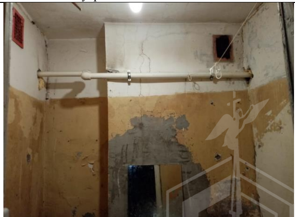
Фото 16. Внутреннее состояние Объекта оценки
