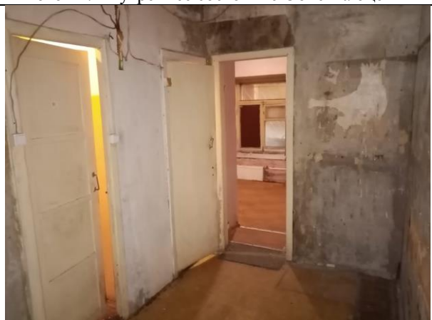
Фото 14. Внутреннее состояние Объекта оценки
