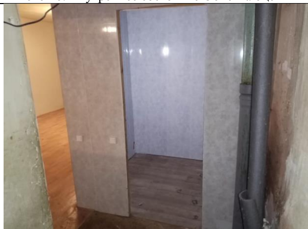
Фото 22. Внутреннее состояние Объекта оценки
