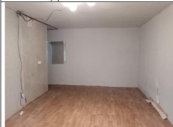
Фото 27. Внутреннее состояние Объекта оценки
