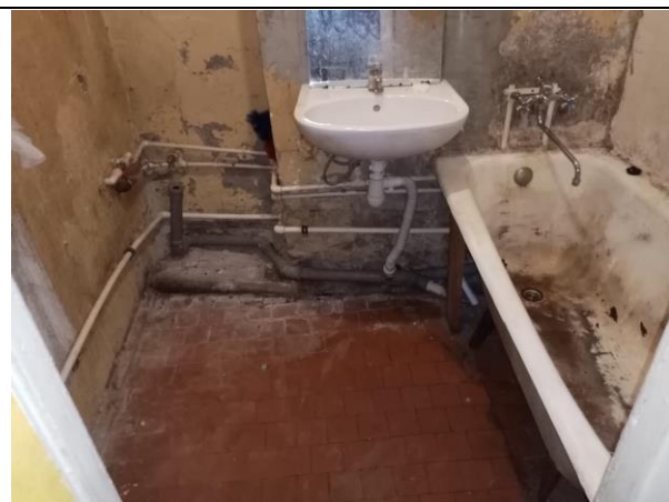
Фото 17. Внутреннее состояние Объекта оценки
