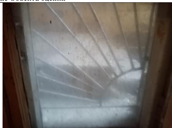
Фото 8. Внутреннее состояние Объекта оценки
