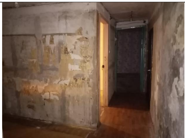
Фото 10. Внутреннее состояние Объекта оценки
