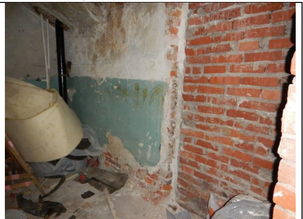
Фото 10. Внутреннее состояние Объекта оценки
