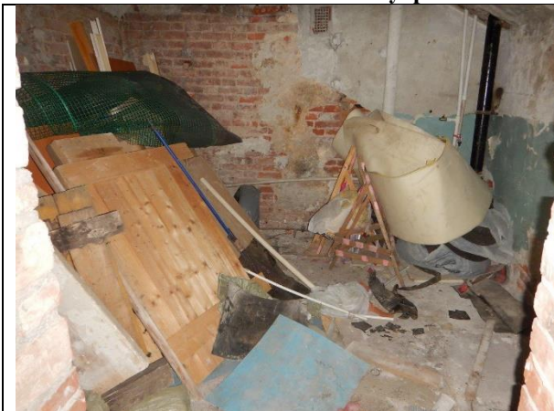
Фото 9. Внутреннее состояние Объекта оценки
