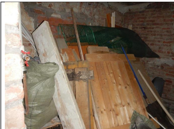
Фото 11. Внутреннее состояние Объекта оценки
