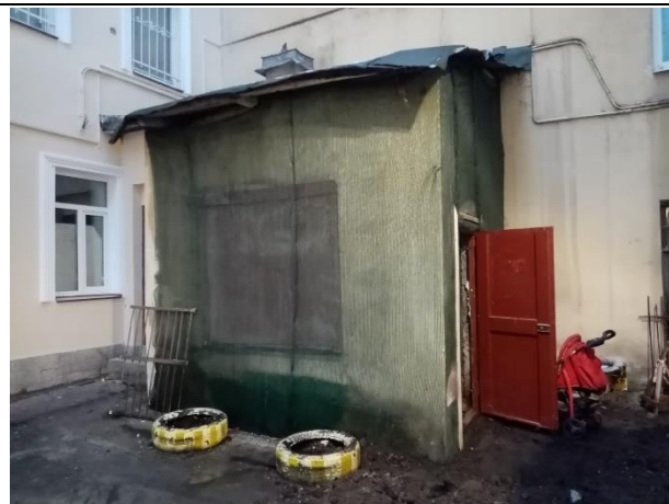
Фото № 8. Внешний вид здания
