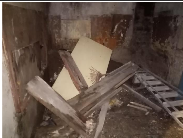
Фото № 12. Внутреннее состояние здания
