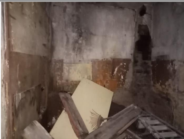
Фото № 13. Внутреннее состояние здания
