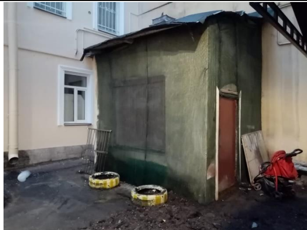
Фото № 6. Внешний вид здания
