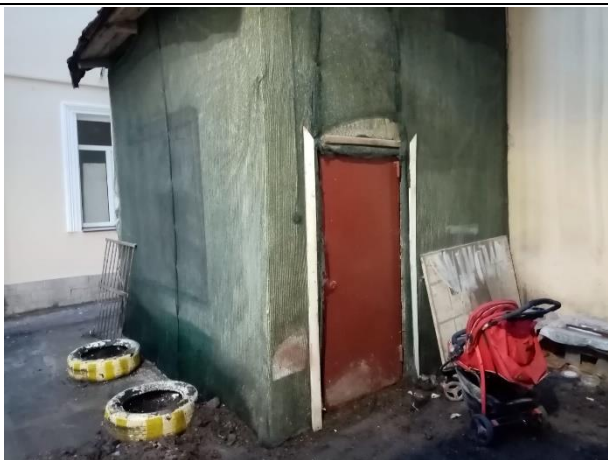
Фото № 7. Внешний вид здания
