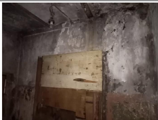
Фото № 14. Внутреннее состояние здания
