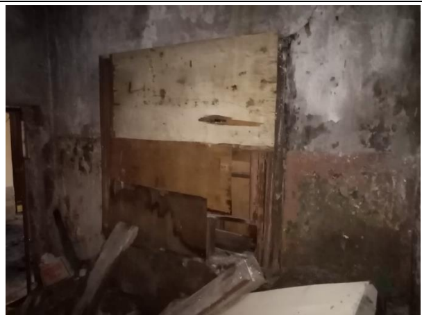
Фото № 9. Внутреннее состояние здания
