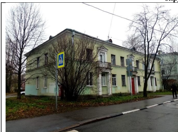
Фото 1. Вид здания, в котором расположен Объект оценки
