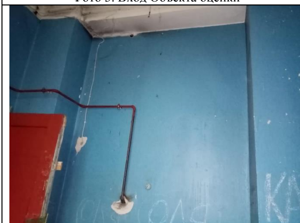
Фото 7. Внутреннее состояние Объекта оценки
