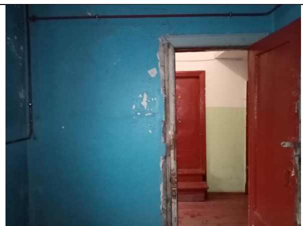
Фото 10. Внутреннее состояние Объекта оценки
