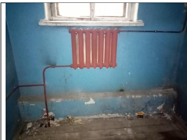
Фото 9. Внутреннее состояние Объекта оценки
