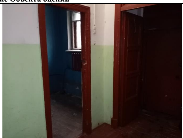
Фото 6. Внутреннее состояние Объекта оценки
