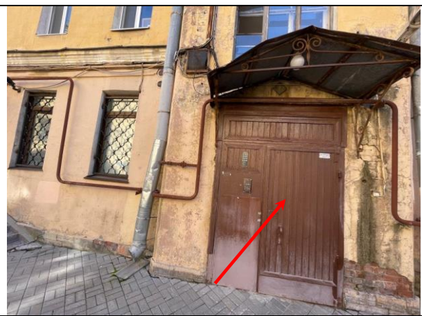
Фото 38. Входная группа Объекта оценки (вход в подвезд)
