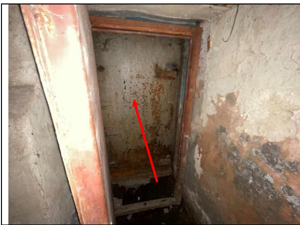
Фото 37. Входная группа Объекта оценки (вход в подвезд)
