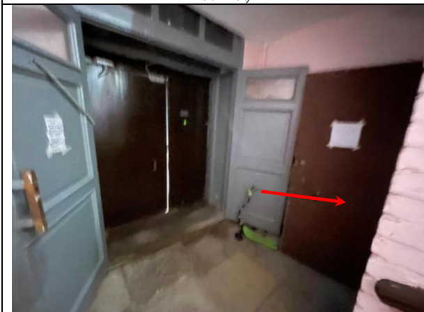
Фото 39. Входная группа Объекта оценки (вход в подвезд)
