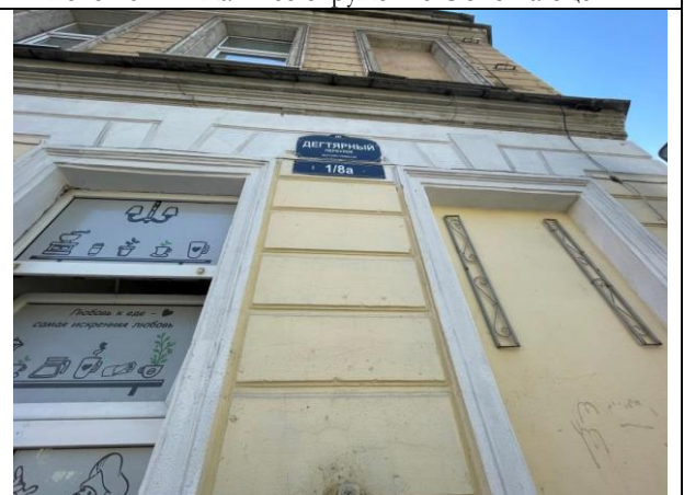
Фото 18. Адрес Объекта оценки
