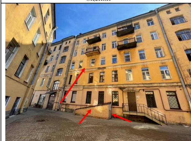
Фото 25. Вид здания расположения Объекта оценки
