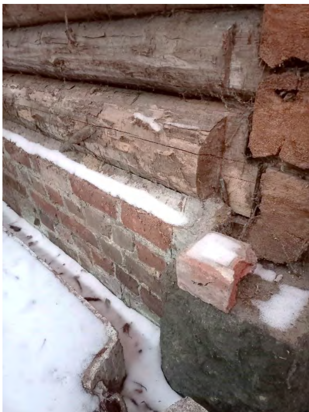
Фото 52. Угол южного и восточного фасадов
