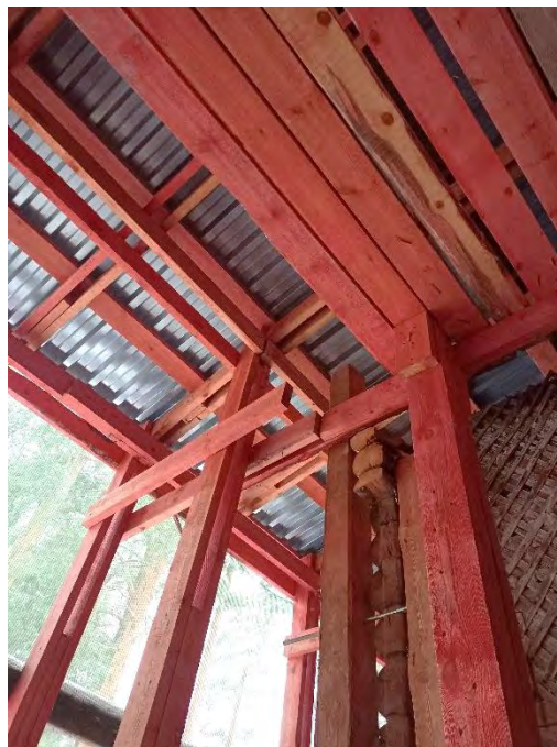
Фото 67. Вид из ч.п.3 (комната) пом.4 (второй этаж)
