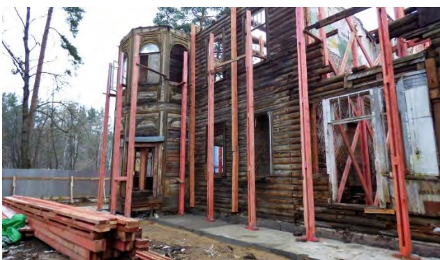
Фото 39. Первоочередные противоаварийные работы на Объекте в 2019 г.
