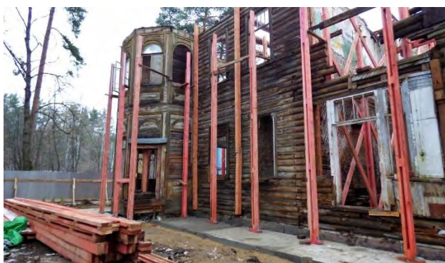
Фото 39. Первоочередные противоаварийные работы на Объекте в 2019 г.
