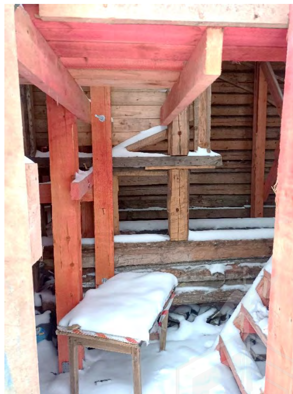
Фото 44. Единственный вход через ограждение каркаса к северному фасаду ОКН
