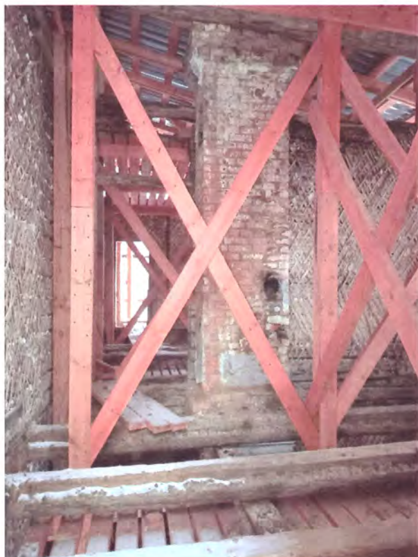
Фото 70. Вид на одно из помещений второго этажа
