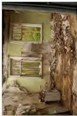
Фото 23. Вид из инспекции до начала профилактических работ по Облгосжилнадзору в 2019 г.
