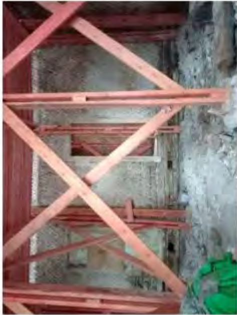
Фото 59. Вид на одно из помещений первого этажа с зашпаклеванной фальшивой
