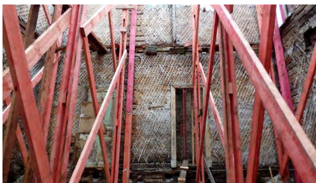
Фото 41. Первоочередные противоаварийные работы на Объекте в 2019 г.
