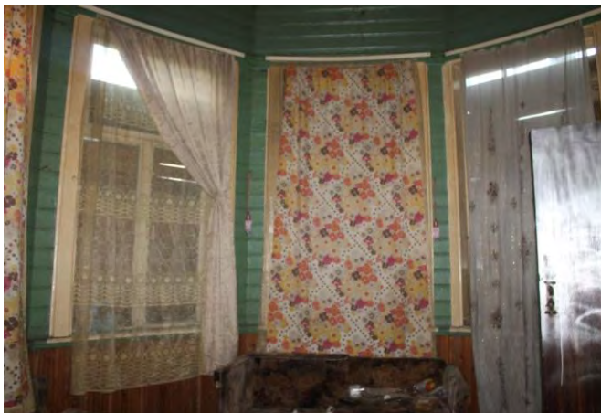
Фото 21. Виды интерьеров до начала противоаварийных работ на Объекте в 2019 г.
