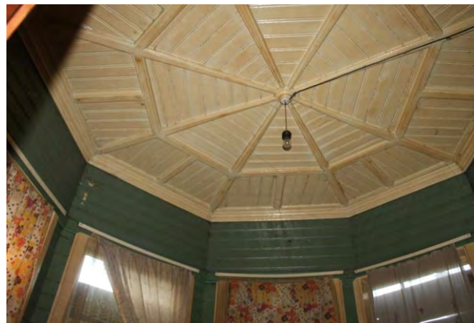
Фото 22. Виды интерьеров до начала противоаварийных работ на Объекте в 2019 г.
