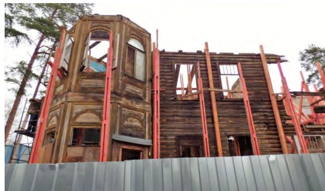
Фото 37. Первоочередные противоаварийные работы на Объекте в 2019 г.
