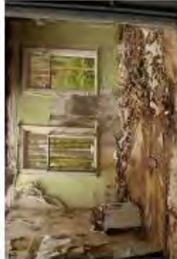
Фото 32. Вид из инспекции до начала профилактических работ по Облгосжилнадзору в 2019 г.
