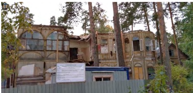
Фото 36. Первоочередные противоаварийные работы на Объекте в 2019 г.
