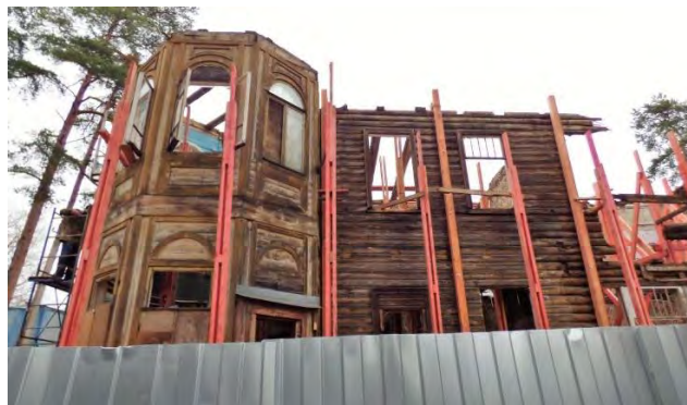
Фото 37. Первоочередные противоаварийные работы на Объекте в 2019 г.
