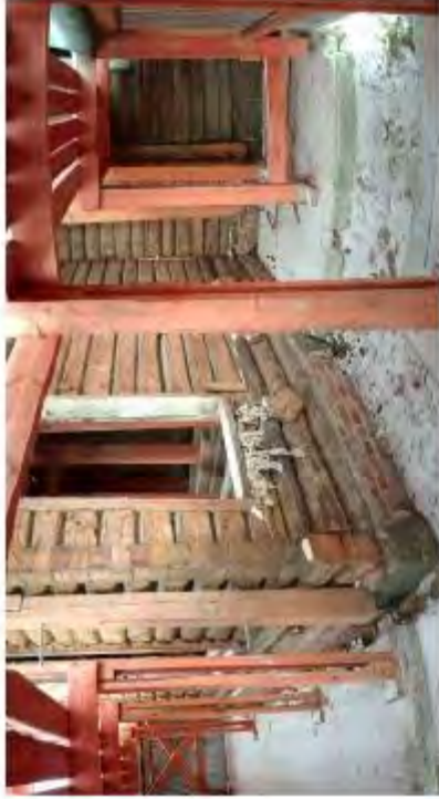
Фото 56. Углы казенного и сеченого обшивки здания
