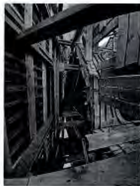
18. Временные защитные конструкции над объектом северо-западной башни
