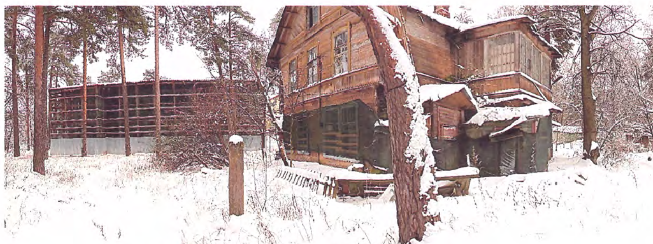
Фото 72. Вид на западный фасад и прилегающую территорию (со стороны соседнего участка и здания дом 8а, литера А)
