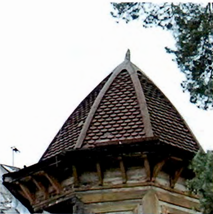
Фото 5. Фрагмент северного фасада. Крыша.
