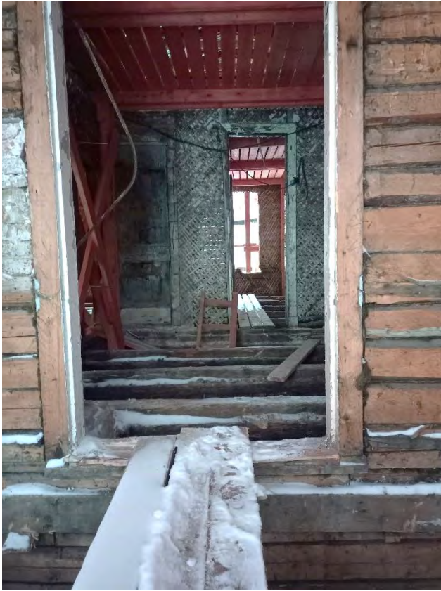
Фото 62. Вид на одно из помещений второго этажа
