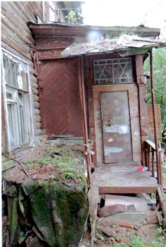
Фото 8. Крыльцо западного фасада
