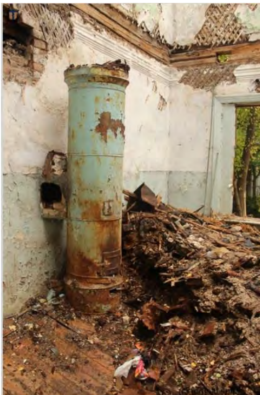
Фото 33. Виды интерьеров до начала противоаварийных работ на Объекте в 2019 г.
