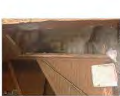
Фото 28. Вид из интерьера до начала проектно-сметных работ на Объекте в 2019 г.
