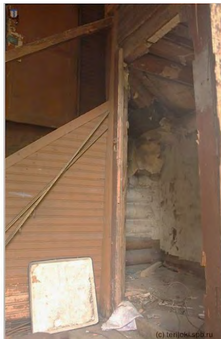
Фото 28. Виды интерьеров до начала противоаварийных работ на Объекте в 2019 г.
