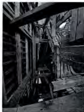
18. Временные защитные конструкции над объемом северо-западной башни
