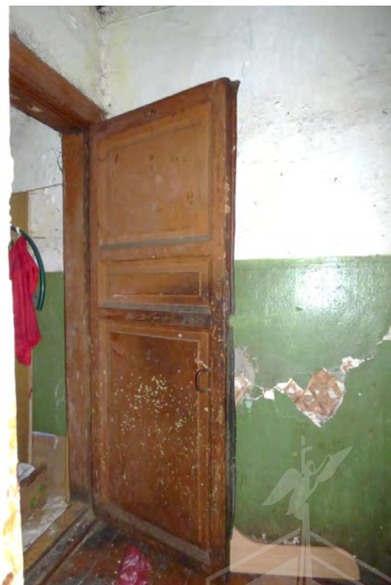
Фото 14. Виды интерьеров до начала противоаварийных работ на Объекте в 2019 г.
