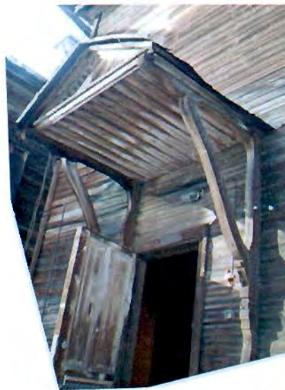
Фото 9. Фрагмент южного фасада. Козырек над крыльцом
