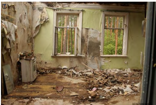
Фото 23. Виды интерьеров до начала противоаварийных работ на Объекте в 2019 г.
