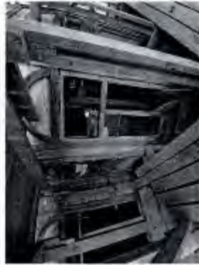
6. Фронтонт северо-западной башни
