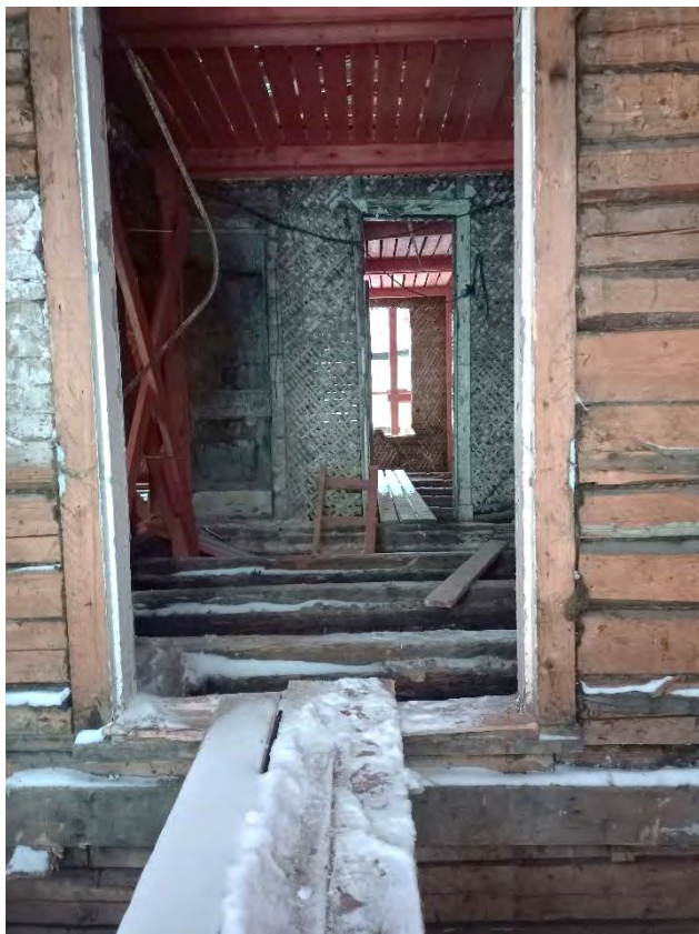
Фото 62. Вид на одно из помещений второго этажа
