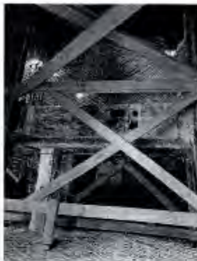
16. Состояние сохранившихся дымоходов
