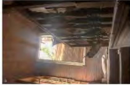
Фото 26. Вид из инспектора до начала профилактических работ по Обществу в 2019 г.
