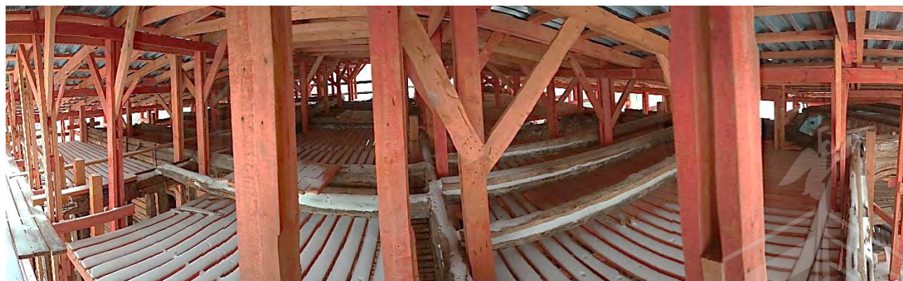
Фото 69. Панорамный вид подкровельное пространство каркаса
