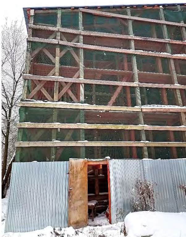
Фото 43. Единственный вход через ограждение каркаса к северному фасаду ОКН
