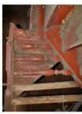
Фото 19. Вид изнутри до начала реконструкционных работ на объекте в 2019 г.
