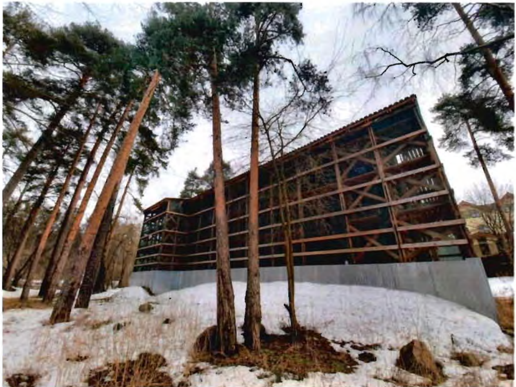
4. Общий вид на западный фасад объекта культурного наследия
