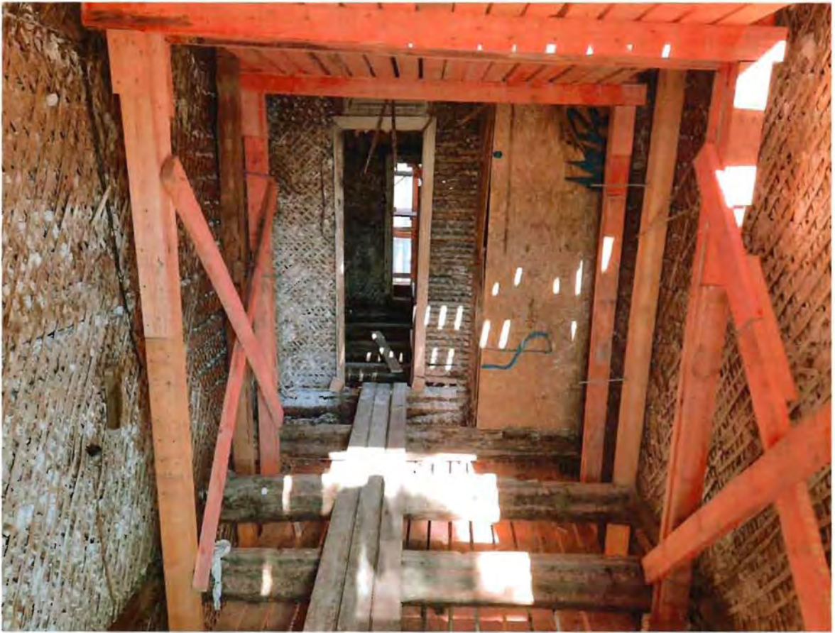
4. Вид на внутренние конструкции
