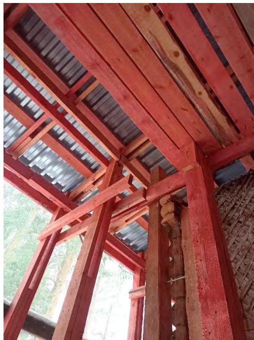
Фото 67. Вид из ч.п.3 (комната) пом.4 (второй этаж)
