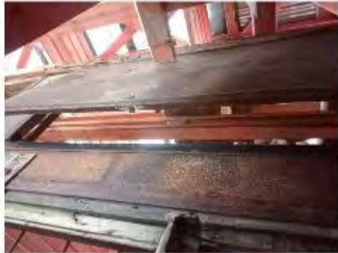
Фото 47. Восточный фасад, вид из с.Х. (пешеходный 2.ПК)
