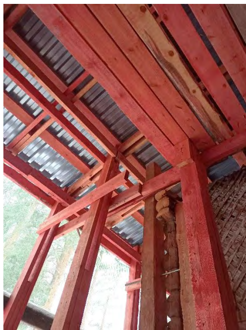
Фото 67. Вид из ч.п.3 (комната) пом.4 (второй этаж)
