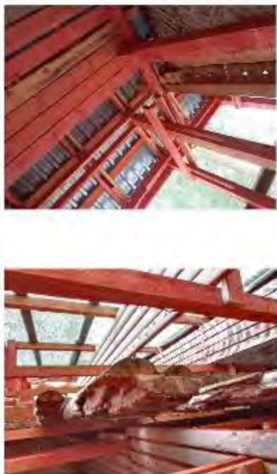
Фото 66. Длинная стена ч.д.х.х.у. (берцовый пояс 4 (второй этаж))
