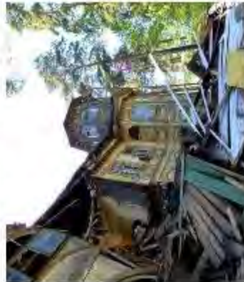
Фото 10. Объект после обрушения в 2018 г.
