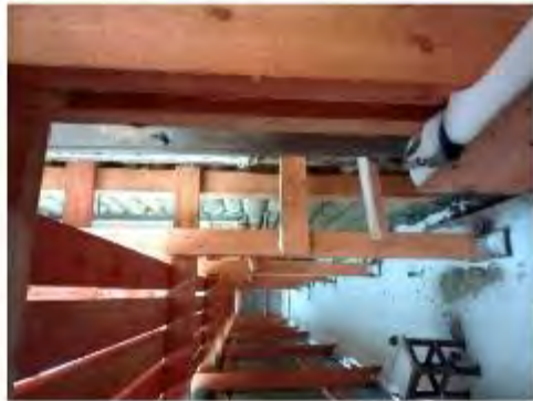
Фото 46. Угол потолка и северного фасадов
