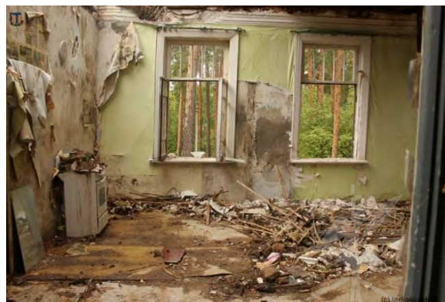
Фото 32. Виды интерьеров до начала противоаварийных работ на Объекте в 2019 г.
