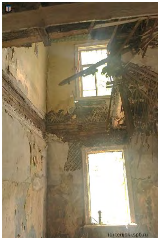
Фото 34. Виды интерьеров до начала противоаварийных работ на Объекте в 2019 г.
