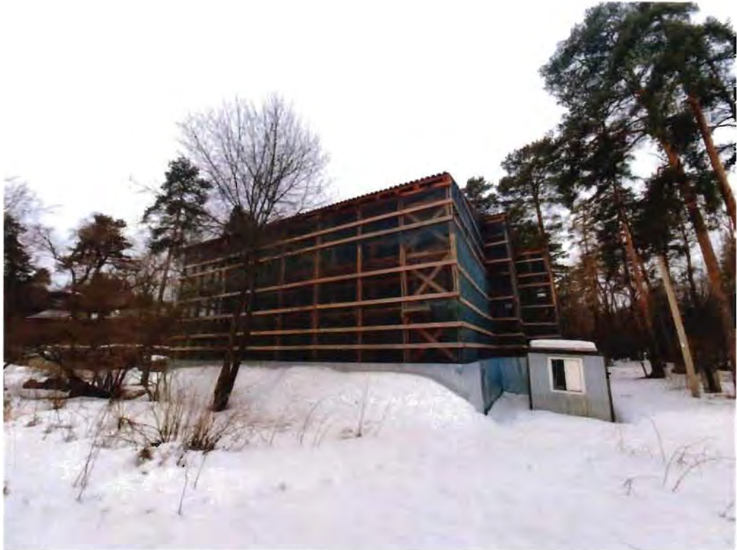
2. Общий вид на восточный фасад объекта культурного наследия
