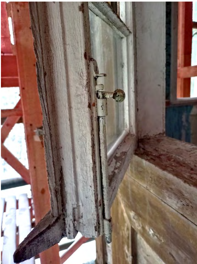
Фото 64. Фрагмент сохранившегося оконного заполнения и оконной фурнитуры, ч.п.XV (веранда) пом.5 (второй этаж)
