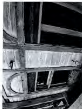
10. Фрагмент северо-западной башни. Состояние стен и отделки
