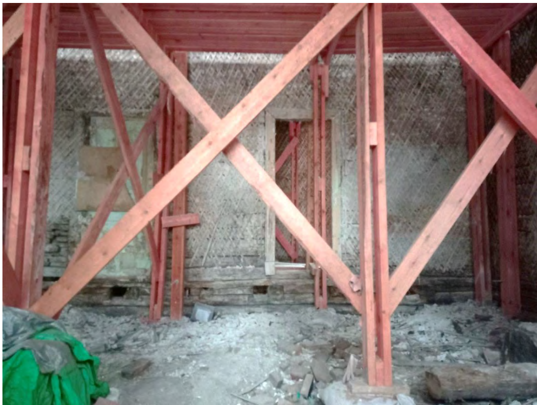
Фото 59. Вид на одно из помещений первого этажа с западного фасада
