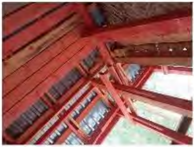
Фото 67. Длинная стена ч.п.д. №2 (второй этаж)
