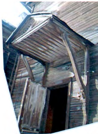
Фото 9. Фрагмент южного фасада. Козырек над крыльцом
