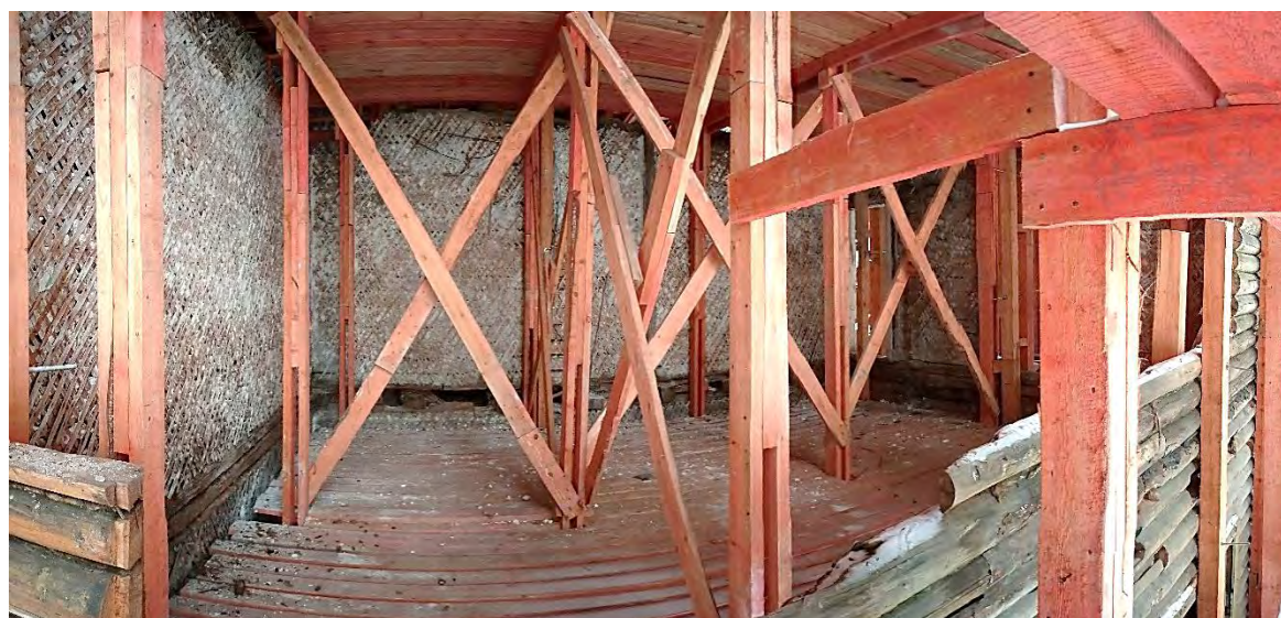
Фото 68. Вид на ч.п.3 (комната) пом.4 (второй этаж)
