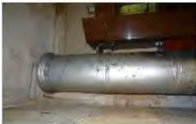
Фото 15. Вид из интерьера до начала проектно-проектировочных работ на Объекте в 2019 г.
