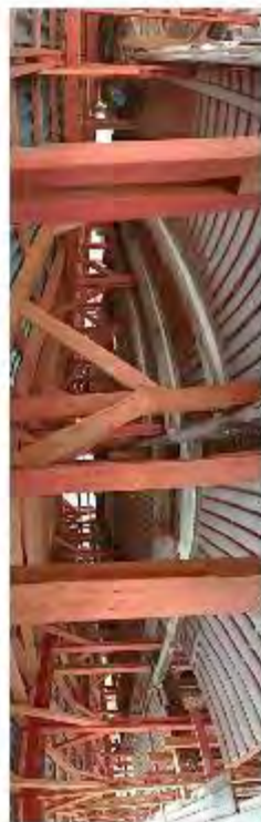
Фото 69. Перекрестный тип перекрытия: просекание стропила
