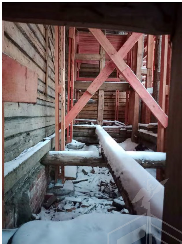
Фото 51. Вид на ч.п.Х (лестничная площадка) 2ЛК
