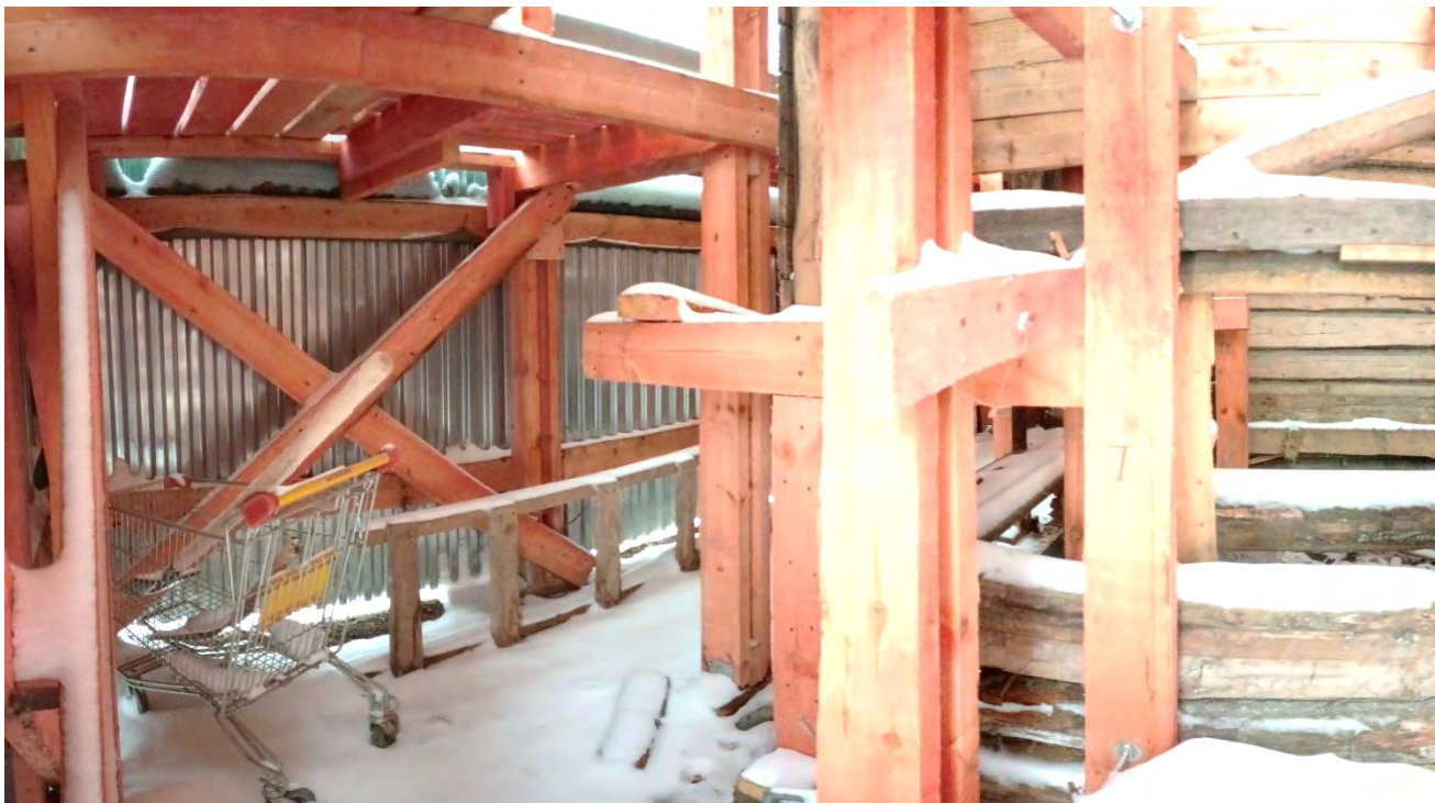
Фото 45. Угол восточного и северного фасадов
