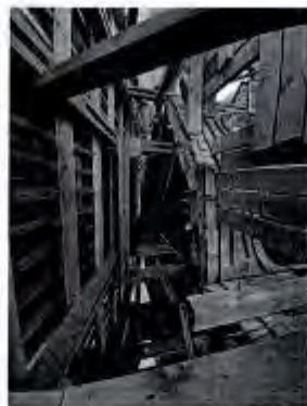
18. Временные защитные конструкции над объектом северо-западной башни
