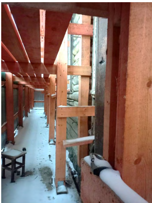
Фото 46. Угол восточного и северного фасадов
