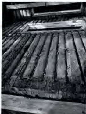
9. Фригмент фасада объекта культурного наследия. Состояние бревенчатых стен
