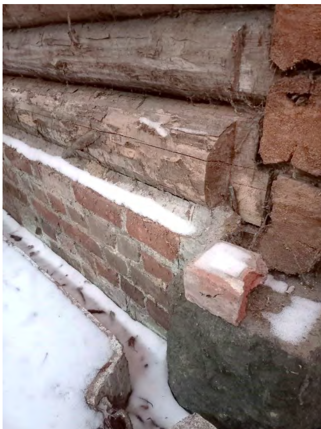
Фото 52. Угол южного и восточного фасадов
