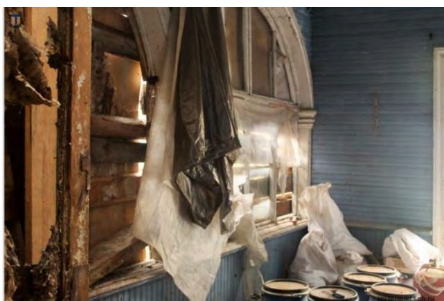
Фото 29. Виды интерьеров до начала противоаварийных работ на Объекте в 2019 г.
