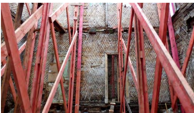
Фото 41. Первоочередные противоаварийные работы на Объекте в 2019 г.
