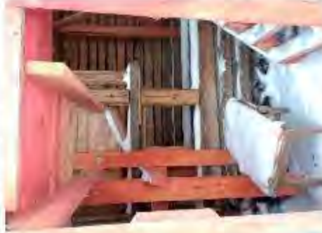
Фото 44. Более подробный вид на крышу (дерево) чердака в северную фасадную ОКН
