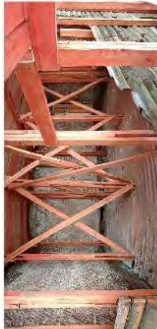
Фото 68. Вид на ч.п.3 (второй этаж), сов.4 (второй этаж)
