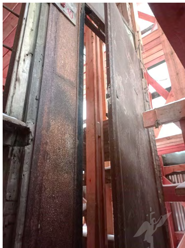
Фото 47. Восточный фасад, вход в ч.п.Х (лестничная площадка) 2ЛК
