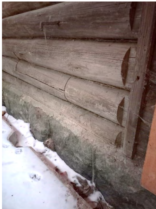
Фото 49. Восточный фасад, цоколь
