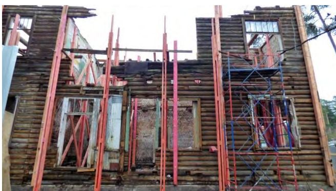
Фото 38. Первоочередные противоаварийные работы на Объекте в 2019 г.
