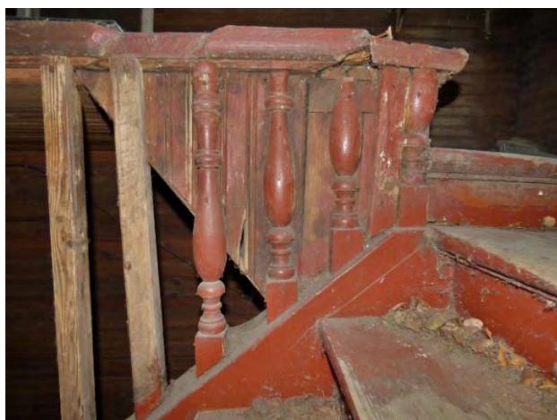
Фото 19. Виды интерьеров до начала противоаварийных работ на Объекте в 2019 г.
