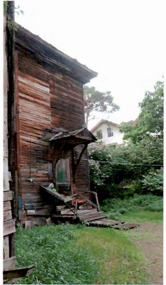
Фото 4. Фрагмент южного фасада
