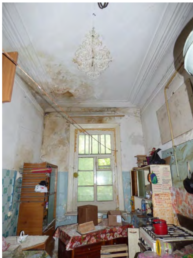
Фото 13. Виды интерьеров до начала противоаварийных работ на Объекте в 2019 г.
