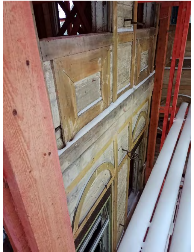
Фото 63. Фрагмент северного фасада со второго этажа
