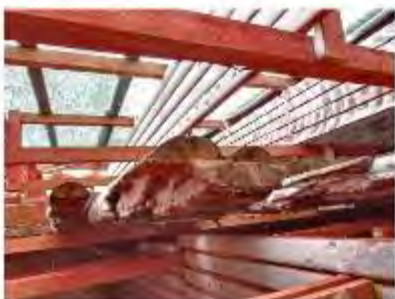
Фото 66. Длинная стена ч.п.д. №1 (второй этаж)
