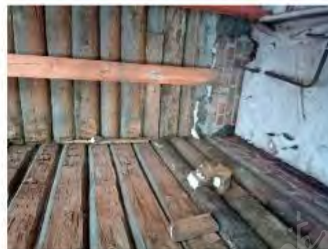
Фото 54. Угол юго-западного и восточного объемов здания
