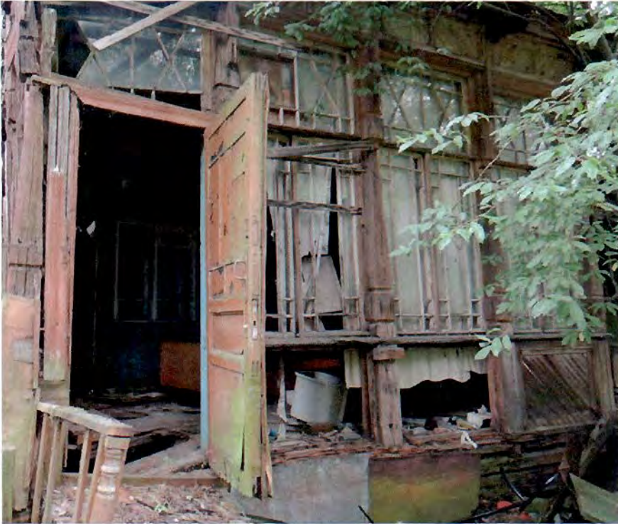
Фото 7. Веранда западного фасада
