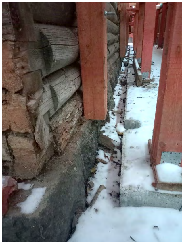
Фото 50. Восточный фасад, цоколь
