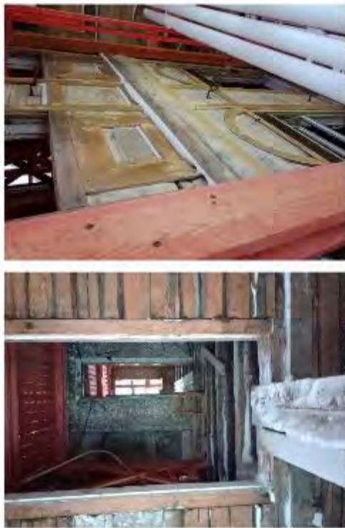
Фото 62. Вид на окно из помещения второго этажа
