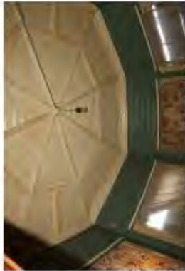
Фото 22. Вид из инспекции до начала профилактических работ по Облгосжилнадзору в 2019 г.
