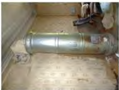
Фото 16. Вид изнутри до начала реконструкционных работ на объекте в 2019 г.
