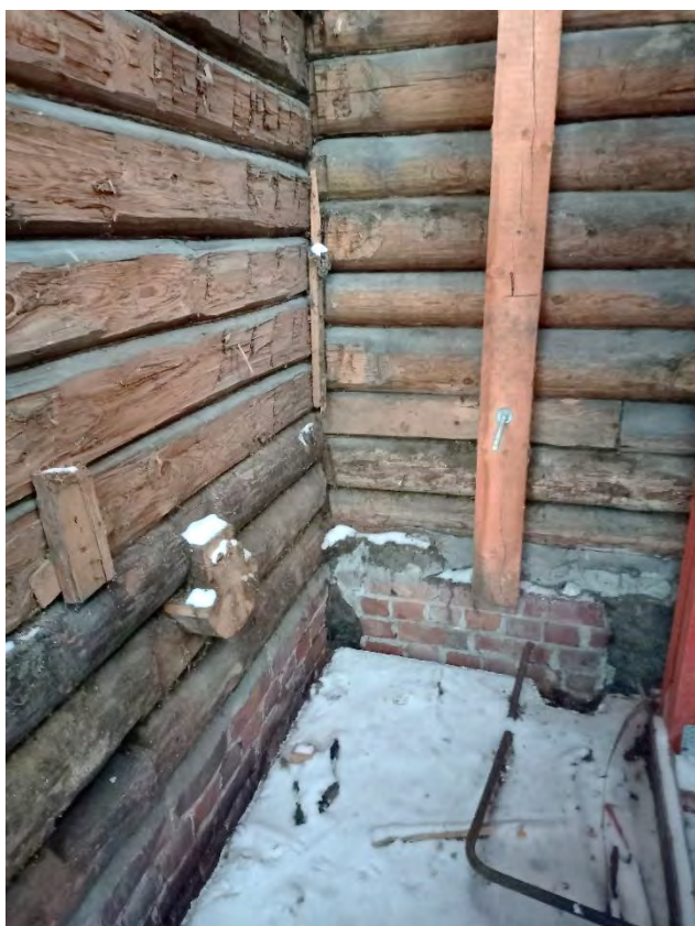
Фото 54. Угол юго-западного и основного объемов здания
