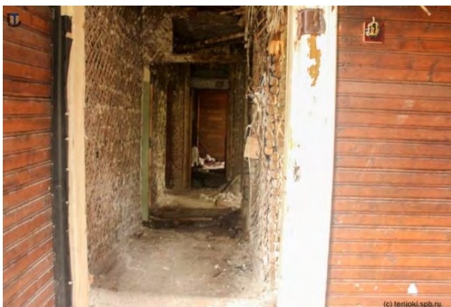
Фото 31. Виды интерьеров до начала противоаварийных работ на Объекте в 2019 г.
