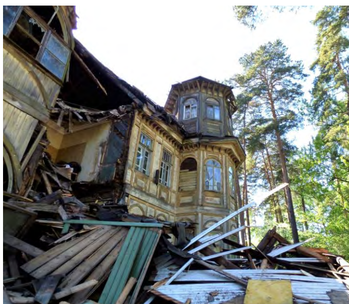
Фото 10. Объект после обрушения в 2018 г.
