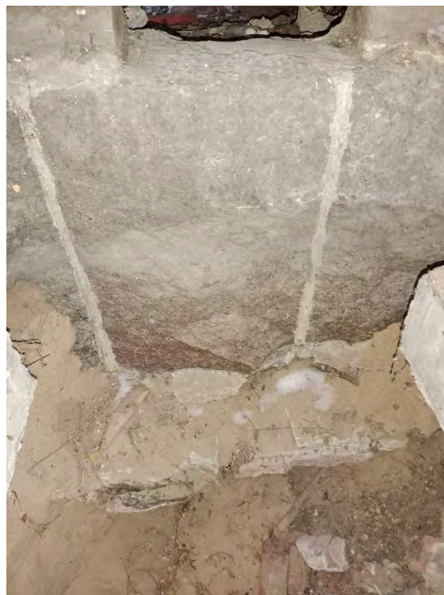
Фото 53. Цоколь южного фасада
