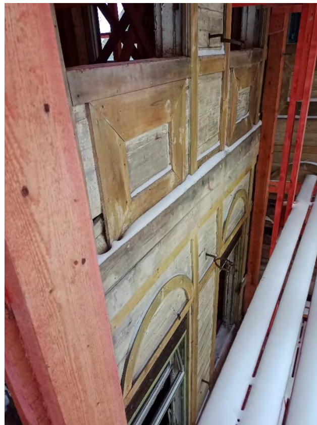
Фото 63. Фрагмент северного фасада со второго этажа
