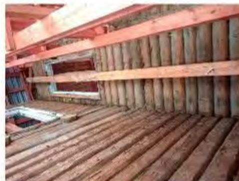
Фото 55. Угол юго-западного и основного объемов здания
