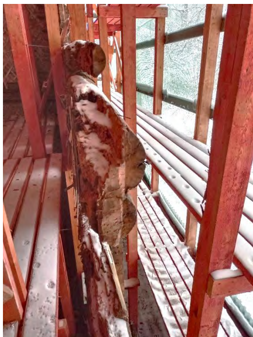
Фото 66. Вид на стену ч.п.3 (комната) пом.4 (второй этаж)
