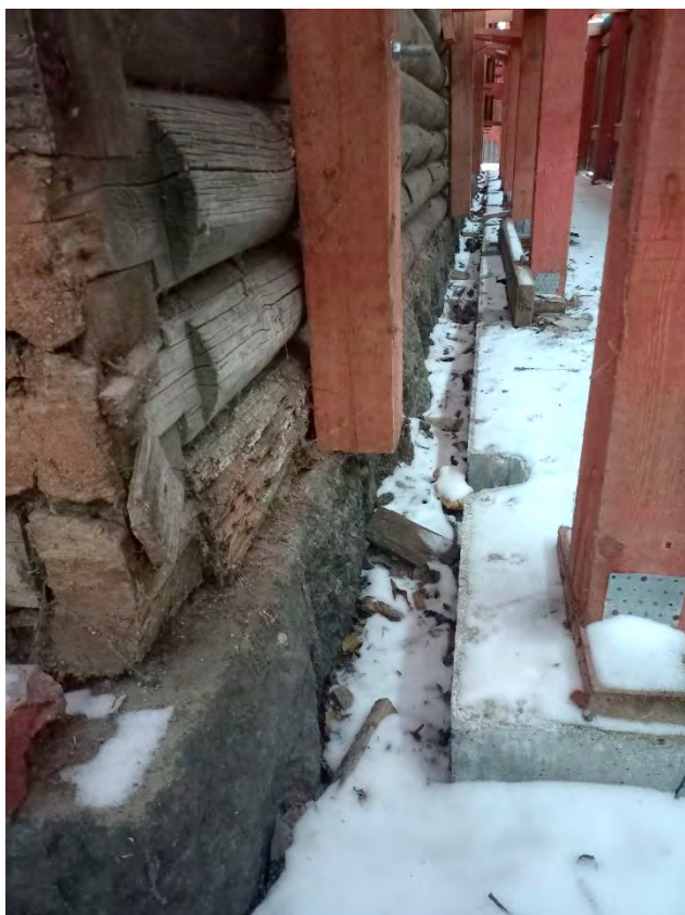
Фото 50. Восточный фасад, цоколь
