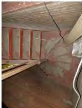
Фото 17. Вид изнутри до начала реконструкционных работ на объекте в 2019 г.
