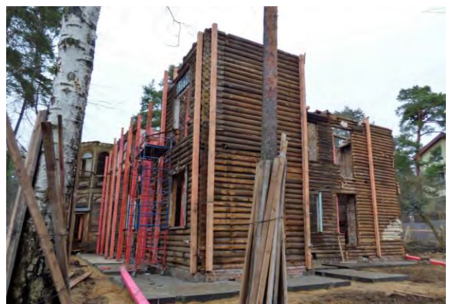
Фото 40. Первоочередные противоаварийные работы на Объекте в 2019 г.
