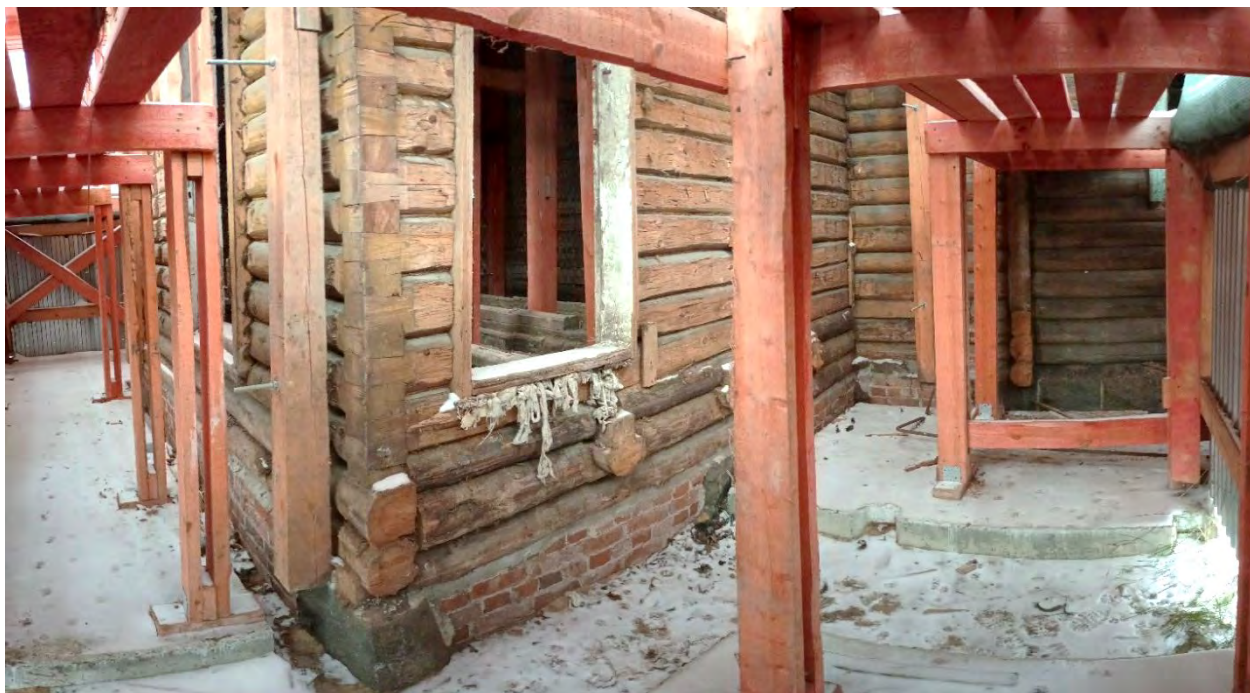
Фото 56. Угол юго-западного и основного объемов здания
