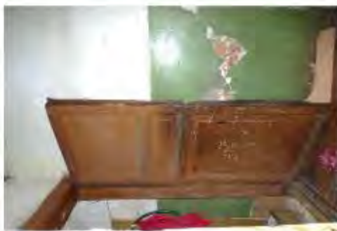
Фото 14. Вид из интерьера до начала проектировочных работ на Объекте в 2019 г.
