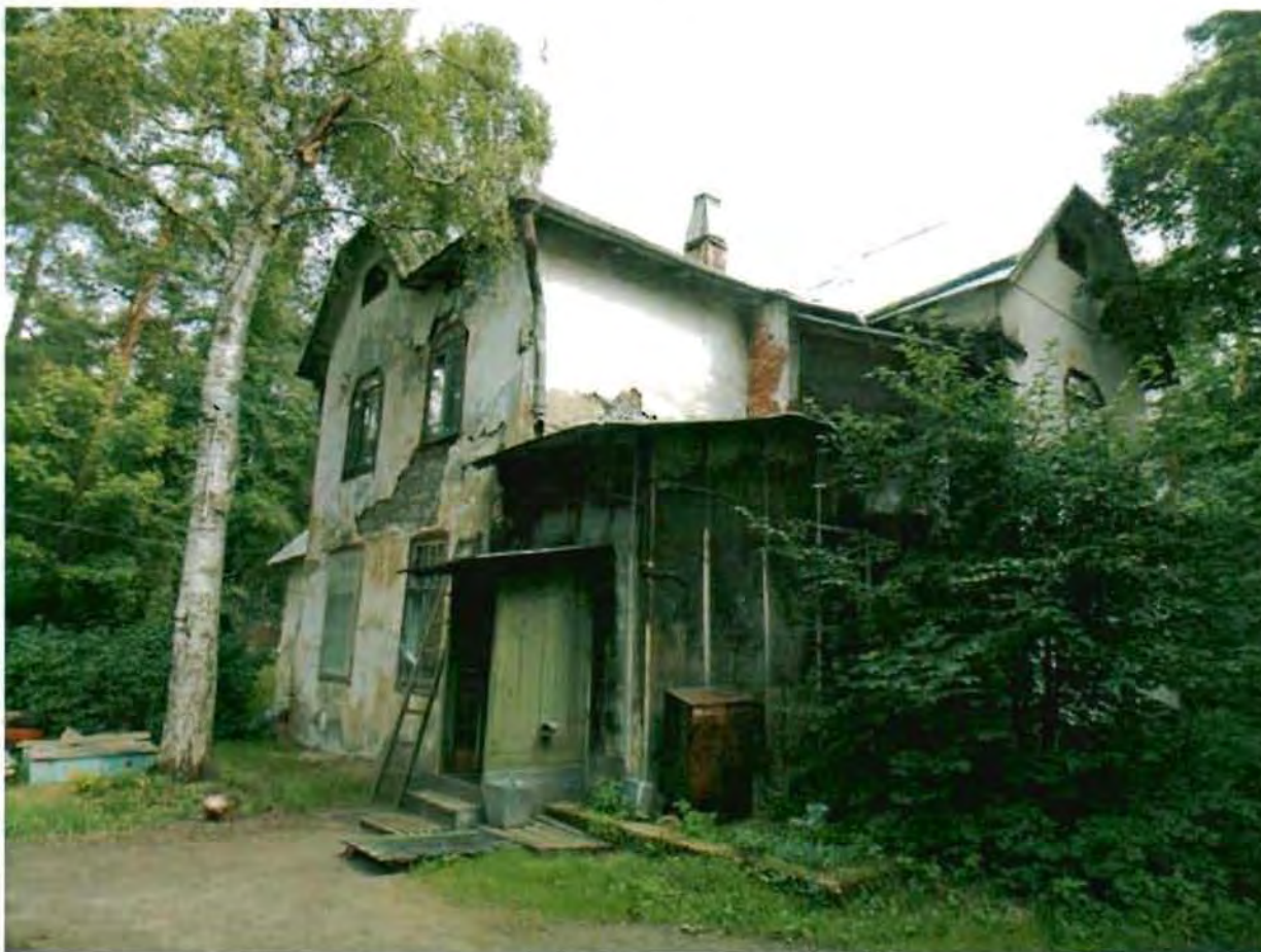
2. Западный и южный фасады
