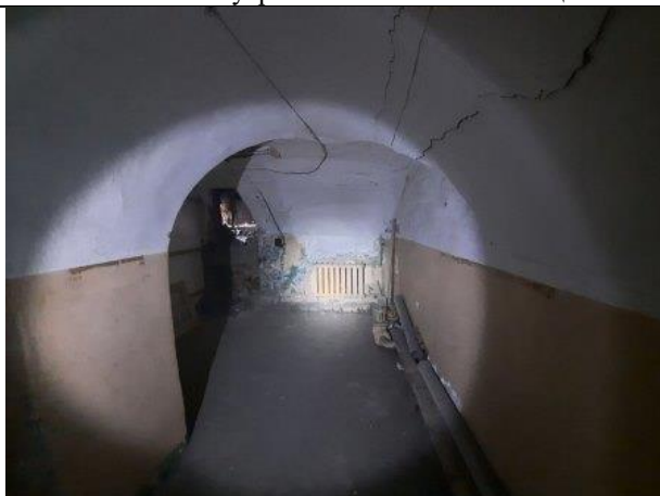
Фото № 11 – Внутреннее состояние помещения
