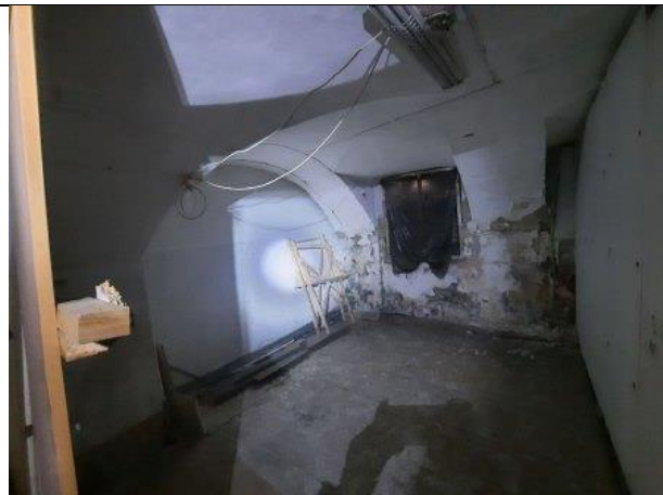
Фото № 14 – Внутреннее состояние помещения
