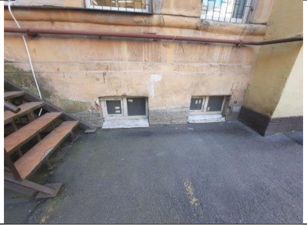
Фото № 6 – Окна помещения
