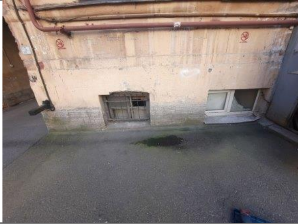
Фото № 7 – Окна помещения
