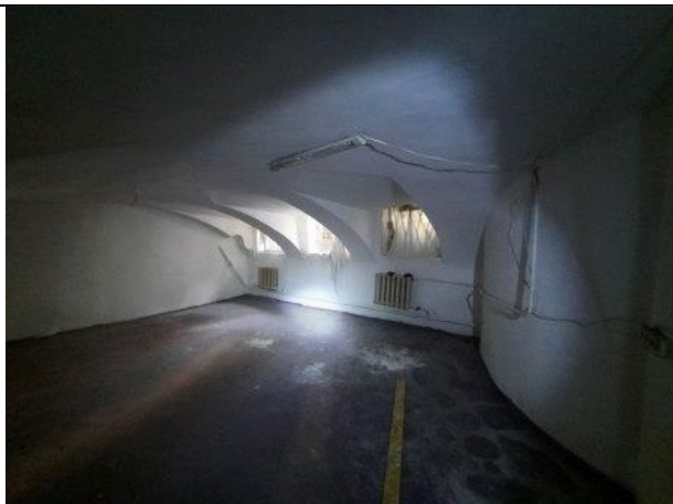
Фото № 13 – Внутреннее состояние помещения
