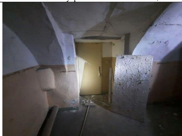
Фото № 18 – Внутреннее состояние помещения
