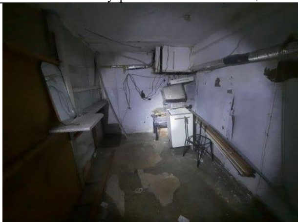
Фото № 19 – Внутреннее состояние помещения
