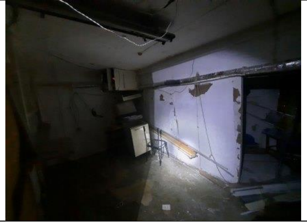
Фото № 22 – Внутреннее состояние помещения
