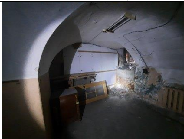
Фото № 9 – Внутреннее состояние помещения
