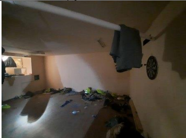
Фото № 15 – Внутреннее состояние помещения
