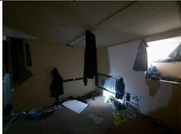
Фото № 16 – Внутреннее состояние помещения
