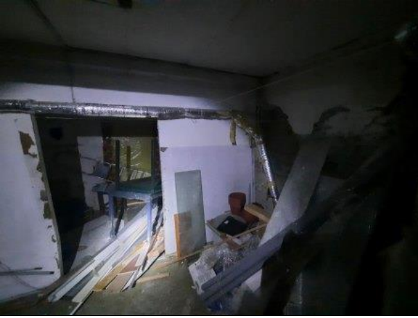
Фото № 21 – Внутреннее состояние помещения
