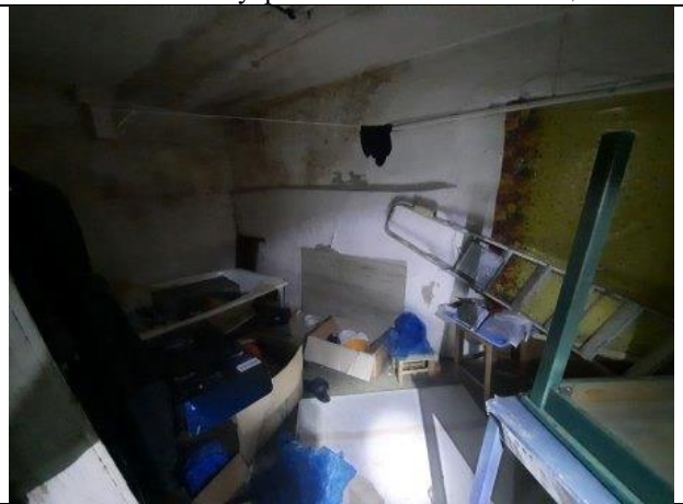
Фото № 10 – Внутреннее состояние помещения
