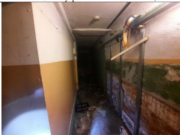
Фото № 17 – Внутреннее состояние помещения
