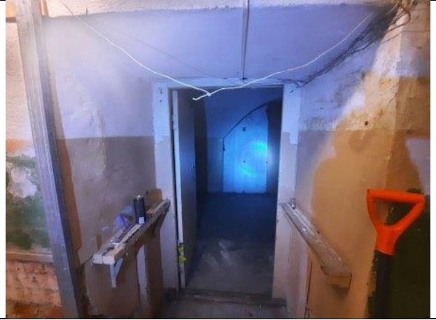
Фото № 8 – Внутреннее состояние помещения
