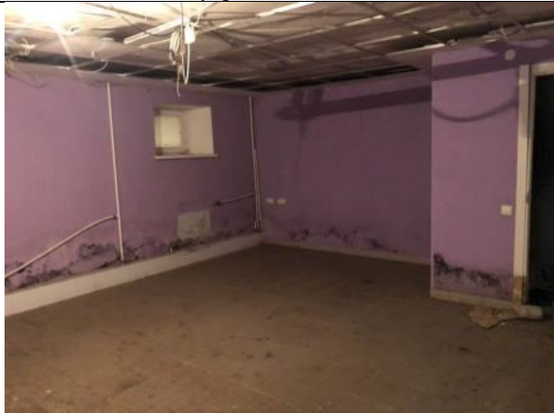
Фото № 17 – Внутреннее состояние помещения
