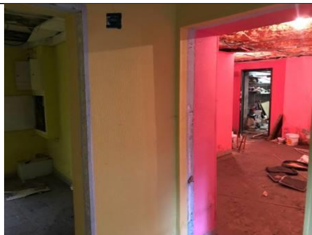
Фото № 22 – Внутреннее состояние помещения
