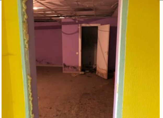
Фото № 16 – Внутреннее состояние помещения
