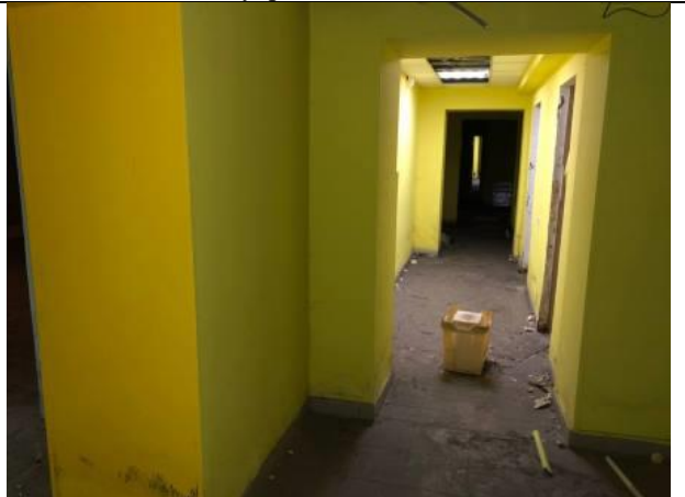
Фото № 18 – Внутреннее состояние помещения
