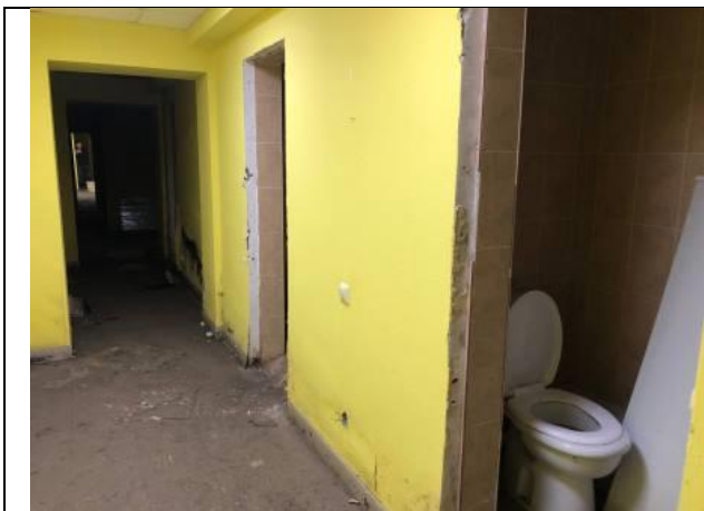
Фото № 21 – Внутреннее состояние помещения
