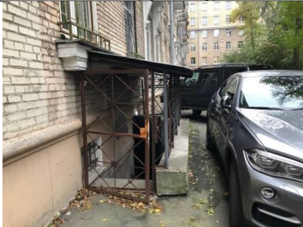
Фото № 7 – Вход в помещение со двора
