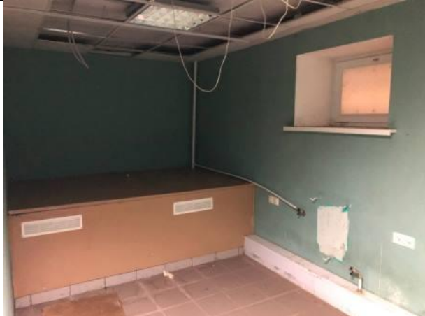
Фото № 15 – Внутреннее состояние помещения
