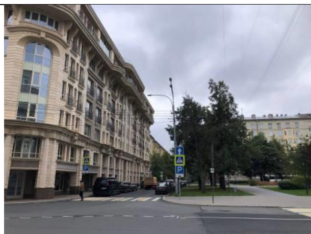
Фото № 2 – Подъездные пути
