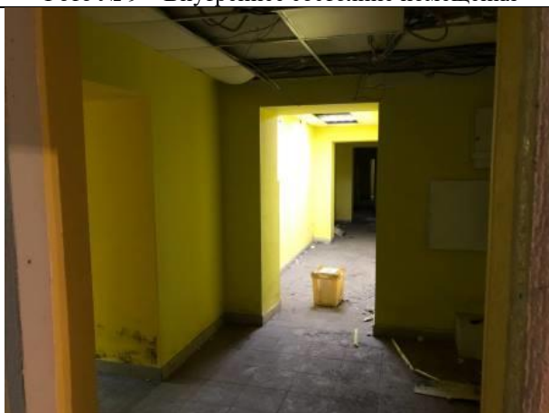
Фото № 11 – Внутреннее состояние помещения
