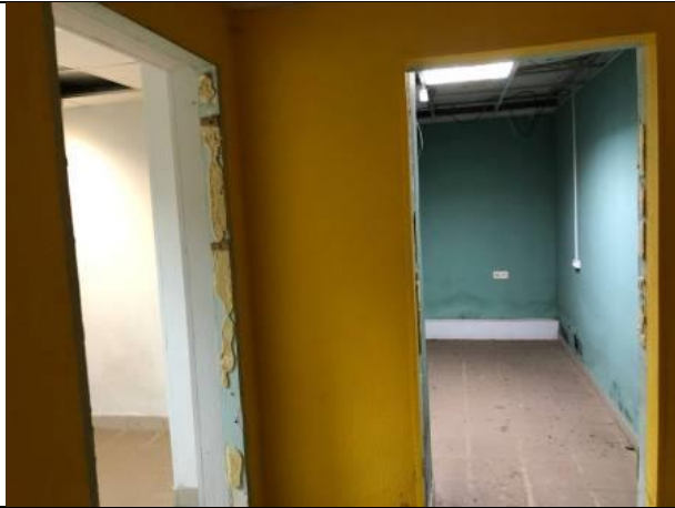
Фото № 13 – Внутреннее состояние помещения
