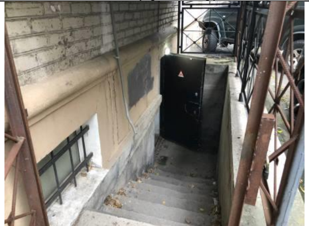
Фото № 8 – Вход в помещение со двора
