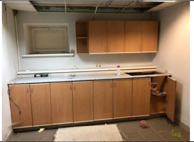
Фото № 14 – Внутреннее состояние помещения
