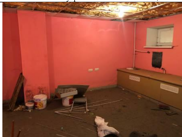
Фото № 24 – Внутреннее состояние помещения
