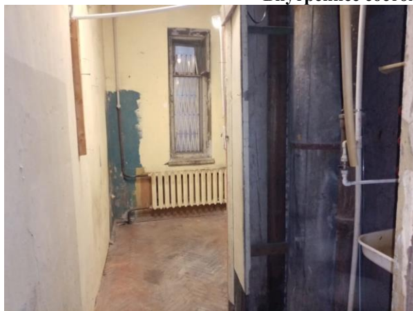
Фото 6. Внутреннее состояние Объекта оценки
