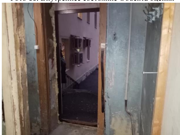
Фото 12. Внутреннее состояние Объекта оценки
