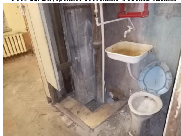
Фото 13. Внутреннее состояние Объекта оценки
