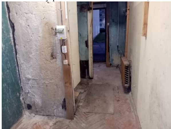
Фото 8. Внутреннее состояние Объекта оценки
