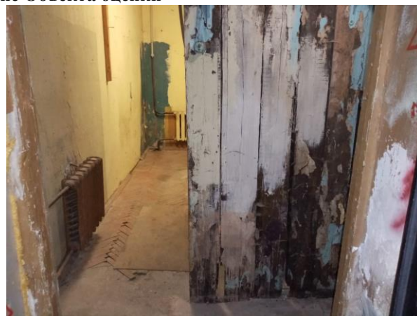
Фото 7. Внутреннее состояние Объекта оценки
