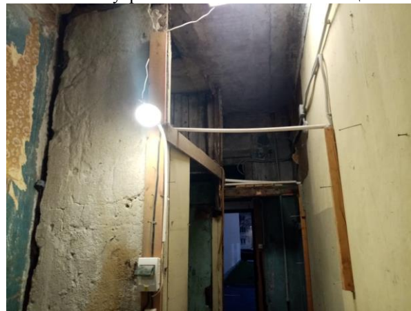
Фото 9. Внутреннее состояние Объекта оценки
