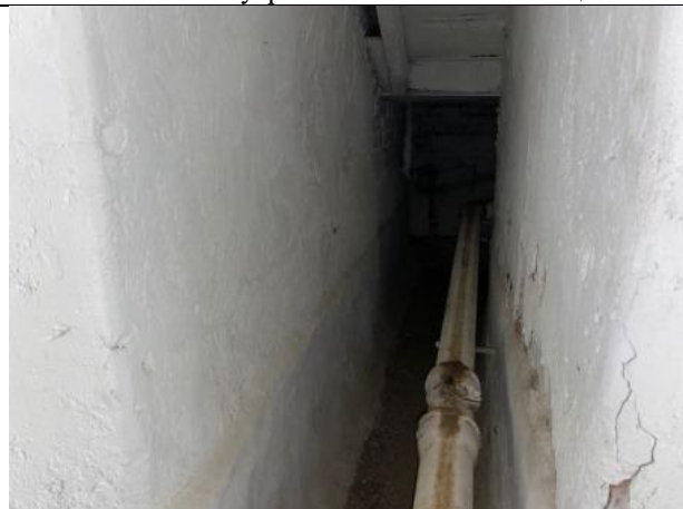
Фото № 10 – Внутреннее состояние помещения
