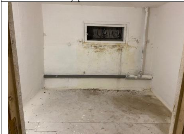
Фото № 13 – Внутреннее состояние помещения
