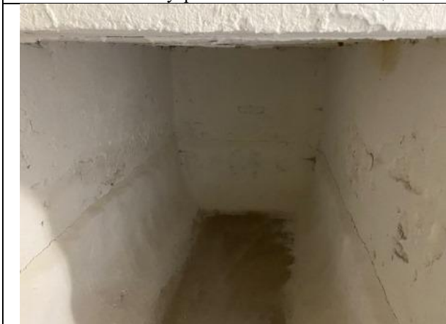
Фото № 9 – Внутреннее состояние помещения
