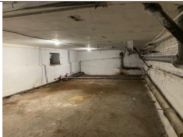
Фото № 24 – Внутреннее состояние помещения
