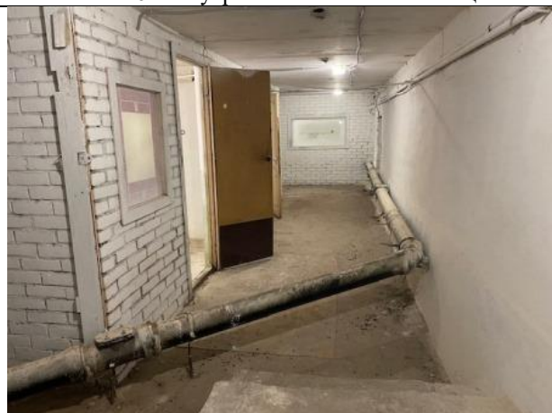
Фото № 12 – Внутреннее состояние помещения
