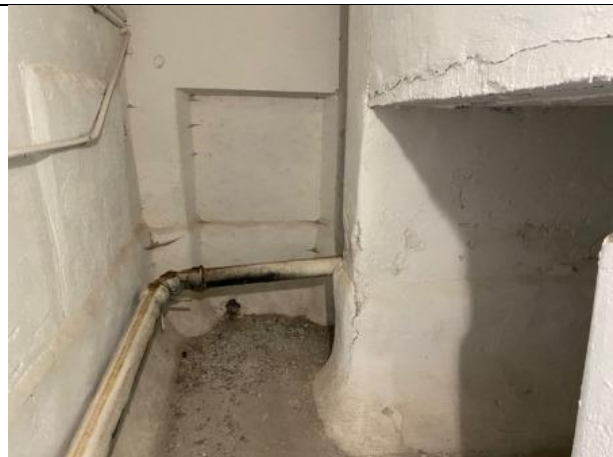
Фото № 8 – Внутреннее состояние помещения
