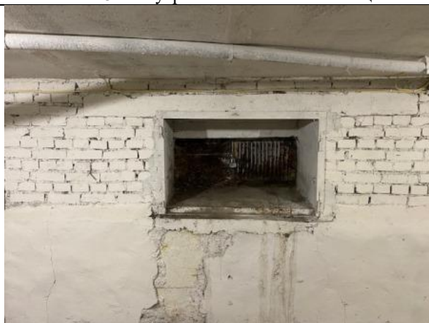
Фото № 27 – Внутреннее состояние помещения
