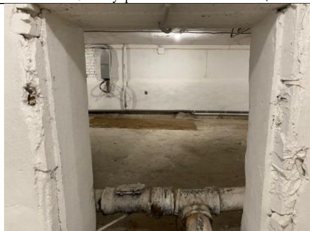
Фото № 20 – Внутреннее состояние помещения
