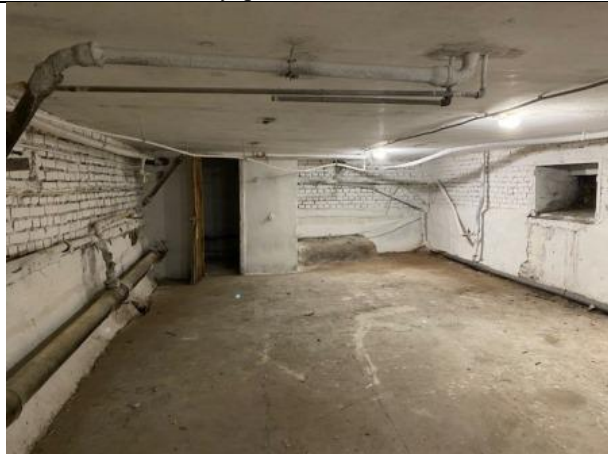
Фото № 25 – Внутреннее состояние помещения
