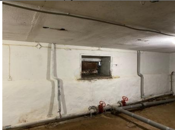
Фото № 26 – Внутреннее состояние помещения
