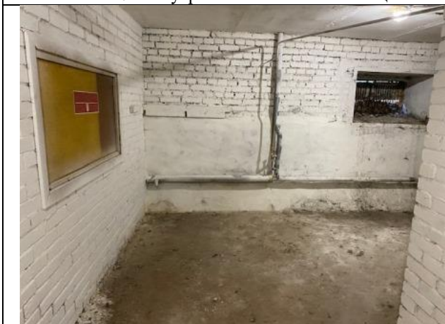
Фото № 19 – Внутреннее состояние помещения
