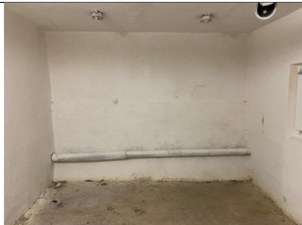
Фото № 16 – Внутреннее состояние помещения
