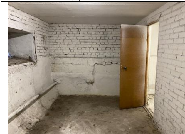
Фото № 21 – Внутреннее состояние помещения
