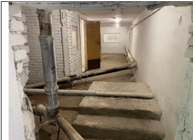
Фото № 7 – Внутреннее состояние помещения
