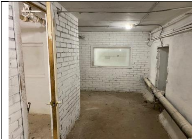
Фото № 15 – Внутреннее состояние помещения
