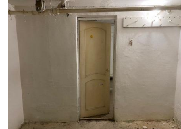
Фото № 17 – Внутреннее состояние помещения
