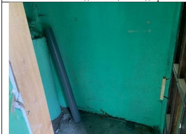
Фото № 5 – Внутреннее состояние помещения
