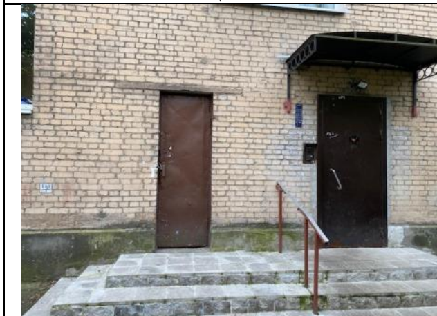
Фото № 3 – Вход в помещение со двора
