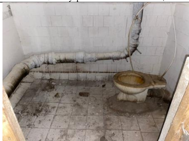
Фото № 28 – Внутреннее состояние помещения
