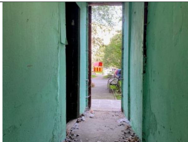
Фото № 4 – Вход в помещение со двора
