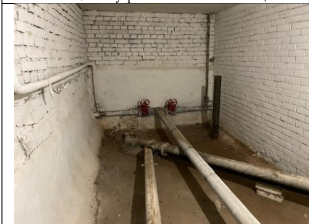
Фото № 11 – Внутреннее состояние помещения
