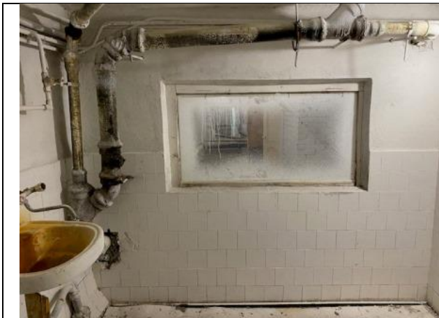
Фото № 23 – Внутреннее состояние помещения
