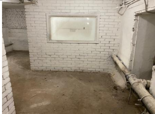
Фото № 18 – Внутреннее состояние помещения
