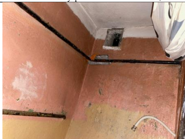
Фото № 26 – Внутреннее состояние помещения
