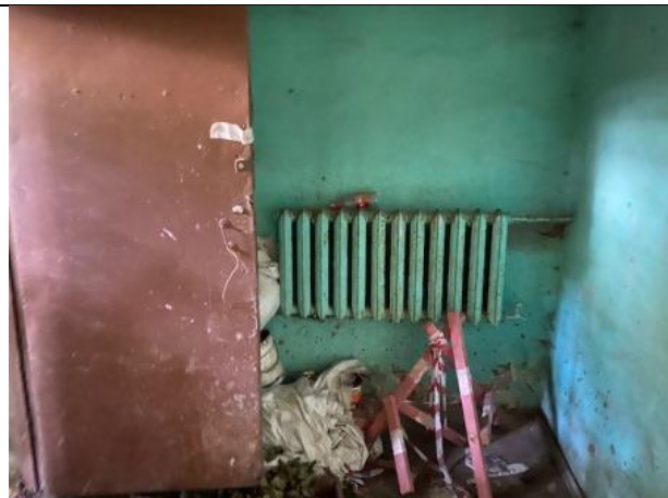
Фото № 6 – Внутреннее состояние помещения
