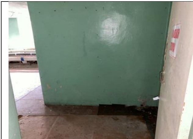
Фото № 13 – Внутреннее состояние помещения
