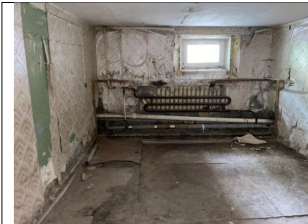
Фото № 21 – Внутреннее состояние помещения
