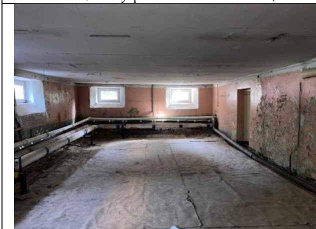
Фото № 17 – Внутреннее состояние помещения
