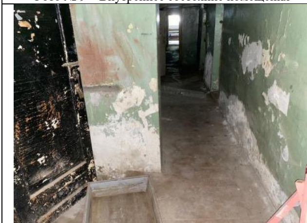
Фото № 11 – Внутреннее состояние помещения
