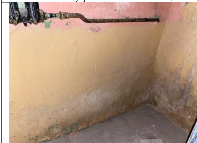
Фото № 25 – Внутреннее состояние помещения
