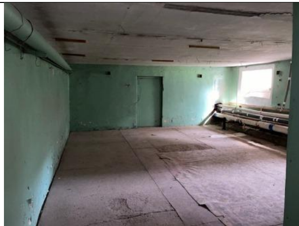
Фото № 14 – Внутреннее состояние помещения
