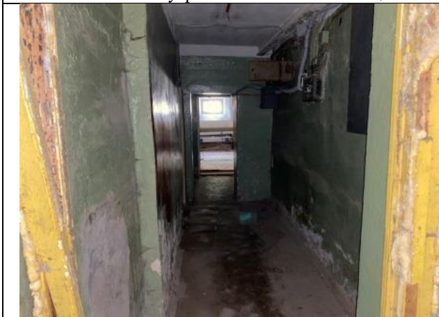
Фото № 15 – Внутреннее состояние помещения
