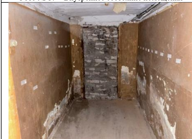
Фото № 19 – Внутреннее состояние помещения
