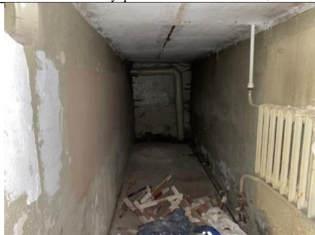
Фото № 8 – Внутреннее состояние помещения
