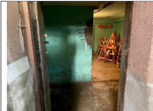
Фото № 5 – Внутреннее состояние помещения
