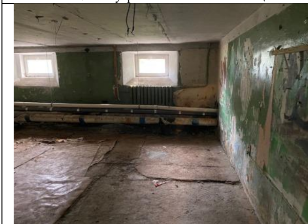
Фото № 9 – Внутреннее состояние помещения
