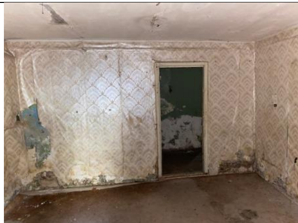
Фото № 22 – Внутреннее состояние помещения
