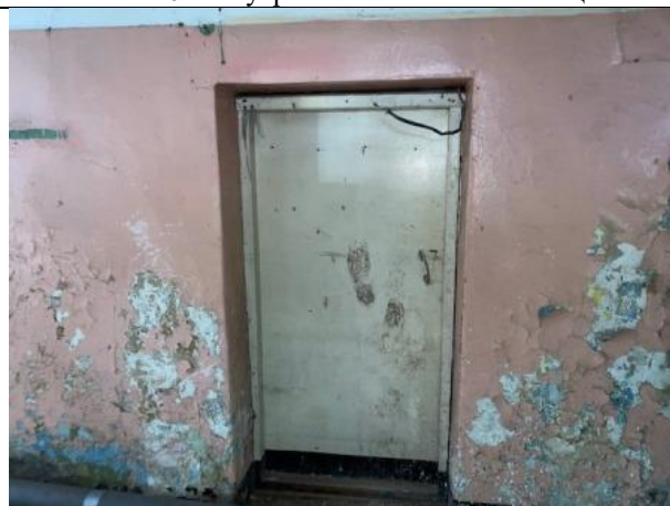
Фото № 18 – Общий вход в помещение
