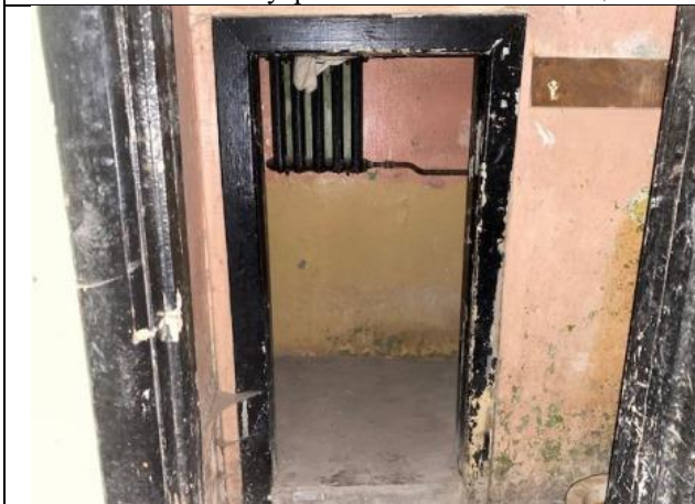
Фото № 23 – Внутреннее состояние помещения
