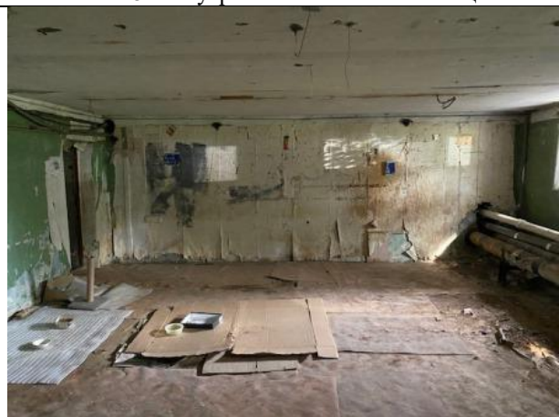
Фото № 10 – Внутреннее состояние помещения
