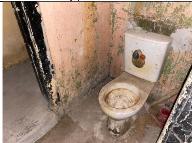
Фото № 24 – Внутреннее состояние помещения
