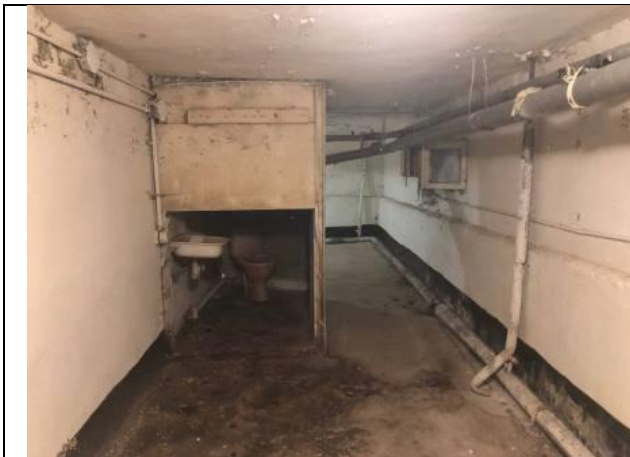
Фото № 15 – Внутреннее состояние помещения
