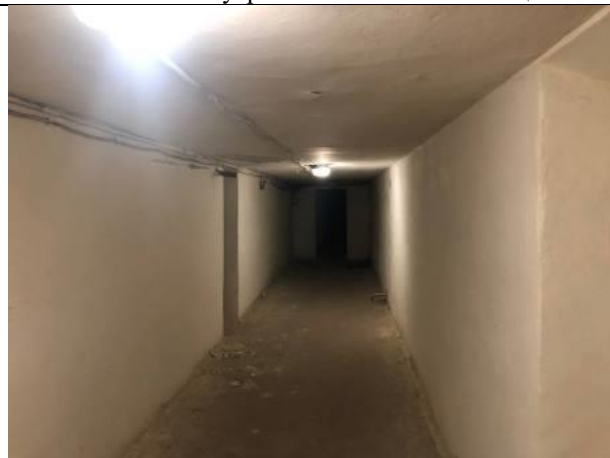
Фото № 28 – Внутреннее состояние помещения
