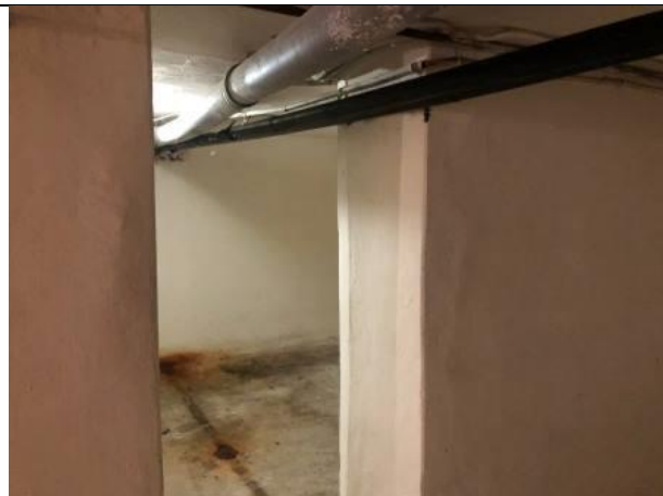
Фото № 24 – Внутреннее состояние помещения
