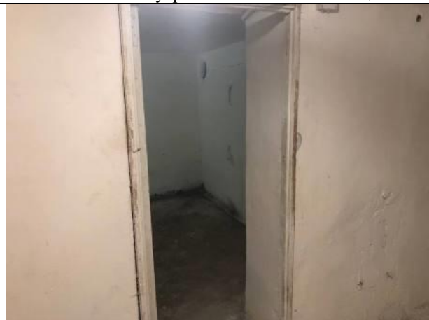
Фото № 18 – Внутреннее состояние помещения
