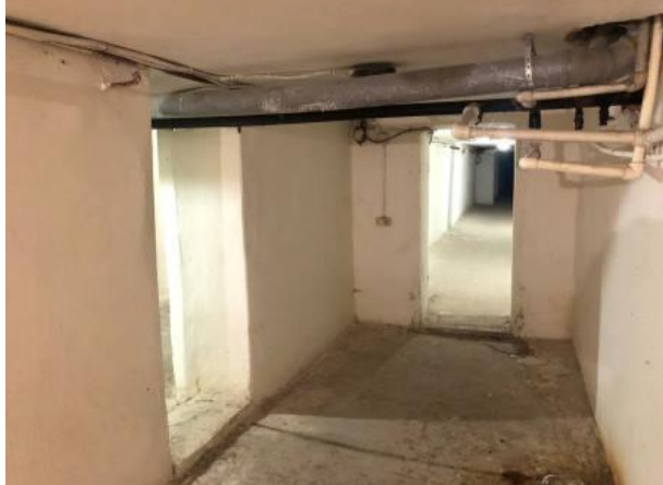
Фото № 25 – Внутреннее состояние помещения
