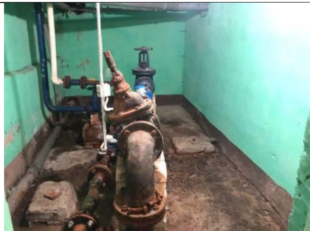
Фото № 16 – Внутреннее состояние помещения
