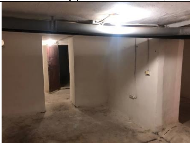
Фото № 27 – Внутреннее состояние помещения
