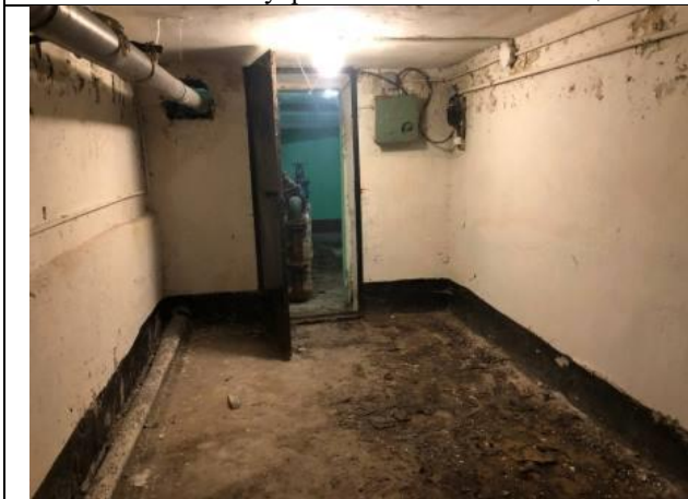
Фото № 17 – Внутреннее состояние помещения
