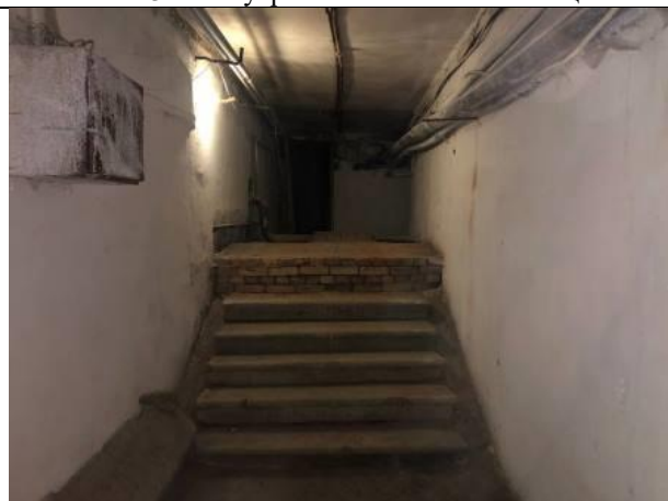
Фото № 36 – Внутреннее состояние помещения
