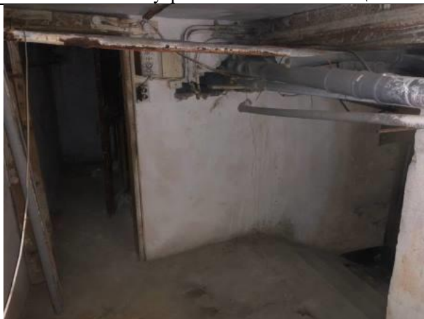
Фото № 37 – Внутреннее состояние помещения
