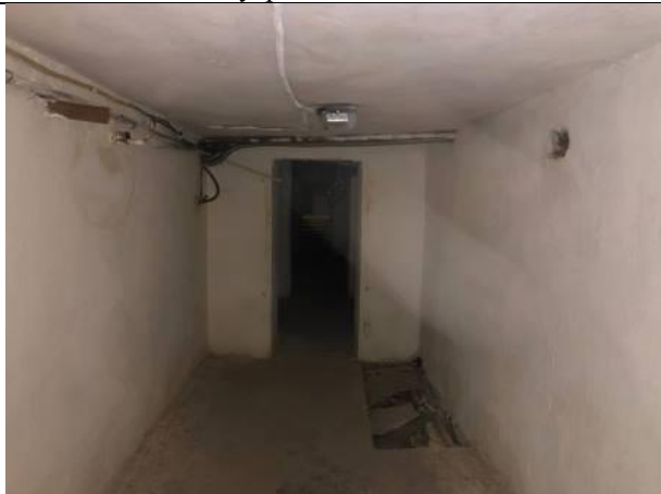
Фото № 29 – Внутреннее состояние помещения
