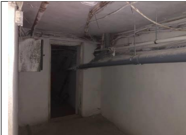
Фото № 31 – Внутреннее состояние помещения
