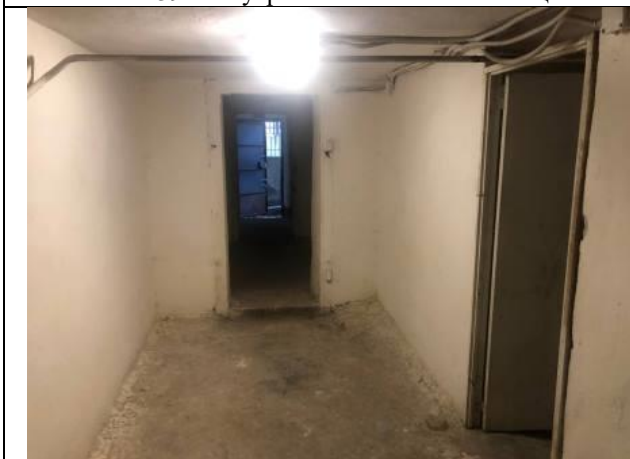
Фото № 41 – Внутреннее состояние помещения
