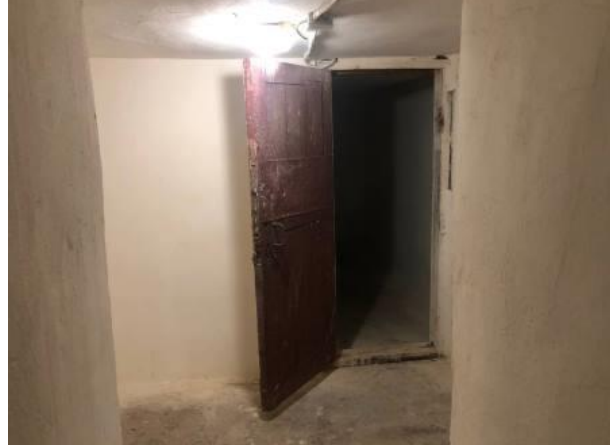
Фото № 26 – Внутреннее состояние помещения
