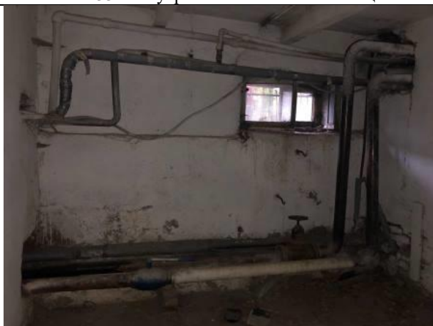
Фото № 35 – Внутреннее состояние помещения
