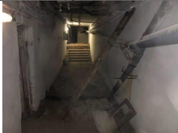
Фото № 34 – Внутреннее состояние помещения
