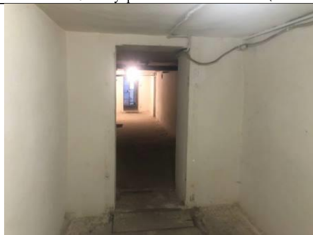
Фото № 42 – Внутреннее состояние помещения
