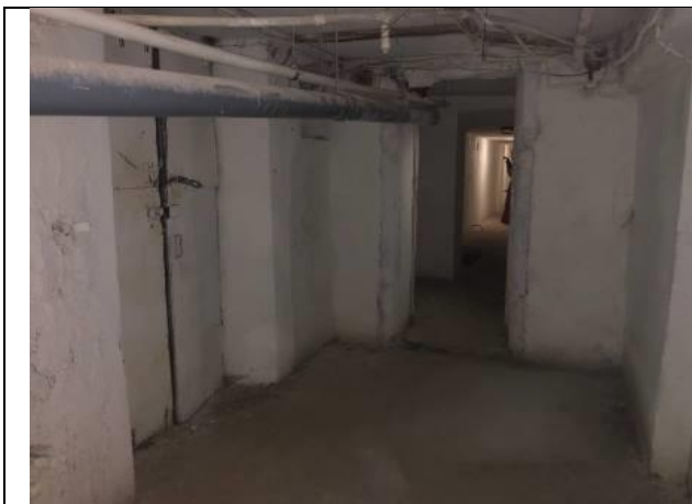
Фото № 39 – Внутреннее состояние помещения
