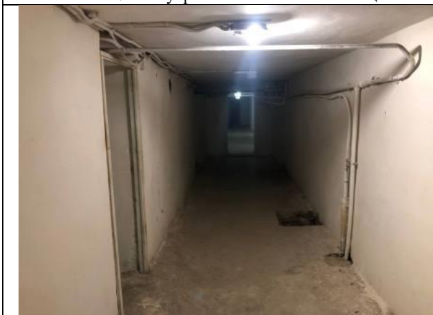
Фото № 19 – Внутреннее состояние помещения
