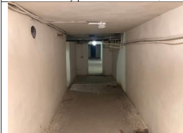
Фото № 21 – Внутреннее состояние помещения
