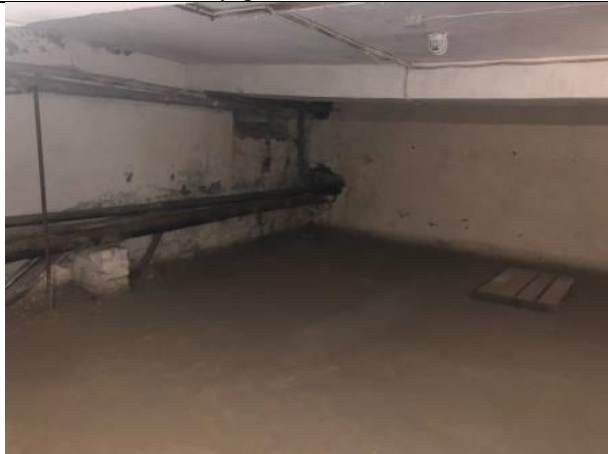
Фото № 33 – Внутреннее состояние помещения
