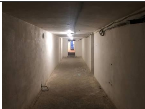
Фото № 40 – Внутреннее состояние помещения
