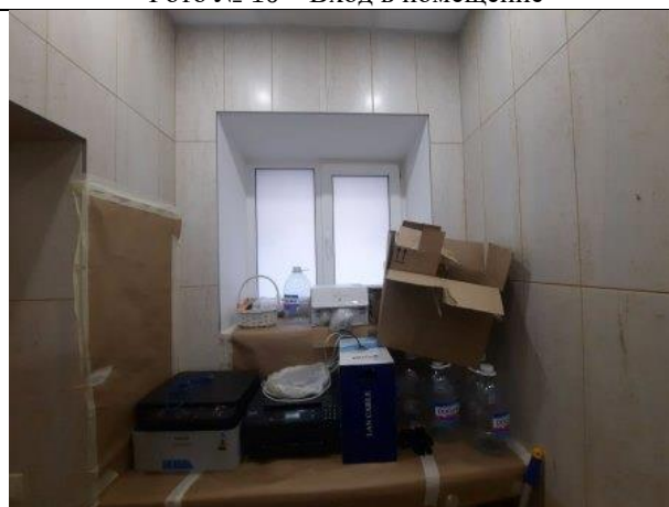
Фото № 12 – Внутреннее состояние помещения
