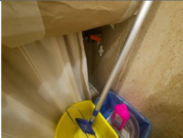
Фото № 15 – Внутреннее состояние помещения
