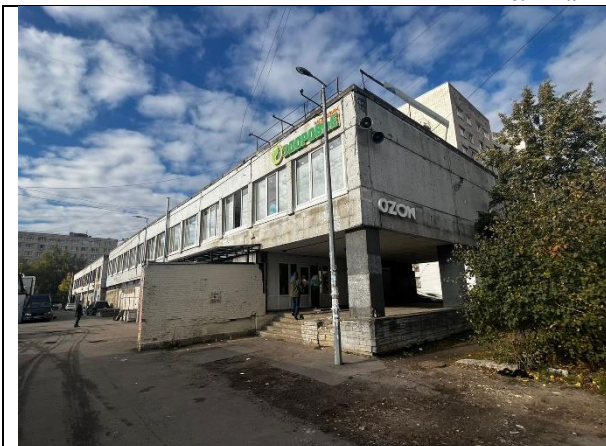
Фото 1. Вид здания, в котором расположен Объект оценки
