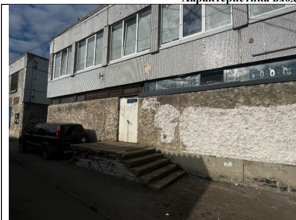
Фото 3. Отдельный вход со двора, окна Объекта оценки
