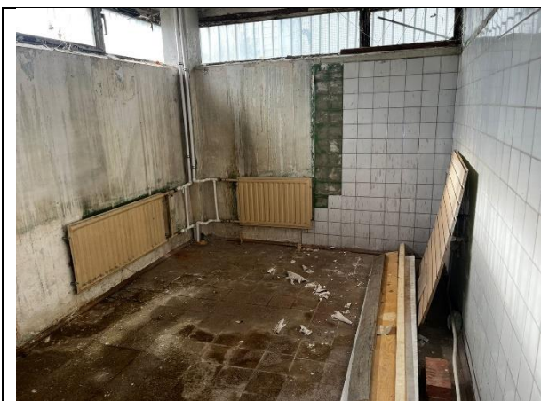
Фото 7. Внутреннее состояние Объекта оценки
