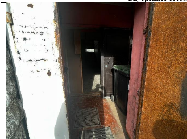
Фото 5. Внутреннее состояние Объекта оценки
