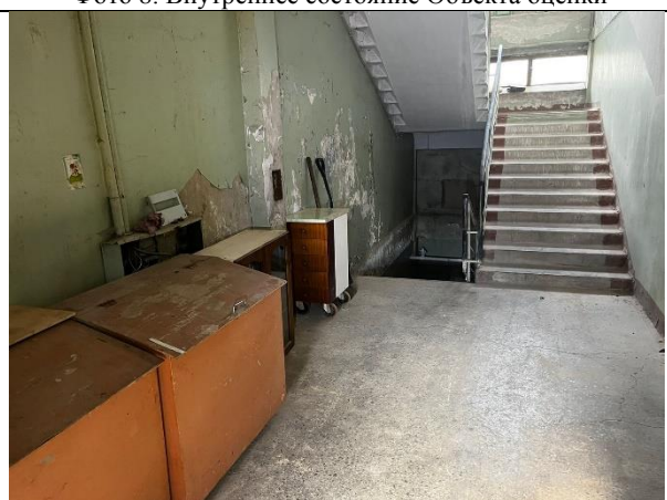
Фото 10. Внутреннее состояние Объекта оценки
