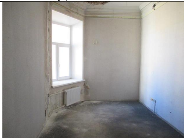
Фото № 24 – Внутреннее состояние помещения 10-Н
