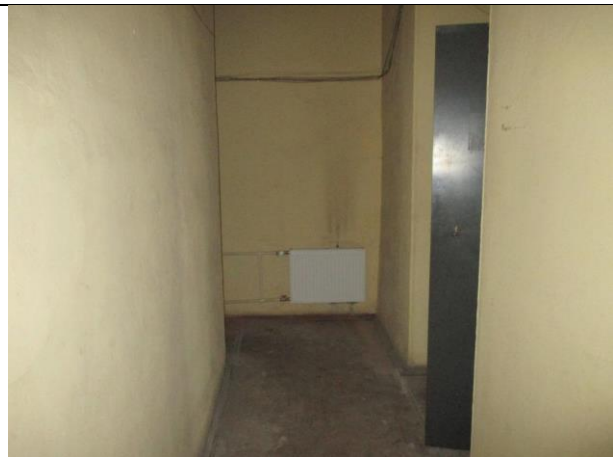
Фото № 14 – Внутреннее состояние помещения 10-Н
