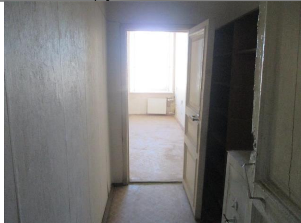
Фото № 56 – Внутреннее состояние помещения 12-Н
