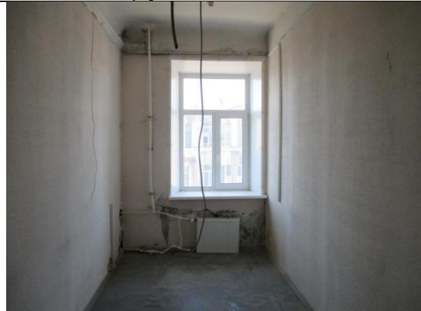
Фото № 48 – Внутреннее состояние помещения 12-Н
