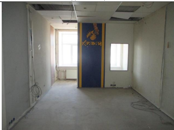
Фото № 43 – Внутреннее состояние помещения 12-Н
