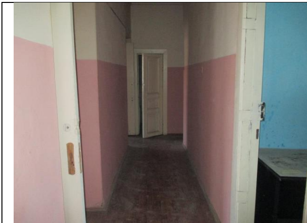
Фото № 29 – Внутреннее состояние помещения 13-Н
