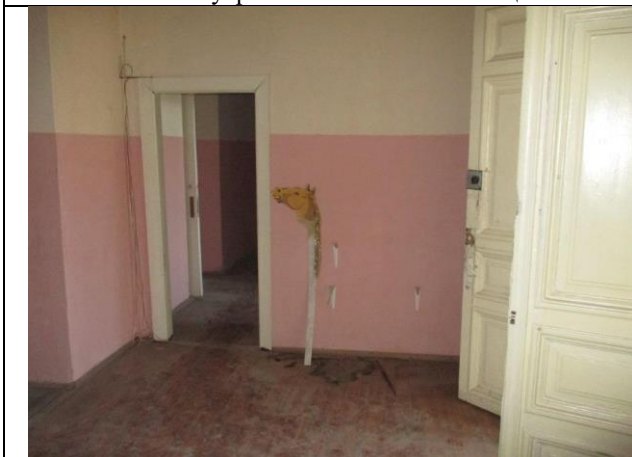
Фото № 27 – Внутреннее состояние помещения 13-Н
