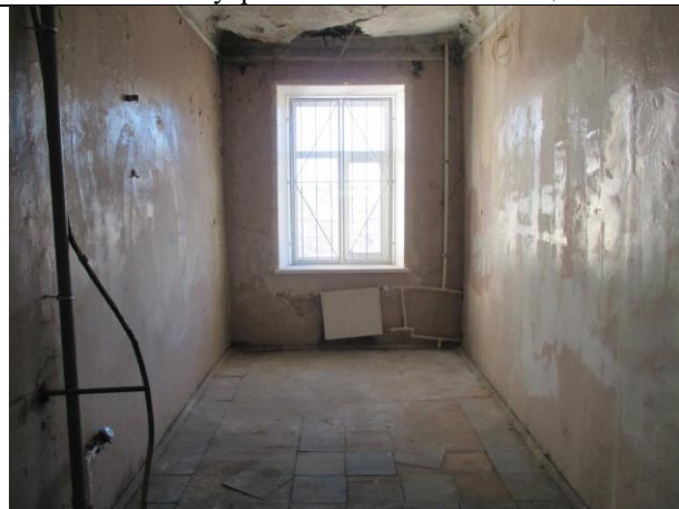
Фото № 32 – Внутреннее состояние помещения 13-Н
