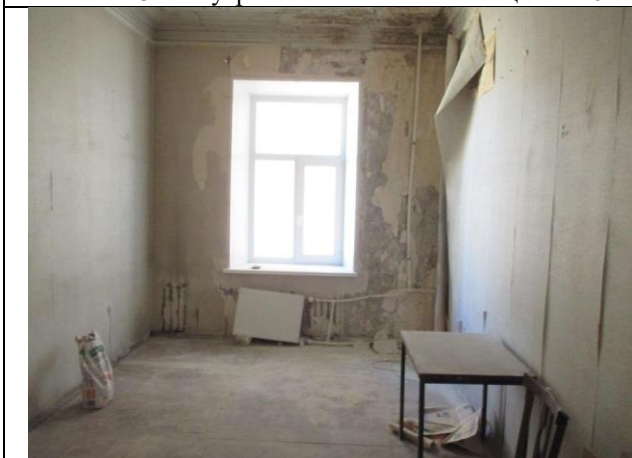
Фото № 25 – Внутреннее состояние помещения 10-Н
