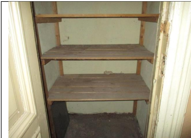
Фото № 53 – Внутреннее состояние помещения 12-Н
