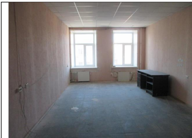
Фото № 37 – Внутреннее состояние помещения 13-Н
