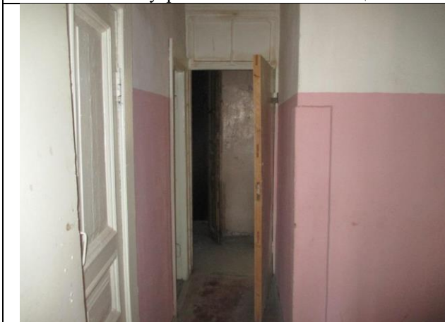
Фото № 31 – Внутреннее состояние помещения 13-Н
