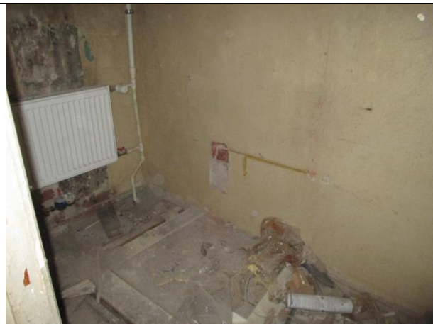
Фото № 22 – Внутреннее состояние помещения 10-Н
