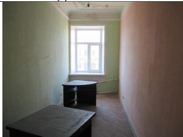
Фото № 40 – Внутреннее состояние помещения 13-Н
