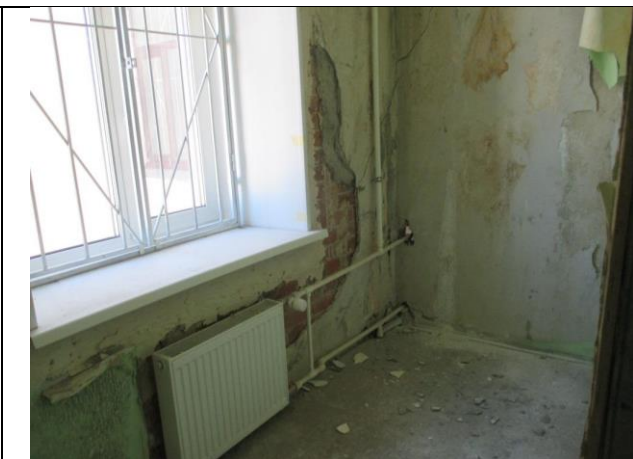
Фото № 62 – Внутреннее состояние помещения 12-Н
