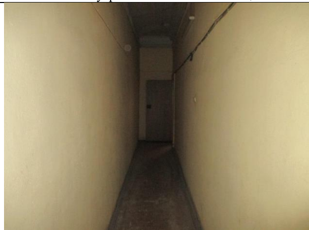
Фото № 16 – Внутреннее состояние помещения 10-Н
