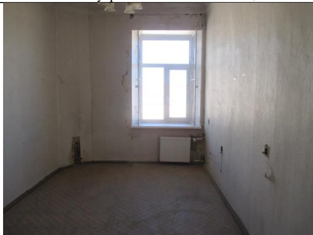
Фото № 57 – Внутреннее состояние помещения 12-Н
