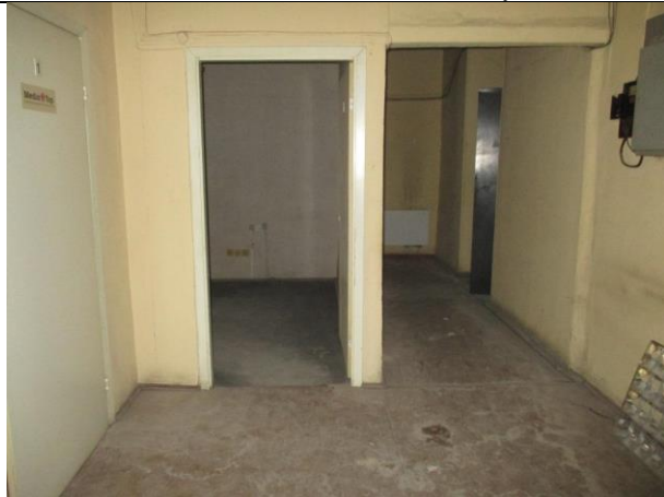
Фото № 9 – Внутреннее состояние помещения 10-Н
