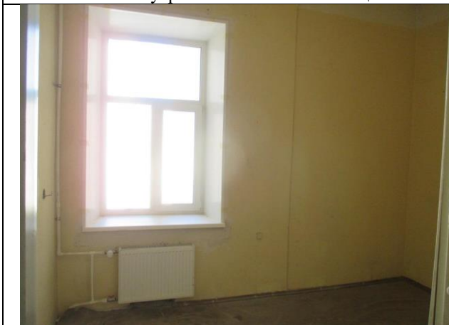
Фото № 19 – Внутреннее состояние помещения 10-Н
