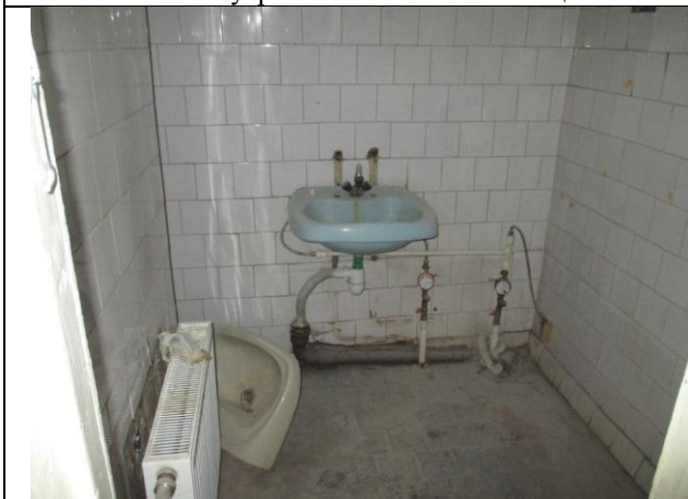
Фото № 35 – Внутреннее состояние помещения 13-Н
