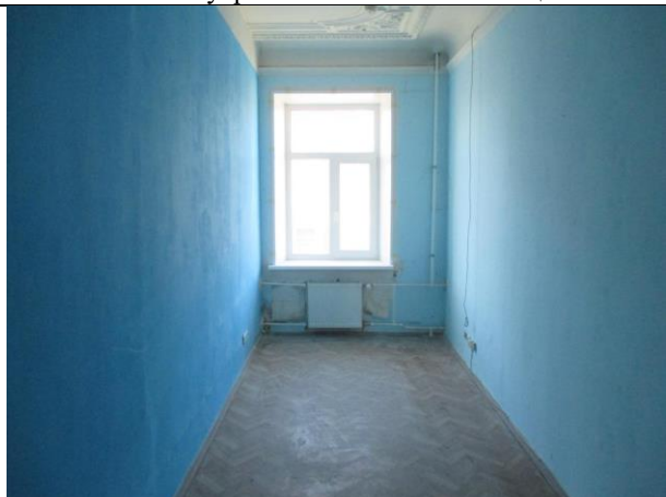
Фото № 39 – Внутреннее состояние помещения 13-Н
