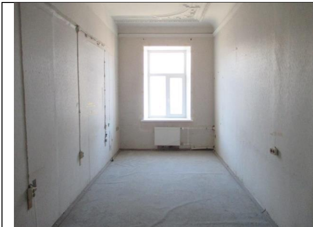
Фото № 13 – Внутреннее состояние помещения 10-Н
