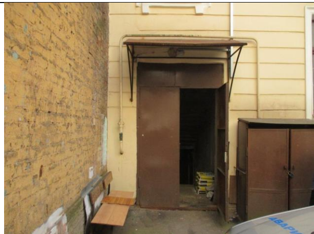
Фото № 6 – Вход в помещение со двора
