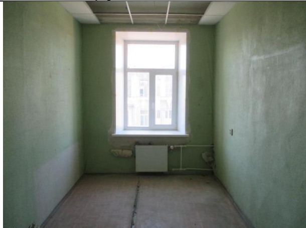
Фото № 47 – Внутреннее состояние помещения 12-Н
