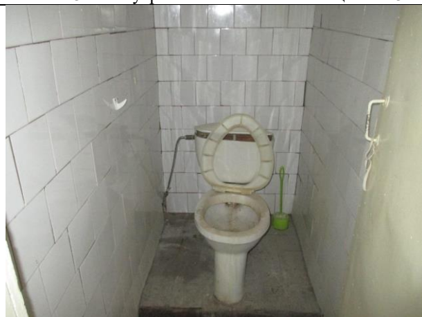
Фото № 34 – Внутреннее состояние помещения 13-Н
