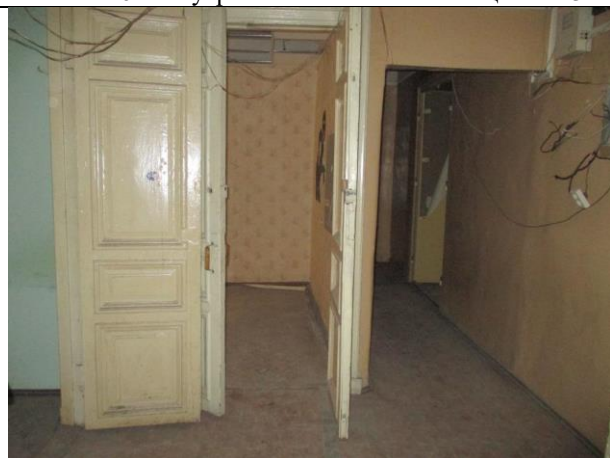
Фото № 42 – Внутреннее состояние помещения 12-Н
