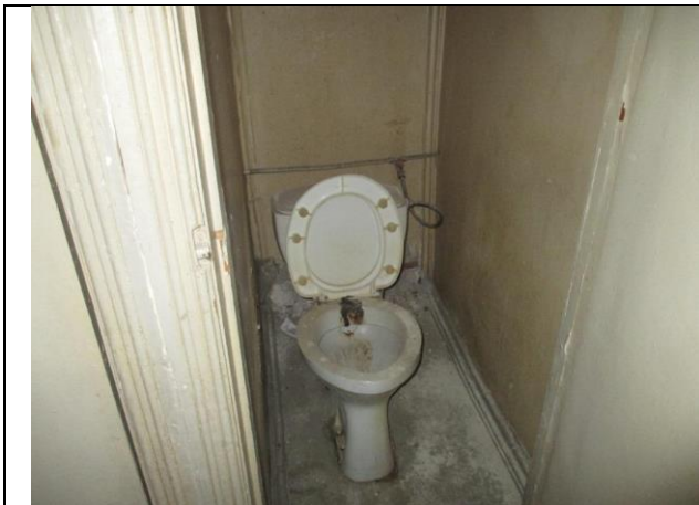
Фото № 21 – Внутреннее состояние помещения 10-Н
