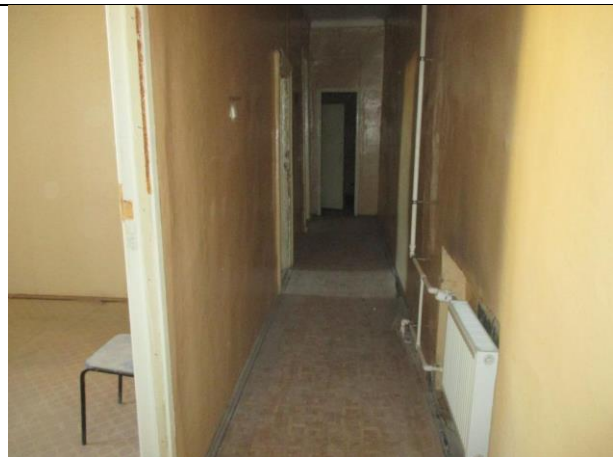
Фото № 54 – Внутреннее состояние помещения 12-Н
