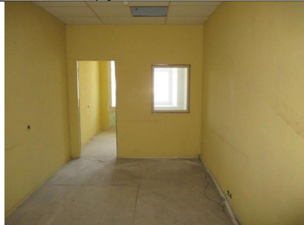
Фото № 50 – Внутреннее состояние помещения 12-Н
