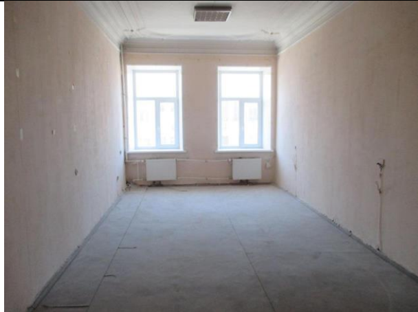
Фото № 11 – Внутреннее состояние помещения 10-Н
