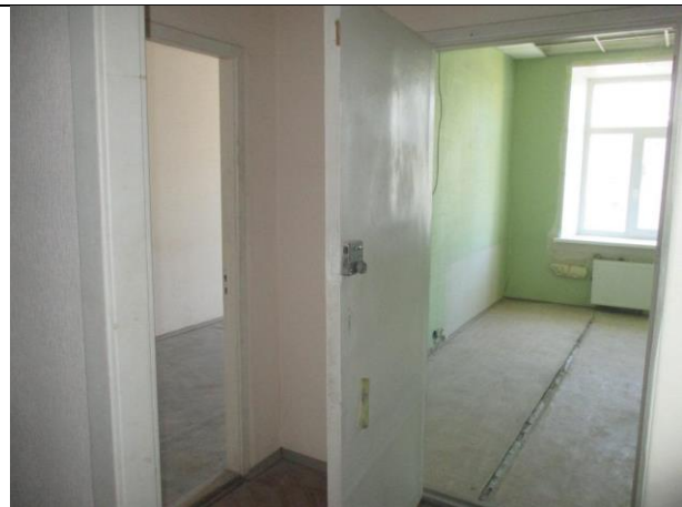
Фото № 46 – Внутреннее состояние помещения 12-Н
