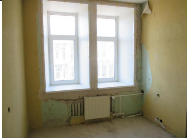
Фото № 51 – Внутреннее состояние помещения 12-Н
