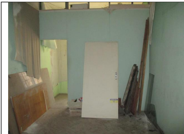
Фото № 61 – Внутреннее состояние помещения 12-Н
