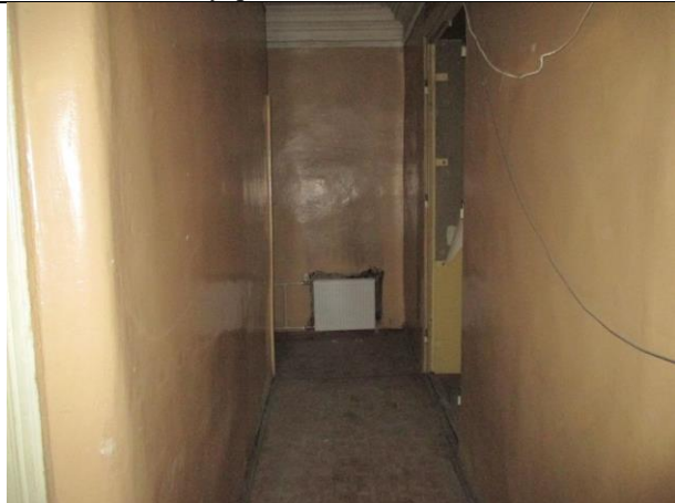
Фото № 49 – Внутреннее состояние помещения 12-Н
