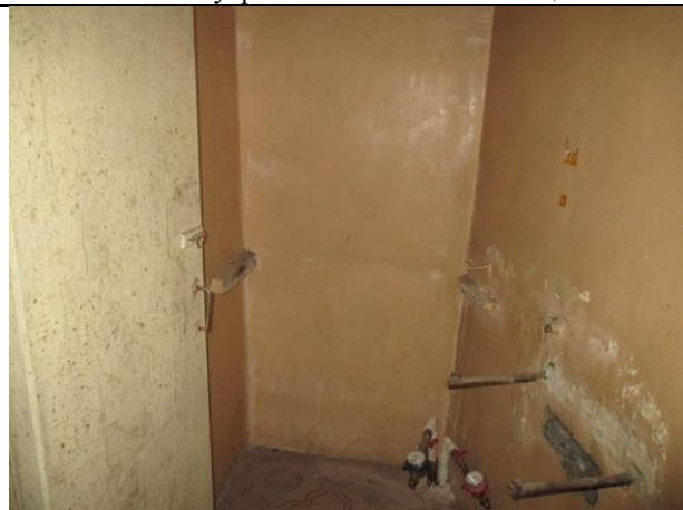
Фото № 58 – Внутреннее состояние помещения 12-Н
