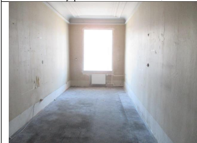
Фото № 15 – Внутреннее состояние помещения 10-Н
