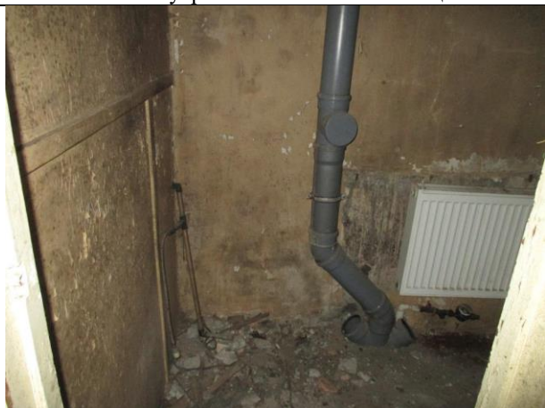
Фото № 59 – Внутреннее состояние помещения 12-Н
