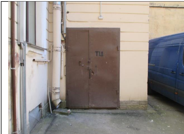
Фото № 5 – Вход в помещение со двора
