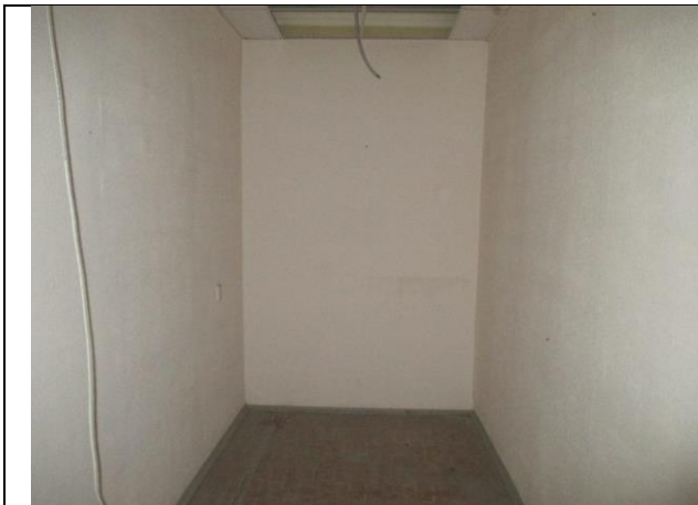
Фото № 45 – Внутреннее состояние помещения 12-Н
