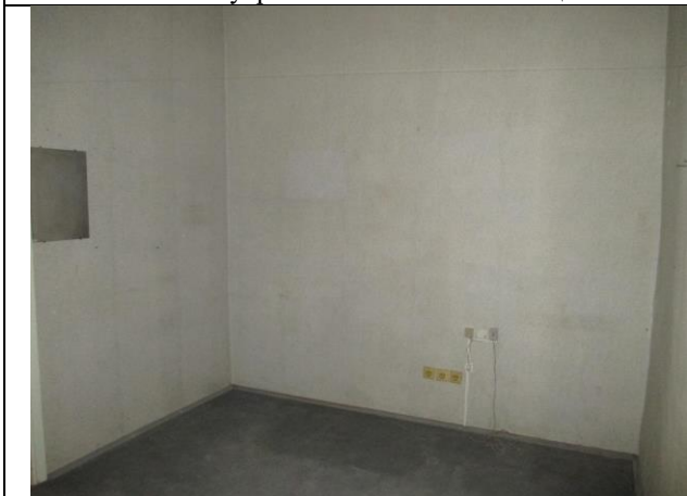
Фото № 23 – Внутреннее состояние помещения 10-Н
