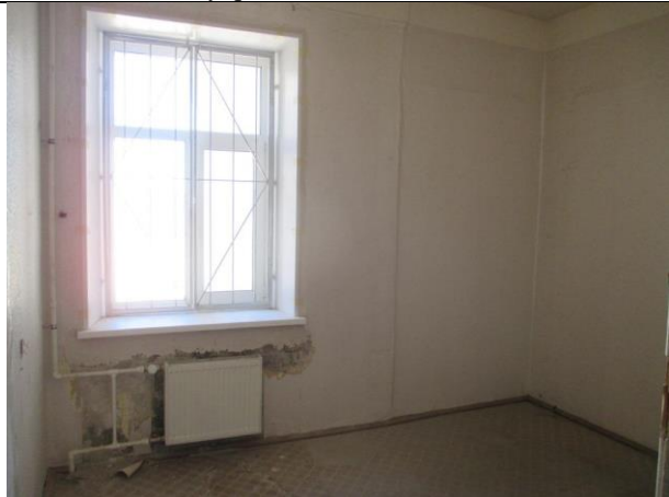
Фото № 55 – Внутреннее состояние помещения 12-Н
