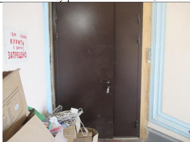
Фото № 26 – Вход в помещении 13-Н 5 этаж
