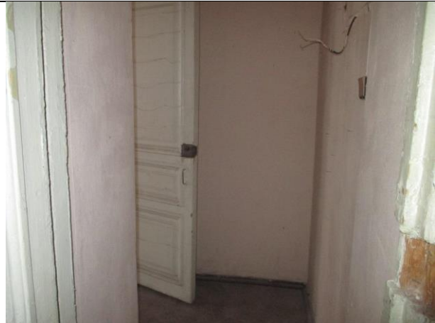
Фото № 10 – Внутреннее состояние помещения 10-Н
