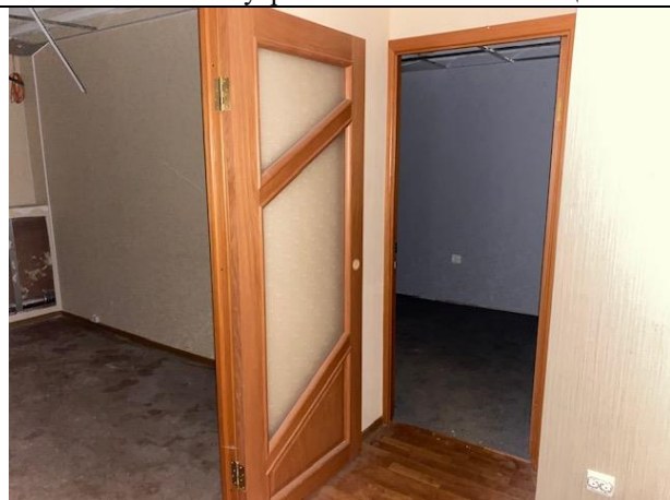
Фото № 24 – Внутреннее состояние помещения
