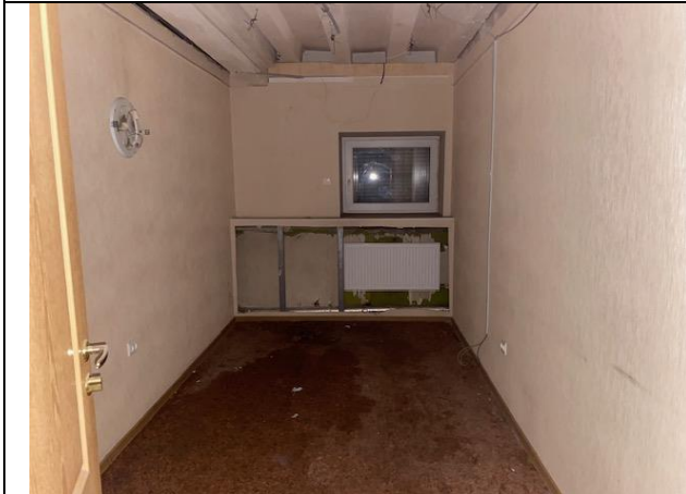
Фото № 29 – Внутреннее состояние помещения
