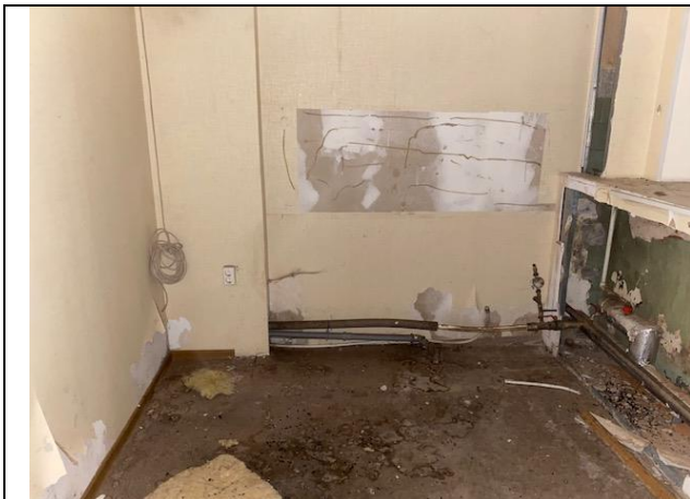
Фото № 11 – Внутреннее состояние помещения
