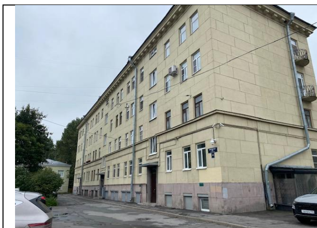
Фото № 1 – Здание, в котором находится Объект оценки
