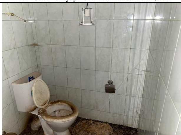
Фото № 16 – Внутреннее состояние помещения
