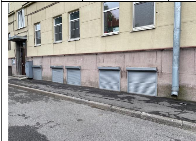
Фото № 5 – Окна помещения
