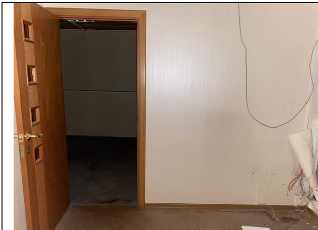
Фото № 19 – Внутреннее состояние помещения
