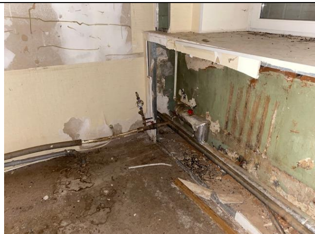
Фото № 12 – Внутреннее состояние помещения
