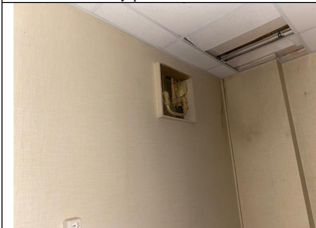
Фото № 13 – Внутреннее состояние помещения
