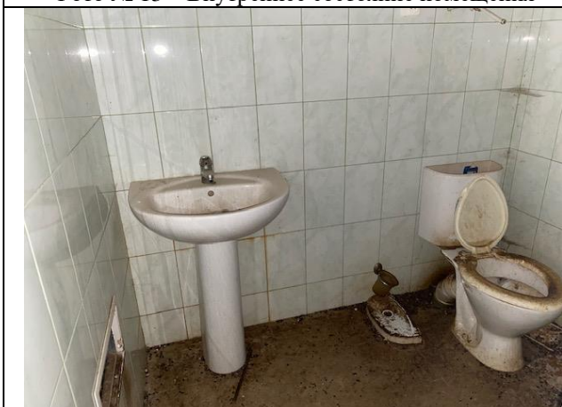
Фото № 15 – Внутреннее состояние помещения
