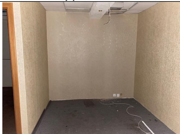
Фото № 22 – Внутреннее состояние помещения
