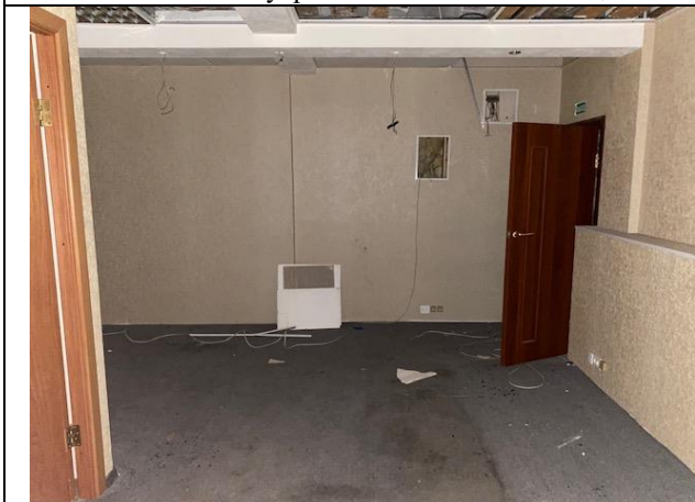
Фото № 21 – Внутреннее состояние помещения
