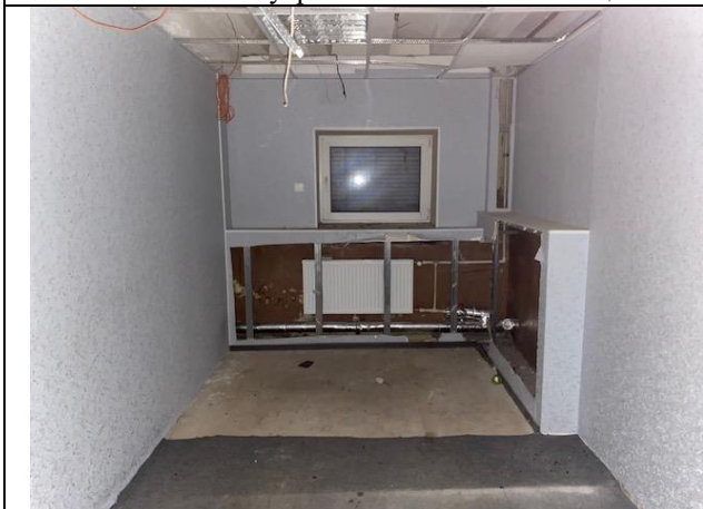
Фото № 25 – Внутреннее состояние помещения
