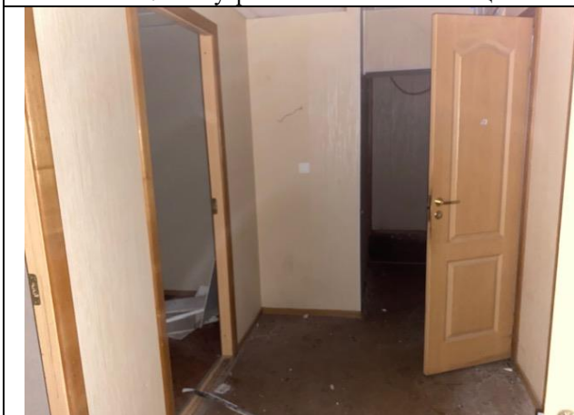
Фото № 9 – Внутреннее состояние помещения
