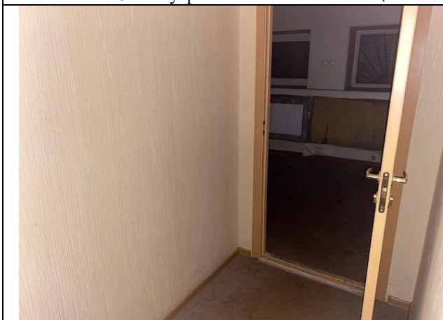
Фото № 17 – Внутреннее состояние помещения
