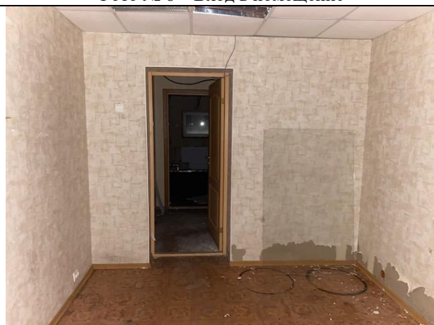
Фото № 8 – Внутреннее состояние помещения
