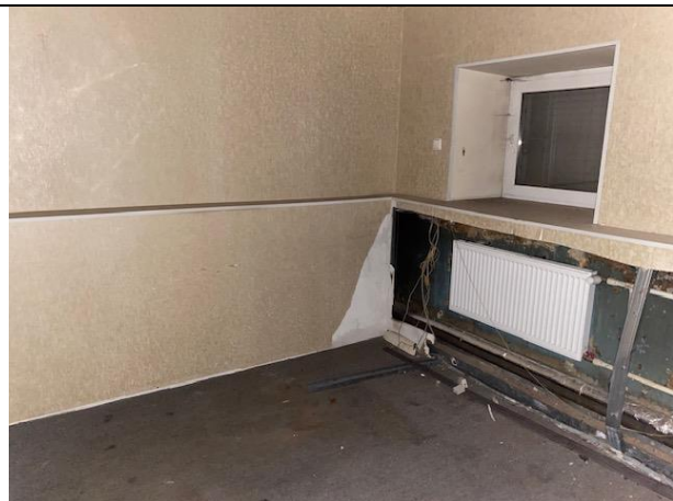
Фото № 20 – Внутреннее состояние помещения
