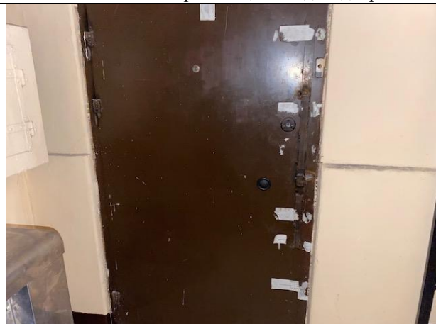
Фото № 6 – Вход в помещение
