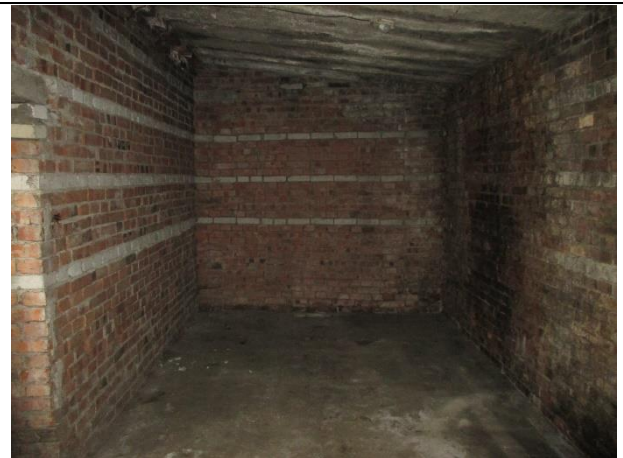
Фото № 12. Внутреннее состояние здания
