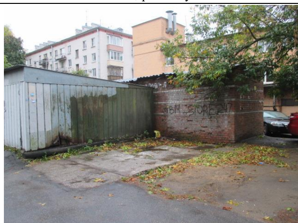
Фото № 5. Внешний вид здания
