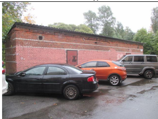
Фото № 4. Внешний вид здания
